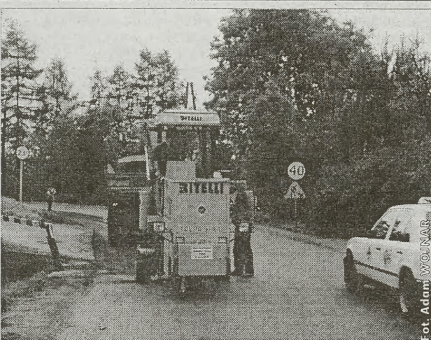
Remont ul. Królowej Jadwigi
