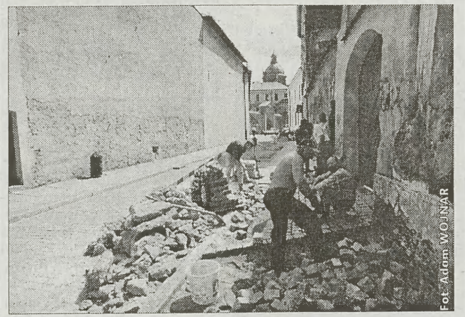
Poselska rozkopana — będzie nowy chodnik
