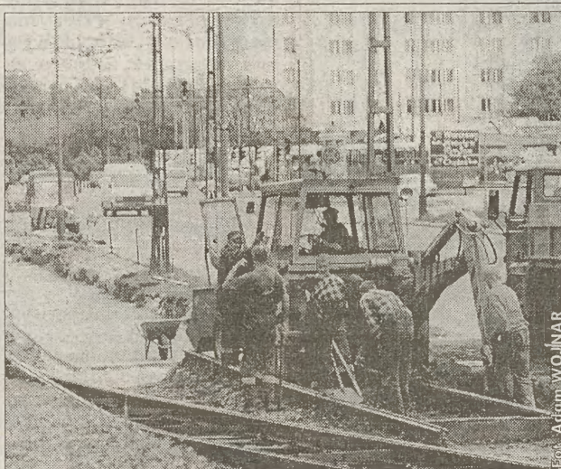
Remont torowiska przy ul. Brożka
