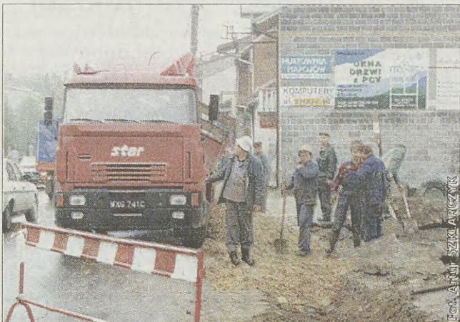
Remont ulicy 3 Maja podzielił mieszkańców Proszowic, jednak bez względu na zdania, wszyscy nie mogą się już doczekać zakończenia prac
