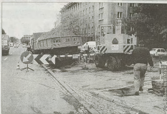
Prace na zakopanie
