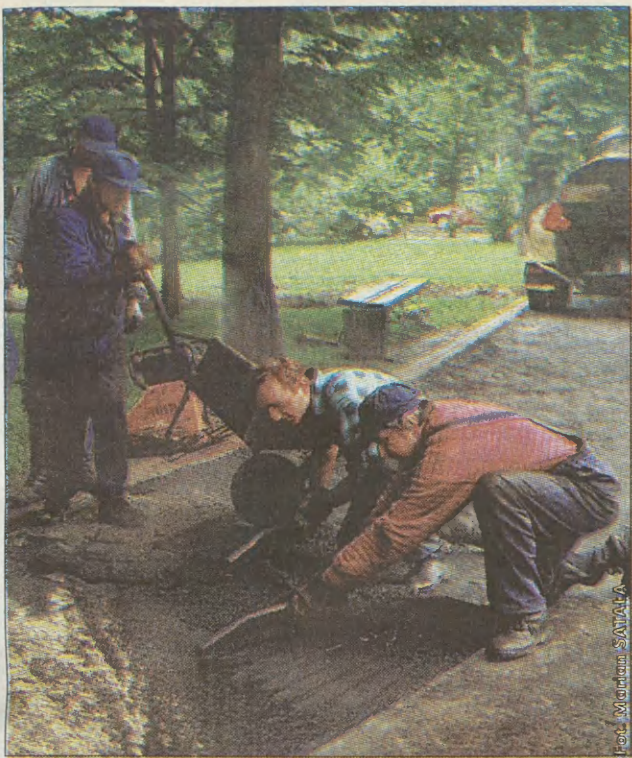
Na Plantach, między ulicami Sienną i Dominikańską, trwa remont nawierzchni alejek spacerowych. Załoga Rejonu Dróg Miejskich zrobiła nową podbudowę alejek, wczoraj przez cały dzień, nie zważając na deszcz, asfaltowała alejki, które po obu stronach ograniczone zostały krawężnikiem z kostki brukowej. Po zakończeniu prac trakty będą gładkie jak stół. (mas)
