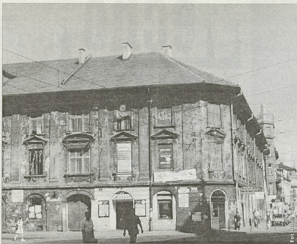
Stara kamienica przy ul. Krakowskiej od lat nieremontowana niszczeje. Kto jest jej właścicielem i kto ma się podjąć jej ewentualnego remontu, do dziś nie wiadomo. Najgorzej, że w tej sytuacji i wyburzyć jej nie sposób
