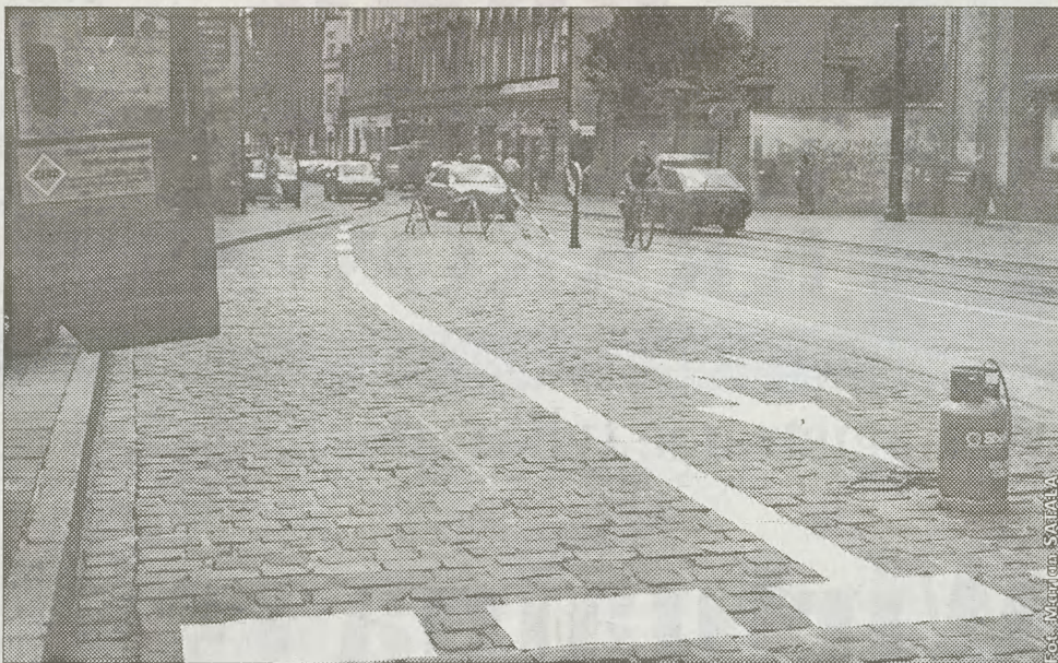
Na ul. Zwierzynieckiej ekipa Zakładu Zabezpieczenia Ruchu Drogowego robiła wczoraj trwałe oznakowanie na kostce brukowej, która wyłożona jest na jezdni przy skrzyżowaniu z ul. Straszewskiego. Specjalne tworzywo sztuczne, pod wpływem wysokiej temperatury, spaja się ściśle z podłożem. Nie ma potem problemu z częstym malowaniem strzałek, linii i przejść dla pieszych. (mas)
