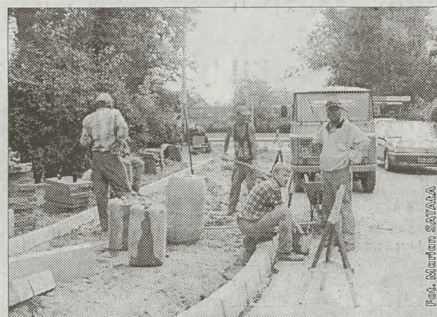
Ekipa firmy „Bomax” remontuje 70-metrowy odcinek chodnika przy ul. Lucjana Rydla. Wymieniono krawężniki i obrzeża oddzielające chodnik od jezdni i zieleńca. Stare, połamane płytki wyniesione zostaną na nowe. (mas)
