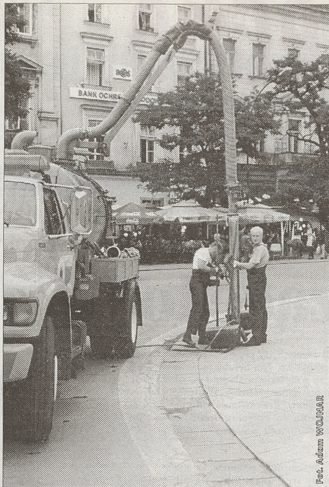
„Zielony smok” na Rynku Głównym. Ta supernowoczesna maszyna służy do czyszczenia miejskiej sieci kanalizacyjnej
