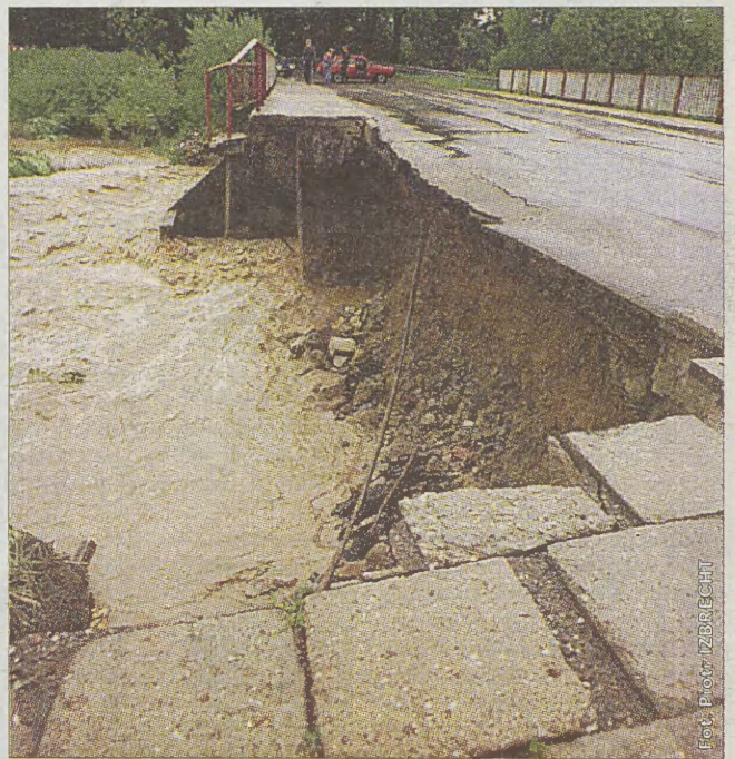
Zerwany przyczółek mostu na trasie do Polanicy Zdroju
