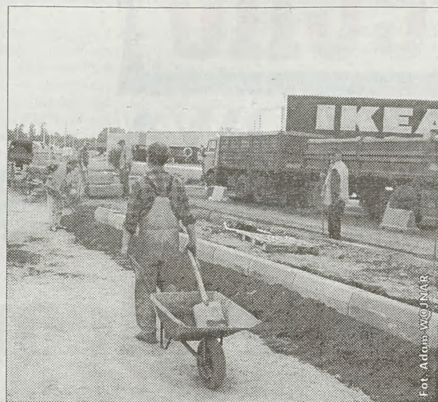
Prace przy ul. Conrada
