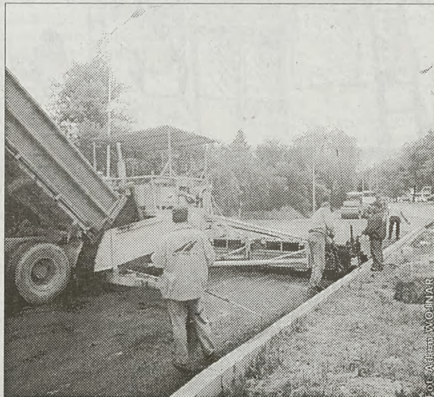
Trwają prace przy budowie drugiej nitki ul. Lublańskiej
