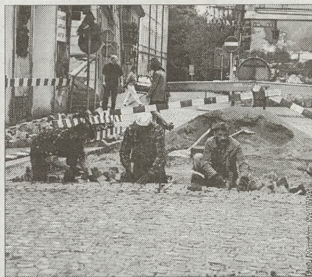
Remont ulicy Poselskiej
