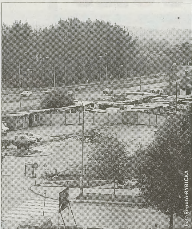
Remont placu osiedlowego na Woli Duchackiej
