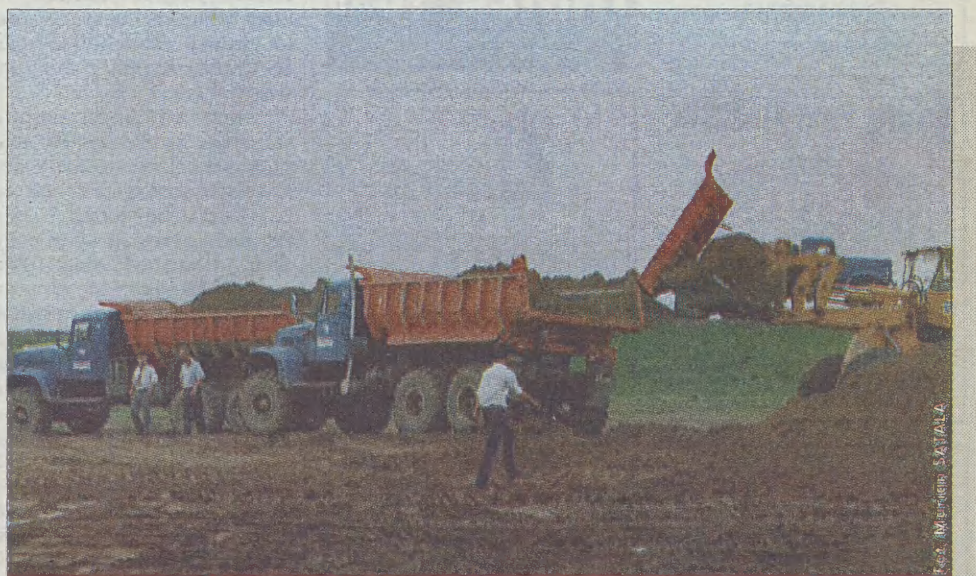
Trwa remont wałów wiślanych, zniszczonych przez ubiegłoroczną powódź. Dogęszczono i podwyższono wały o około 80 cm na Dłubni. W rejonie Rybitw i Przewozu pracuje firma z Grodziska Mazowieckiego remontująca 2-kilometrowy odcinek. Zrzeszotniały wały dogęszcza się specjalnie przebadaną przez geologów ziemią i ubija ogromnym walcem wibracyjnym. W najbardziej zagrożonych miejscach buduje się tzw. ławeczki czyli ziemne umocnienia wzmacniające skarpy. (mas)
