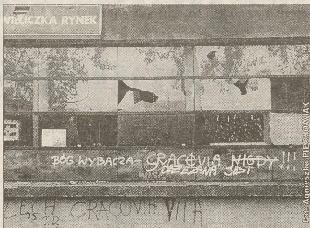
Wieliczka. Zamknięta stacja PKP niszczy. Bóg może wybacz, ale dlaczego taki zaniedbany budynek tolerują w centrum miasta mieszkańcy Wieliczki?
