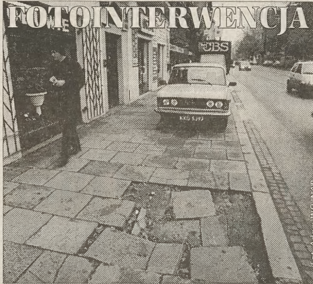
Kraków, ul. Starowiślna
