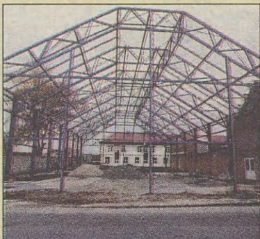
Zespół Szkół Średnich w Niepołomicach – budowa hali sportowej
