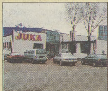
Zakład JUKA przy ul. Fabrycznej
