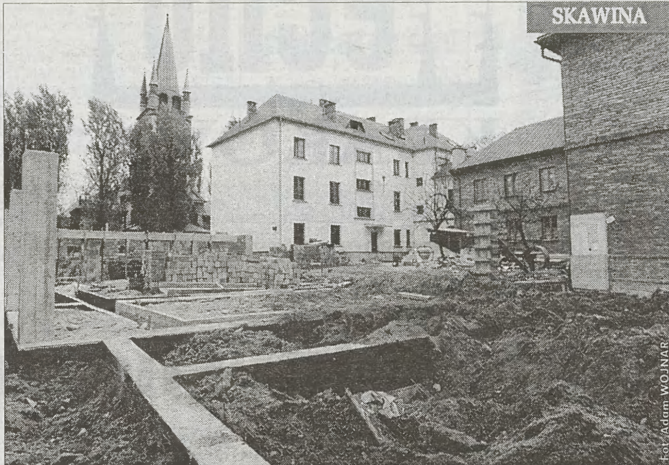
Od kilku tygodni, w pobliżu kościoła w Skawinie, powstaje nowoczesna sala gimnastyczna Liceum Ogólnokształcącego im. Jana Pawła II. Na razie jednak wszyscy, którzy wybiorą się w tamte rejony na spacer mogą podziwiać tylko plac budowy. Sala na razie „wychodzi z ziemi”. (JOK)
