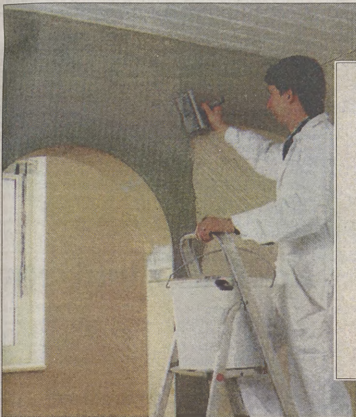
Gruntowanie ścian wzmacnia je, usuwa osypliwość i zmniejsza nasiąkliwość
