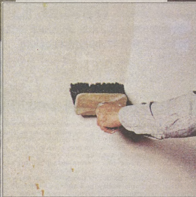
Gruntowanie ścian wzmacnia je, usuwa osypliwość i zmniejsza nasiąkliwość
