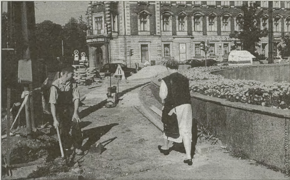
Nad przejściem podziemnym obok Dworca Głównego dobiegają prace przy chodniku łączącym przystanek autobusowy przy ul. Pawiej z przystankiem tramwajowym przy ul. Lubicz. Dotychczas piesi skracali sobie drogę przechodząc przez trawnik
