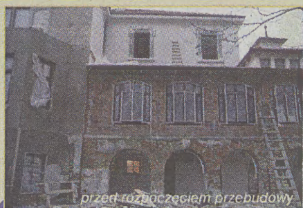
przed rozpoczęciem przebudowy
