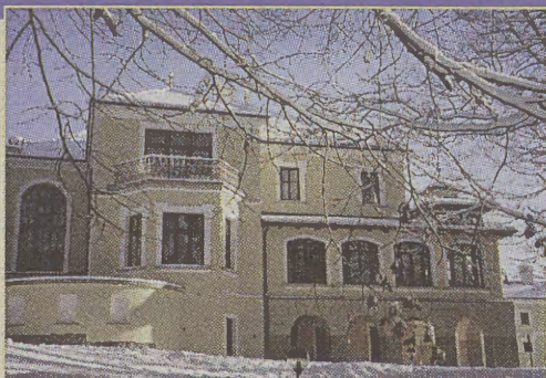
po zakończeniu prac budowlanych
