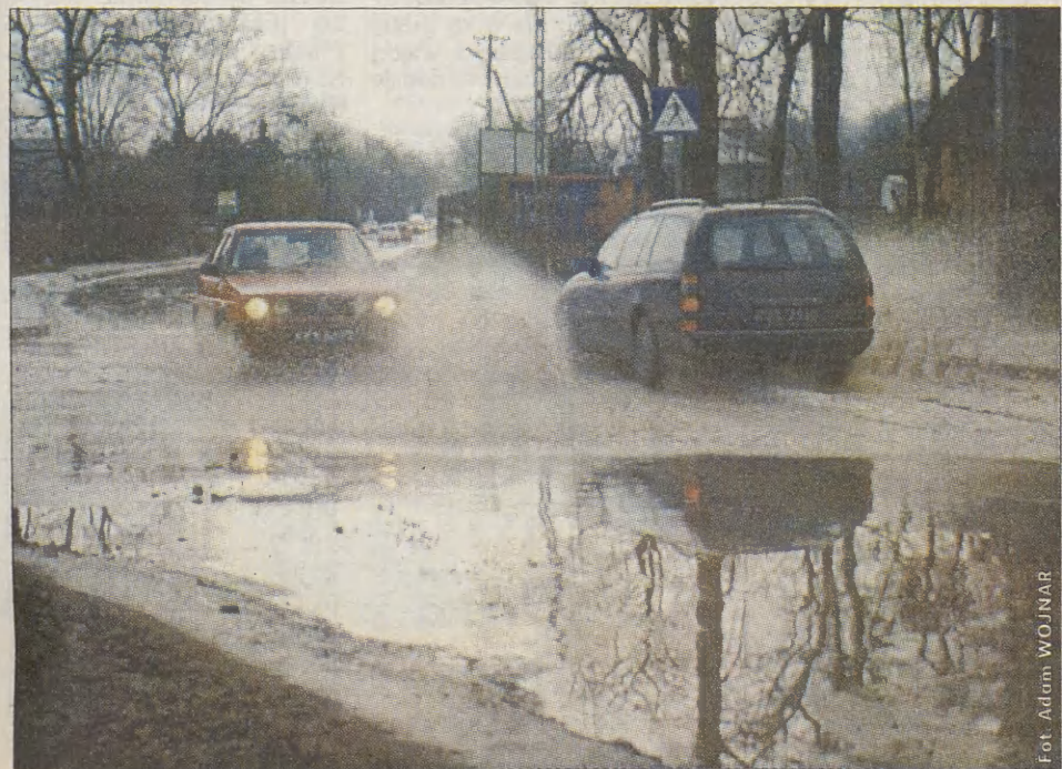
Awarii wodociągów w tym roku mniej. Bo i zima lekka. Wczorajsza, na ul. Królowej Jadwigi, to wynik skorodowanej magistrali na odcinku Strzelnica – Park Decjusza. Mieszkańcy kilka godzin byli bez wody, kierowcy z trudem pokonywali zalaną drogę... (AW)
