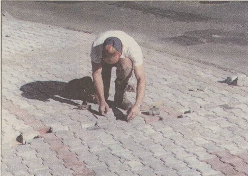
Układanie płytek brukowych nie jest takie proste
