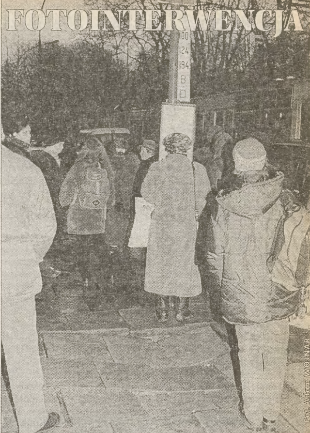
Kraków, ul. Dunajewskiego, przystanek autobusowy. Jeden niefortunny krok i... można znaleźć się w szpitalu. Niestety, takich czyhających na nas na chodnikach zapadłisk, zamiast ubywać, przybywa
