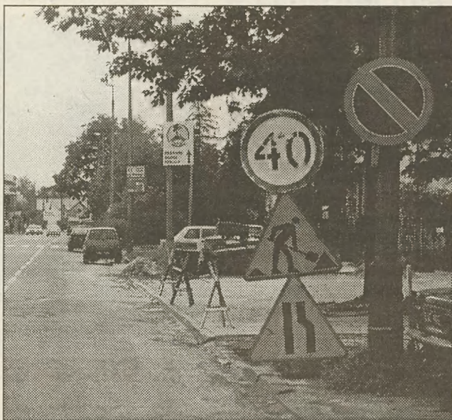
Przy ul. Bronowickiej na prawym pasie ruchu dla kierowców jadących w stronę Bronowic Nowych, ustawiono znak ograniczenia prędkości do 40 km. Kończą się prace przy układaniu chodnika
