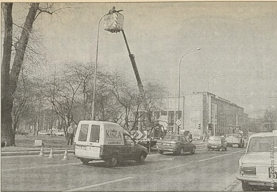
Korzystając z mniejszego przed południem ruchu na alejach Trzech Wieszców, służby drogowe wymieniały słup oświetlenia ulicznego zniszczony niegdyś przez samochód. Sprawnie przeprowadzona operacja nie spowodowała korków
