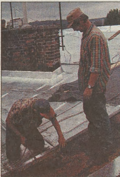
Dach ma kilkadziesiąt lat. Jest jak sito. Podziurawiony i polatany. Brygada od tygodnia biedzi się z jego generalnym remontem. A deszcz im tego nie ułatwia...
