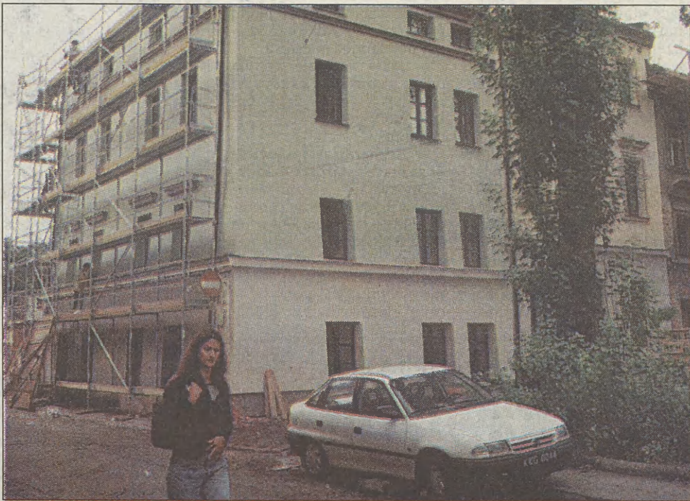
Kamienice przy ul. Ciemnej przechodzą generalny remont. Ciemna staje się jaśniejsza
