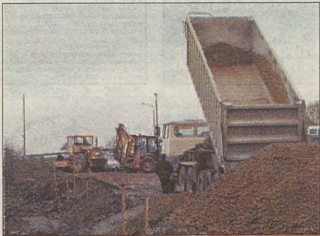
Z Kamińskiego widać już prace na nowej ulicy Góralskiej
