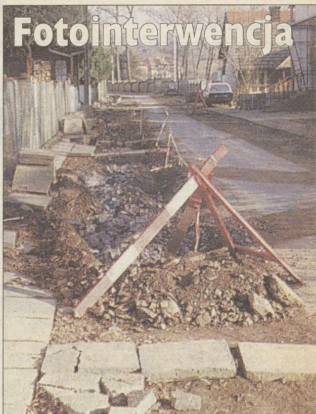
Mszana Dolna, ul. Leśna. To zdjęcie, wykonane 13 listopada, przysłała do redakcji Czytelniczka w imieniu mieszkańców, którzy są już zmęczeni przedłużającymi się robotami przy modernizacji ulicy
