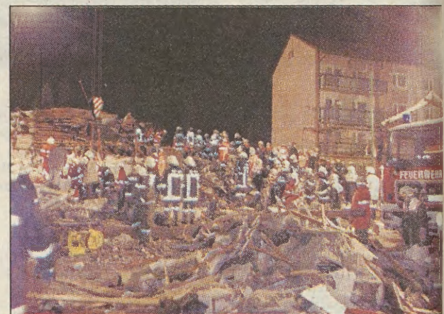
Wybuch był tak silny, że kawałki betonu uderzyły w budynek znajdujący się w odległości 50 metrów zniszczonego domu
