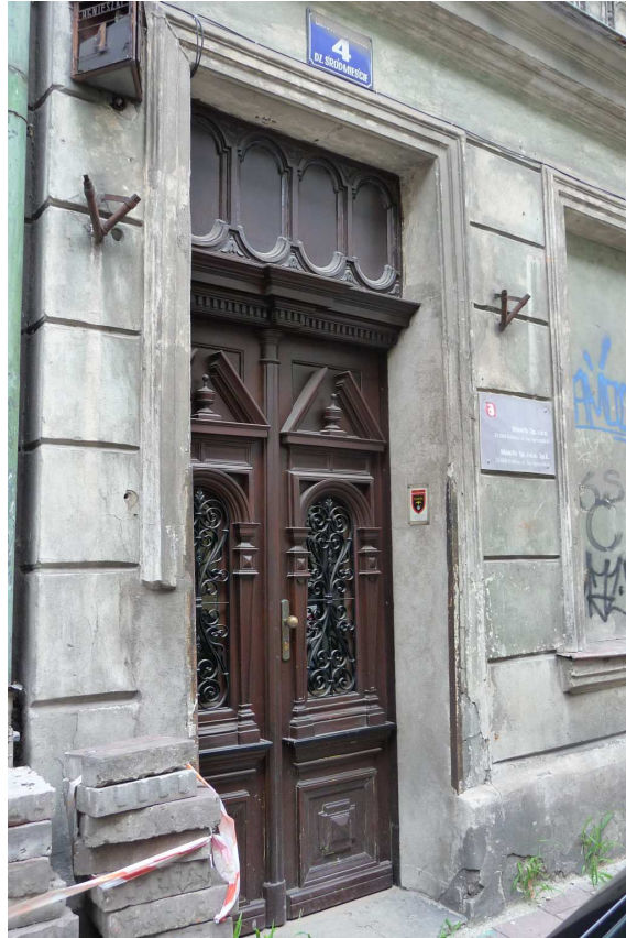
Fot. nr 358. Profilowane drzwi kamienicy spod nr 4. (28.07.2024)
