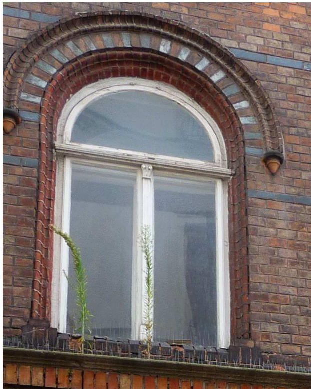
Fot. nr 360. Oryginalne okno. (28.07.2024)
