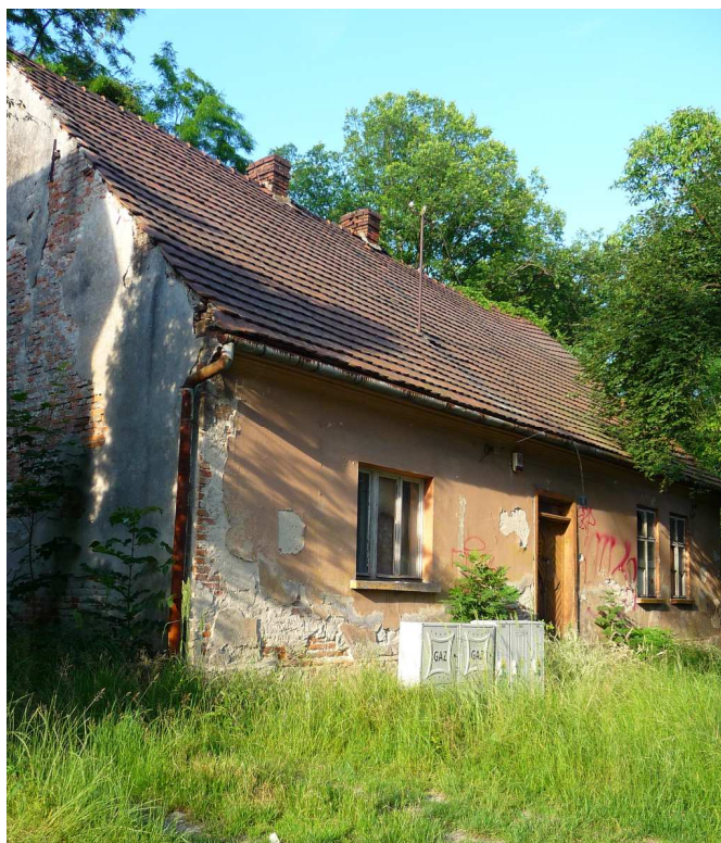
Fot. nr 299 (299-314). Wzdłuż ulicy Tetmajera. Dom pod nr 6. (08.06.2024)
