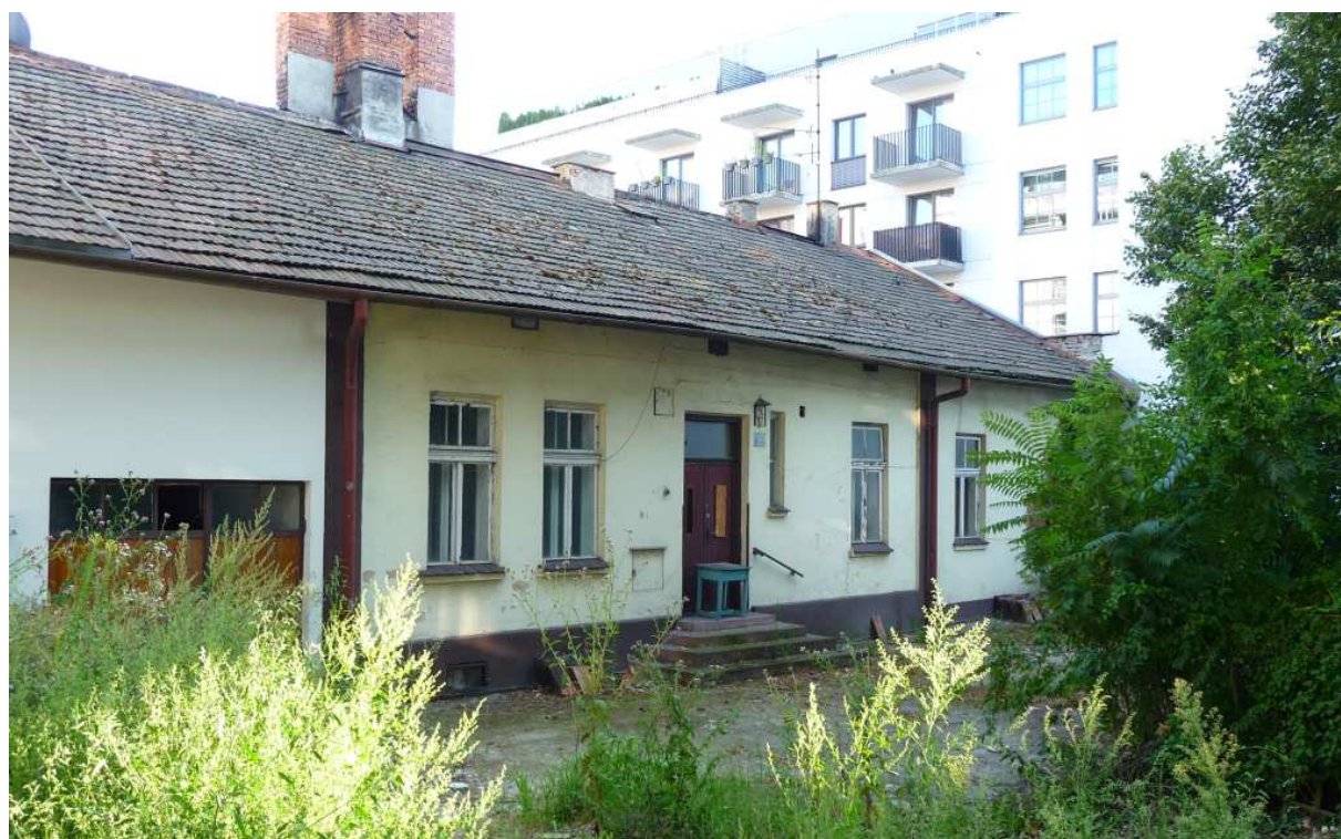
Fot. nr 266 (266-269). Wzdłuż ulicy Cieszyńskiej. Relikt parterowej zabudowy spod nr 15. (30.07.2024)
