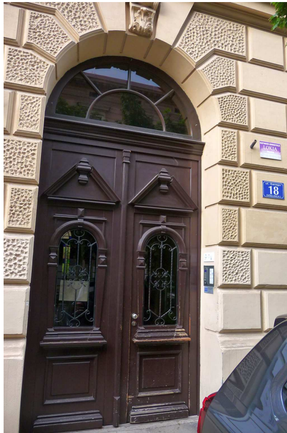
Fot. nr 368 (368-369). Drzwi kamienicy pod nr 18. (28.07.2024)
