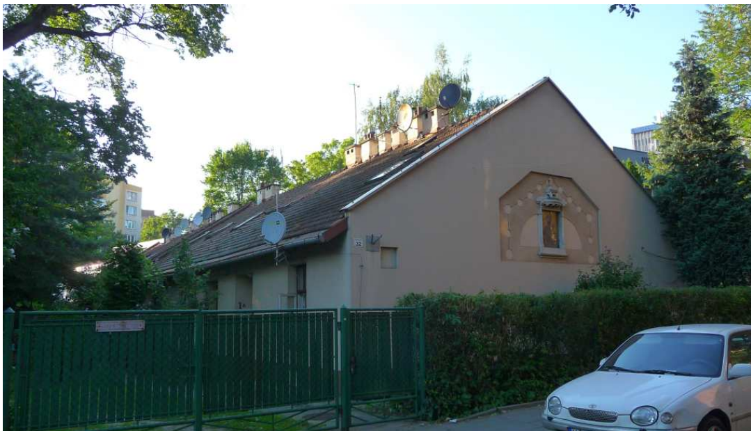
Fot. nr 254 (254-255). Zespół tanich domów dla rodzin robotników katolickich przy ulicy Sienkiewicza 32, powstałych w 1916 roku. (30.07.2024)
