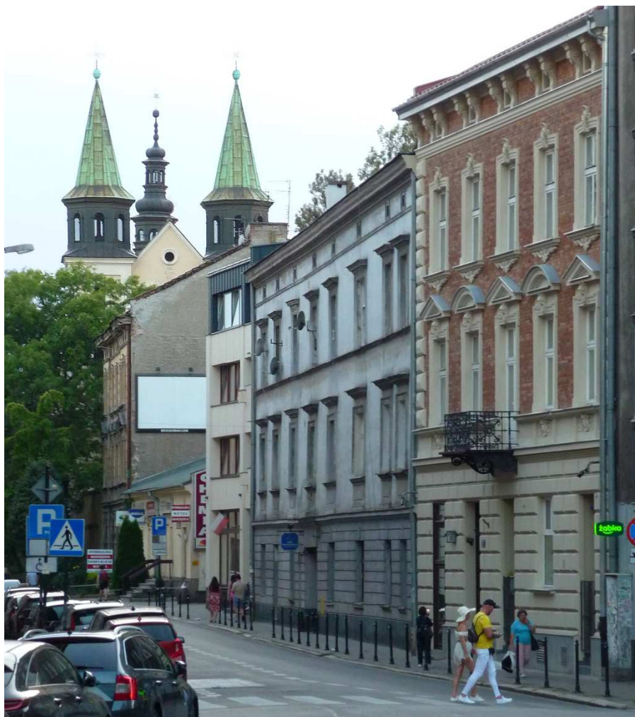
Fot. nr 222 (222-226). Wzdłuż ulicy Garbarskiej. (07.09.2024)
