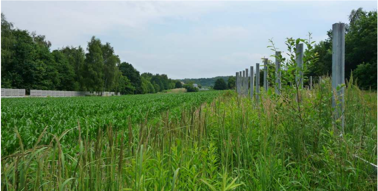
Fot. nr 496 (496-498). Centralna część Użytku jeszcze z pozostałościami betonowego ogrodzenia, które pośpiesznie, wbrew ustaleniom, postawił NIEDOSZŁY deweloper. (09.06.2024)
