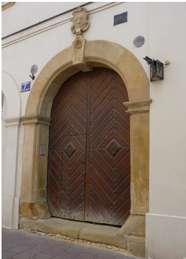
Fot. nr 122. Portal kamienicy Hebdowskiej pod nr 7. (02.07.2024)
