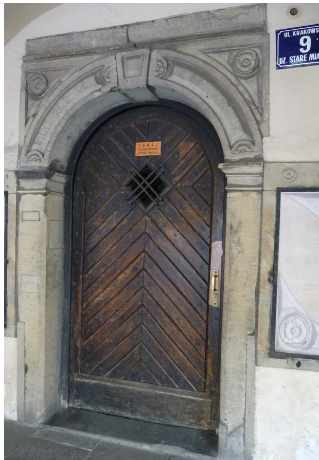
Fot. nr 393. Portal i drzwi kamienicy pod nr 9. (28.07.2024)
