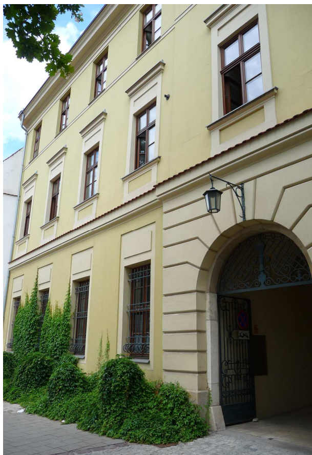
Fot. nr 137. Fragment pałacu prymasowskiego od strony placu św. Idziego. (02.07.2024)
