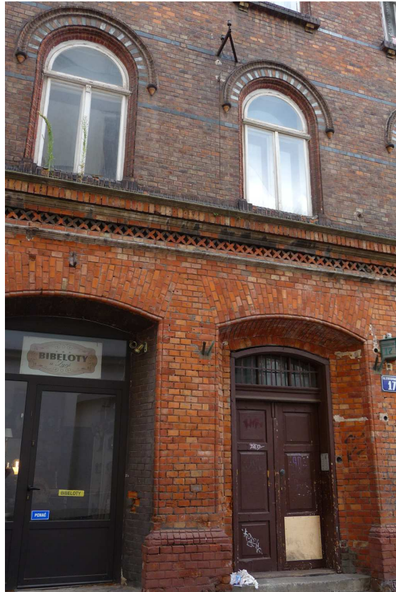
Fot. nr 359 (359-360). Detale budynku dawnej komory celnej z ulicy Stradomskiej 17. (28.07.2024)
