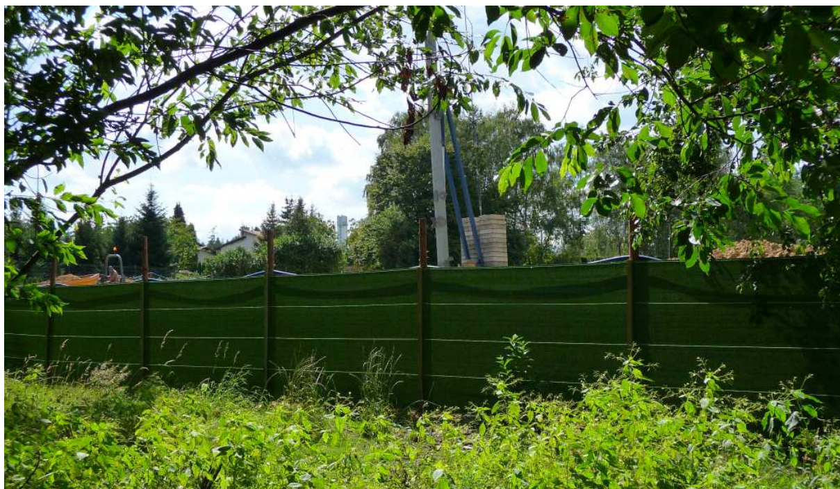
Fot. nr 473 (473-474). Rozpoczęła się budowa osiedla mieszkaniowego na skraju Użytku na tyłach ulicy Rżackiej. (29.07.2024)
