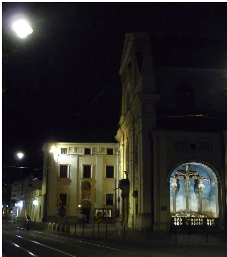
Fot. nr 219 (219-220). Golgota na północnej ścianie. (27.08.2024)
