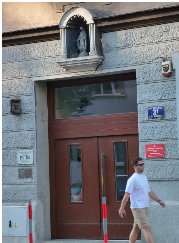
Fot. nr 279. Niestety podczas remontu znikły profilowane w drewnie drzwi. (30.07.2024)
