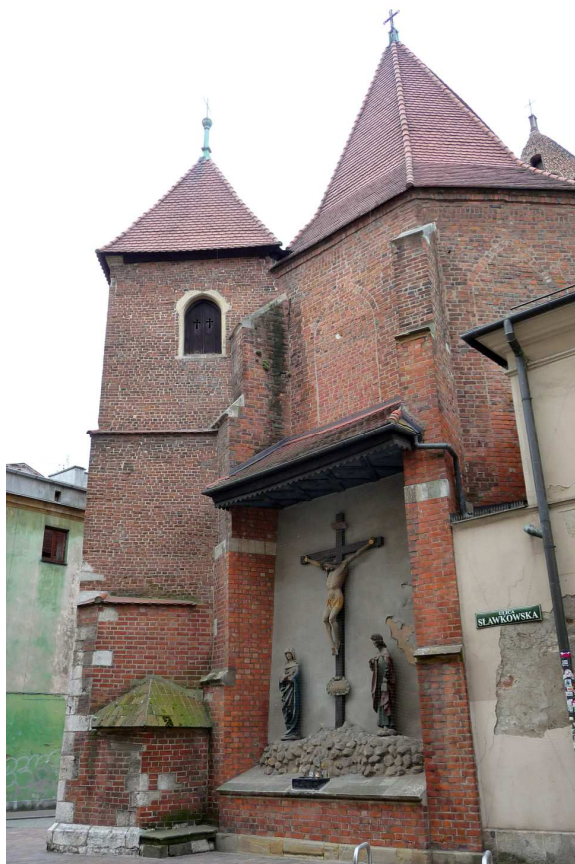
Fot. nr 144. Golgota w ścianie zewnętrznej prezbiterium. (12.06.2024)
