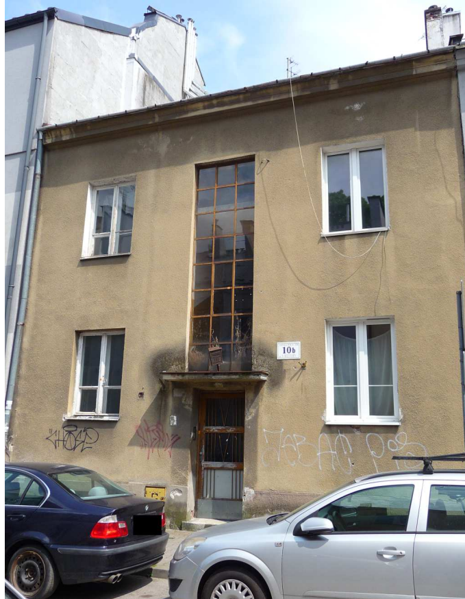
Fot. nr 434. Raczej jeszcze przedwojenny dom przy dawnej ulicy Kaletników 10b, dziś Mitery.
