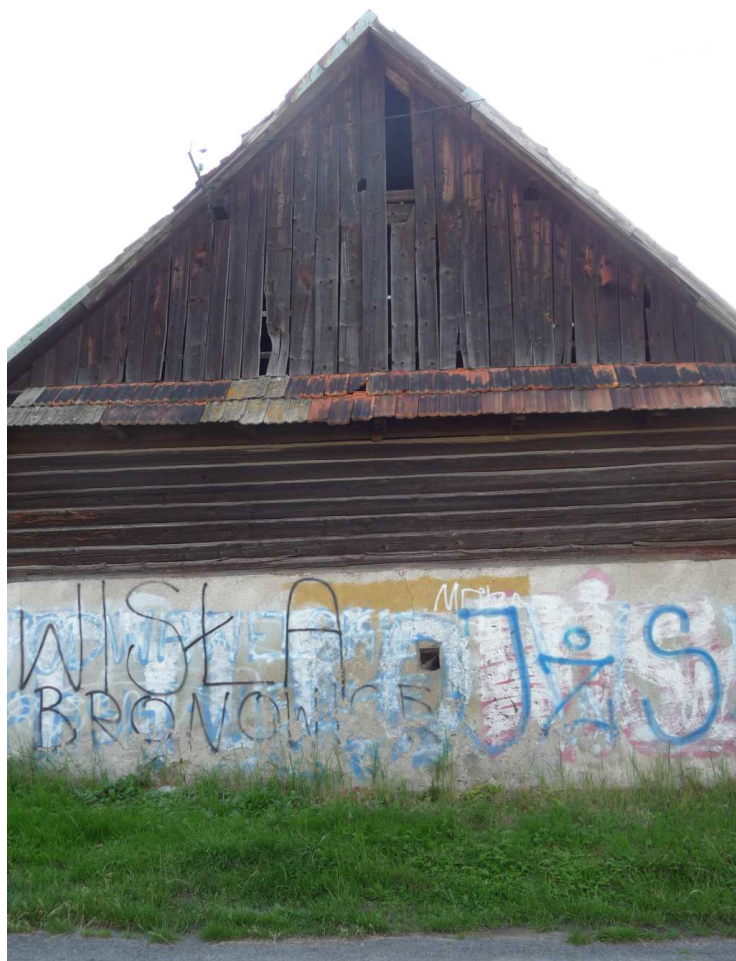
Fot. nr 348. Ściana boczna. (08.06.2024)
