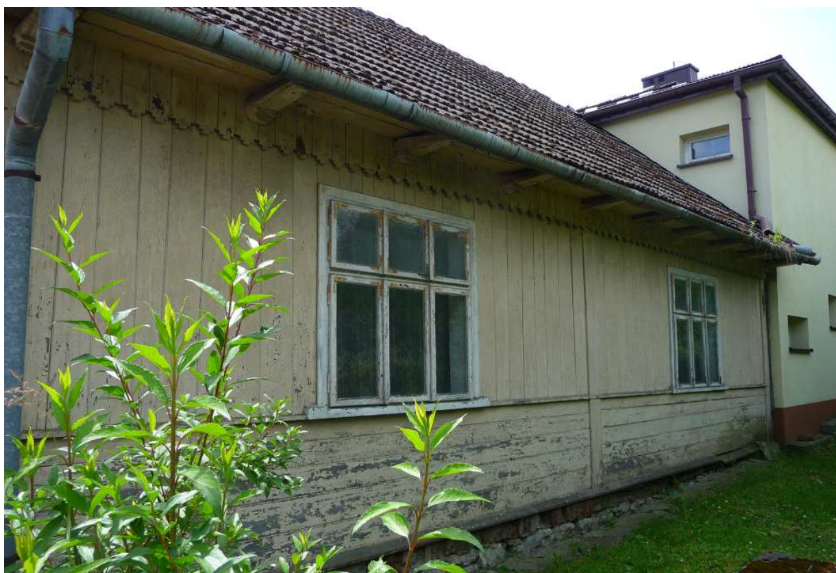
Fot. nr 559. Tylny fragment z oknami typu weneckiego. (14.06.2024)
