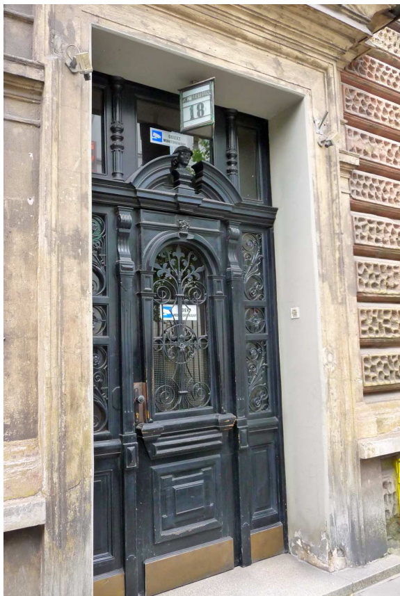
Fot. nr 364. Pełne eklektycznego bogactwa drzwi kamienicy spod nr 18. (28.07.2024)
