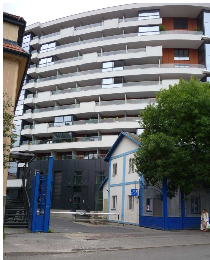
Fot. nr 166 (165-166). Nowa zabudowa na terenie dawnych zakładów Zieleniewskiego pod nr 69. (05.08.2024)
