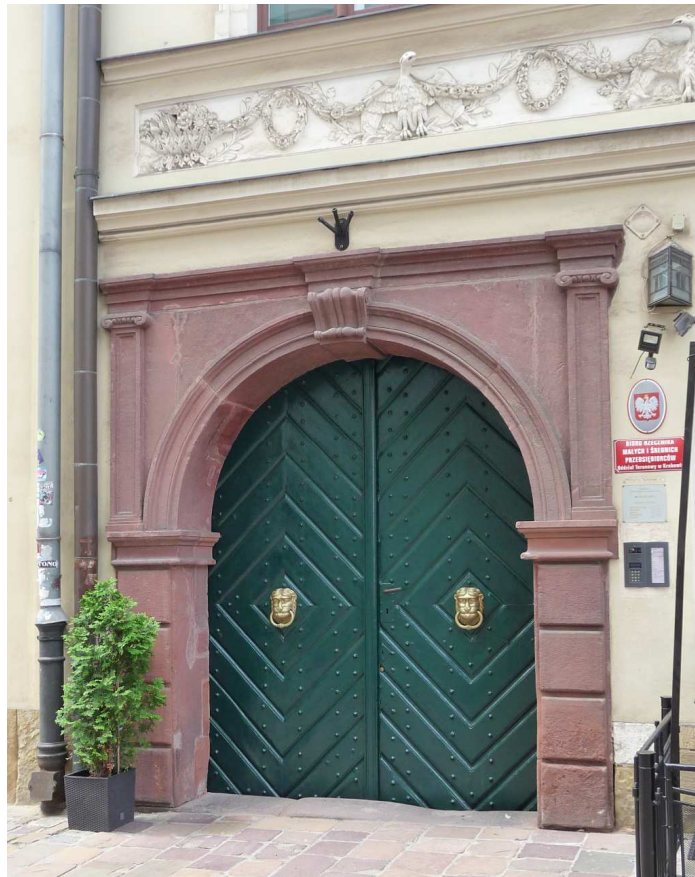
Fot. nr 130. Portal i drzwi kamieniczki pod nr 11. (02.07.2024)
