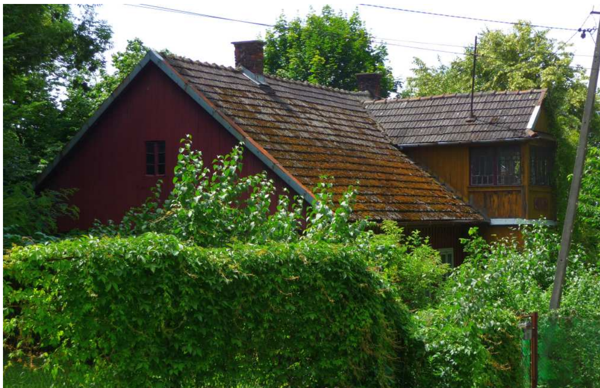
Fot. nr 514 (514-522). Wzdłuż ulicy Braci Sawiczewskich. (14.06.2024)
