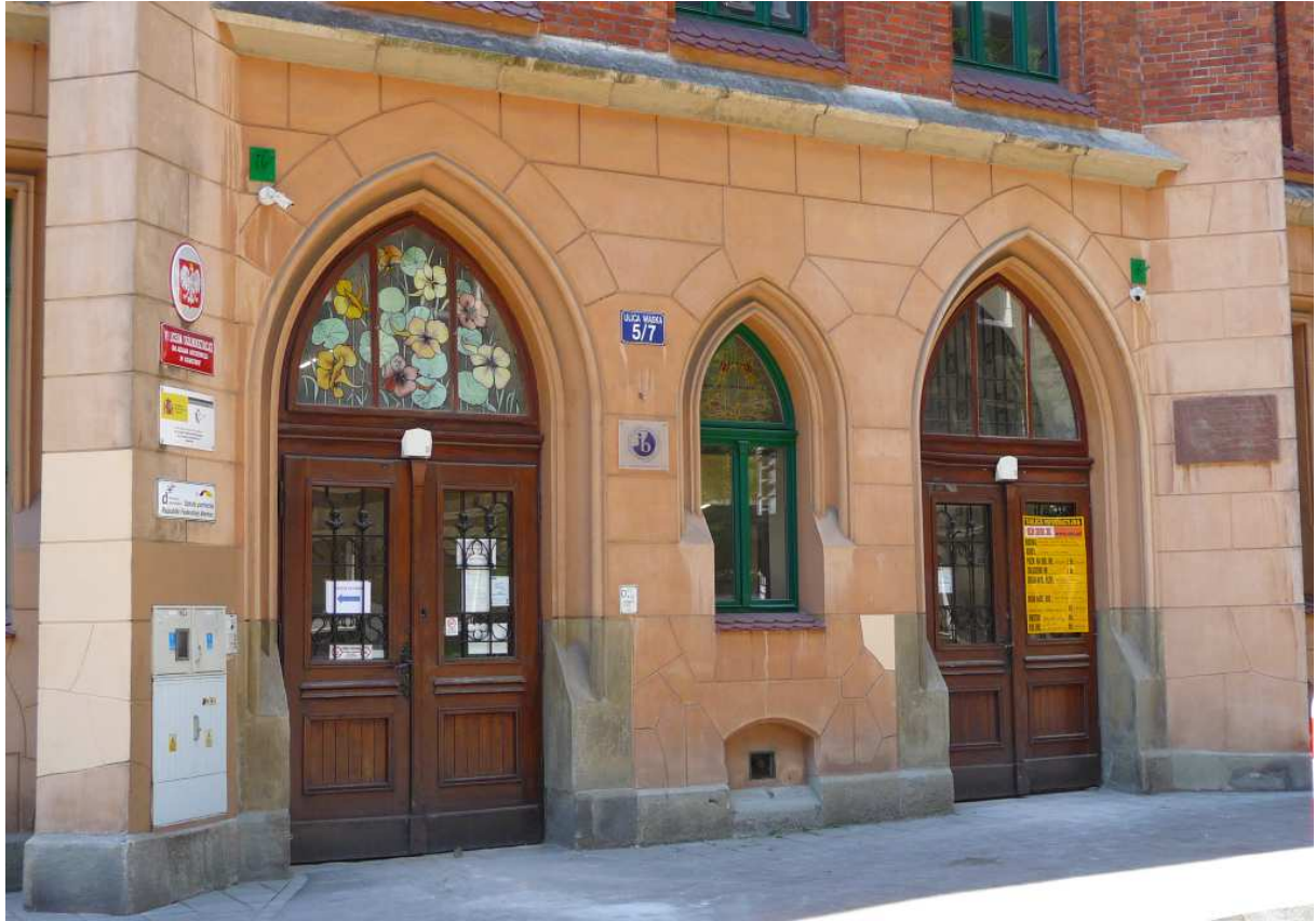
Fot. nr 374 (374-375). Neogotyckie detale budynku szkolnego z ulicy Wąskiej 5/7.(05.07.2024)
