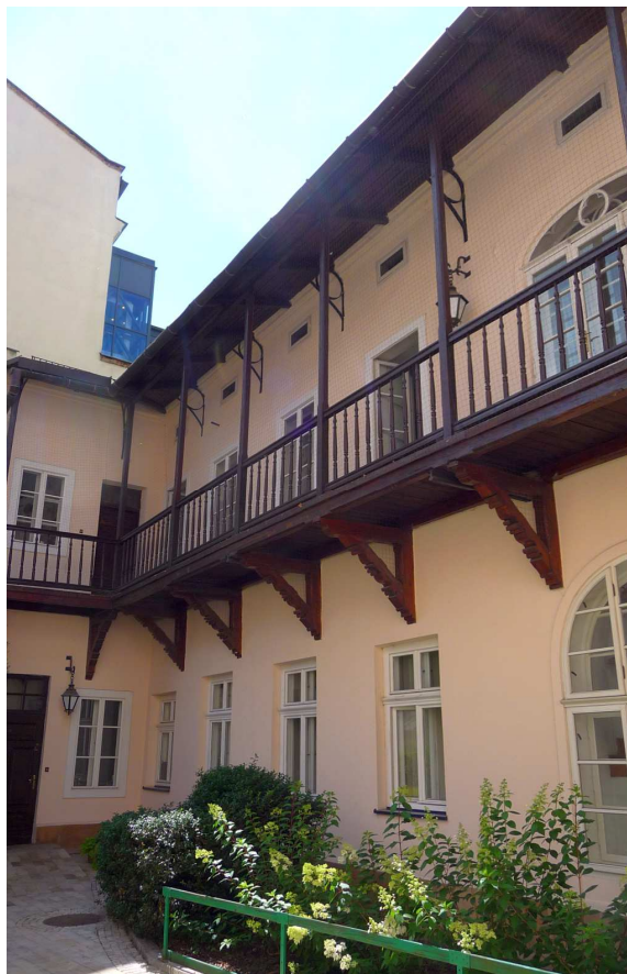
Fot. nr 110 (109-110). Dziejnec kamienicy pod nr 18. (25.06.2024)
