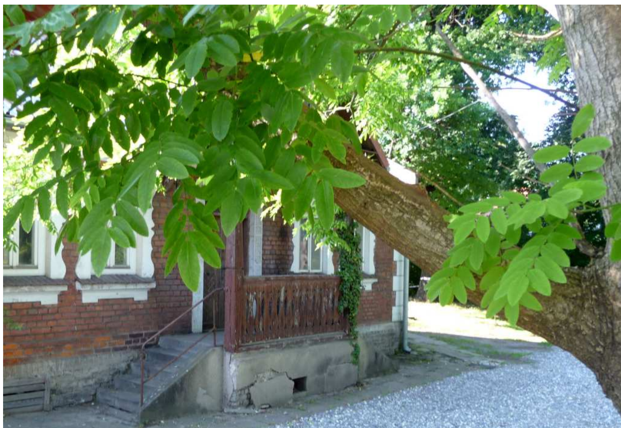
Fot. nr 331 (331-332). Fasada obiektu. (08.06.2024)
