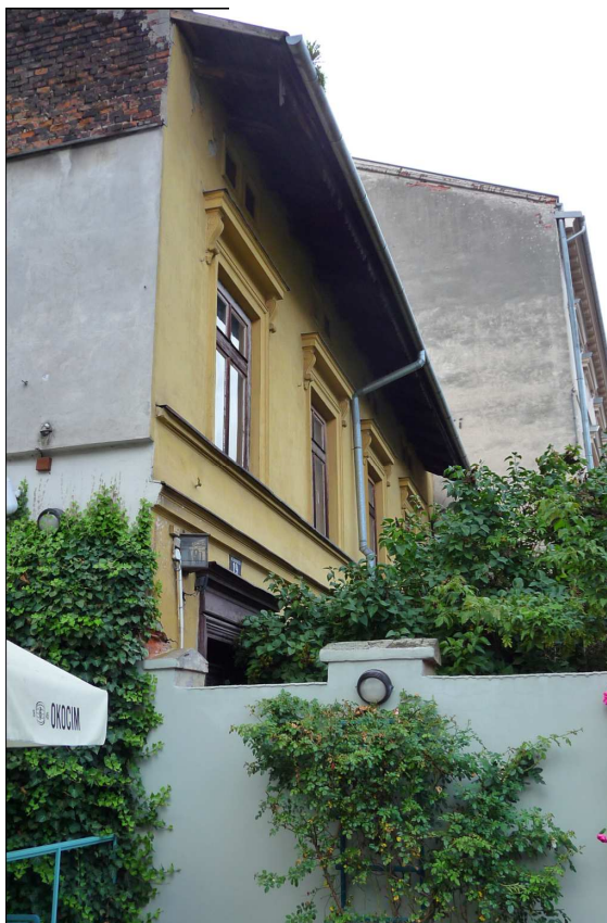
Fot. nr 179. Fasada 150-letniego domu. (03.08.2024)
