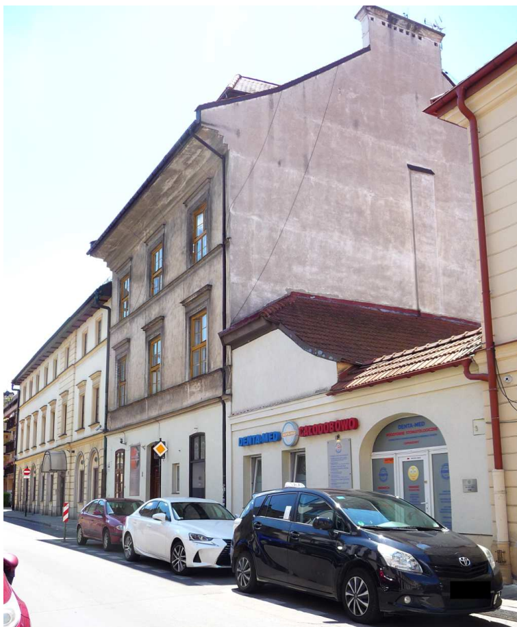
Fot. nr 398. Fragment zabudowy o nr: 14-18 powyżej ulicy Skałecznej. (05.07.2024)
