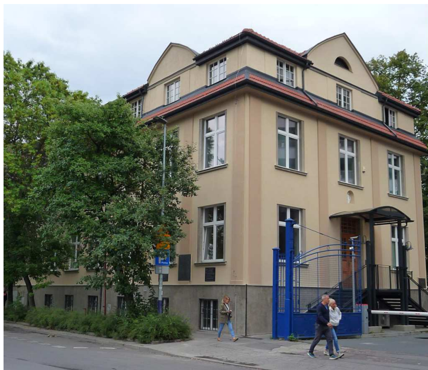
Fot. nr 167 (167-168). Świeżo wyremontowany budynek dyrekcji dawnych zakładów Zieleniewskiego pod nr 69. (05.08.2024)
