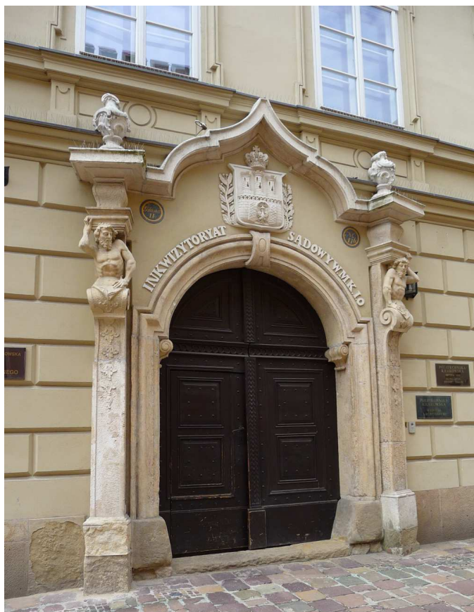
Fot. nr 124 (124-135). Wzdłuż ulicy kanoniczej. Portal kamienicy pod nr 1. (02.07.2024)
