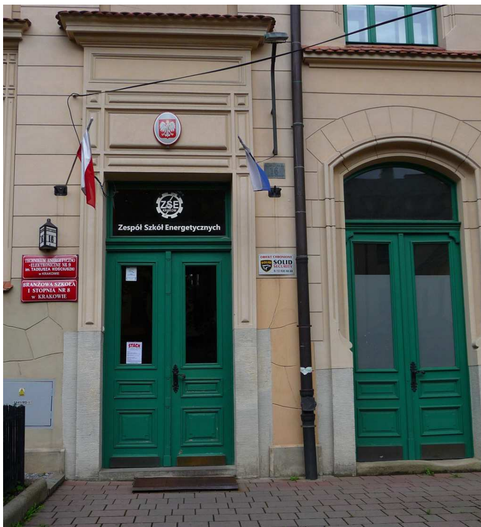
Fot. nr 245 (245-246). Drzwi wejściowe do budynków szkolnych przy ulicy Loretańskiej 16 i 18. (03.08.2024)
