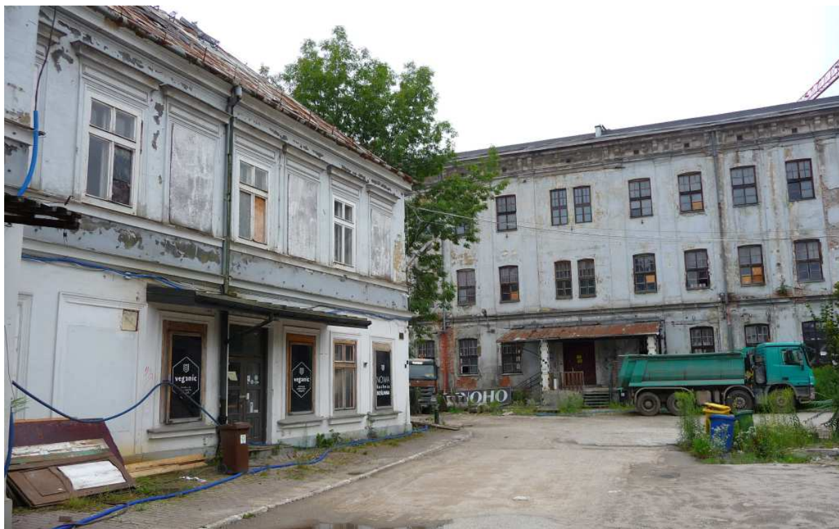
Fot. nr 196 (195-199). Zabudowania dawnej „cygar fabryki” pod nr 10-12 oczekujące na przebudowę i rozbudowę. (14.07.2024)
