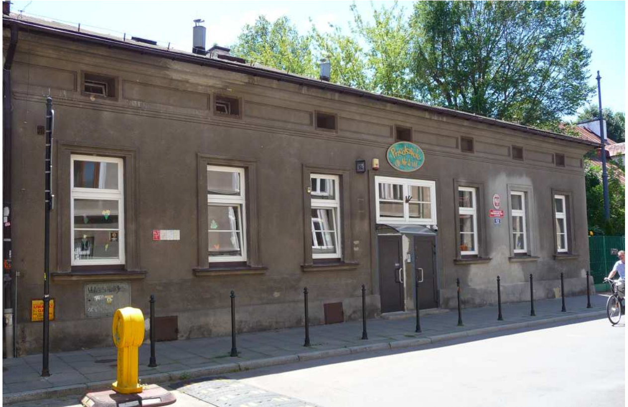
Fot. nr 406. Dawna ochronka pod nr 12, wybudowana w roku 1875 wg projektu Jacka Matusińskiego.
