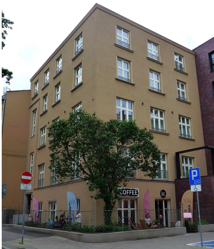
Fot. nr 190 (190-192). Przebudowana kamienica pod nr 16. (11.06.2024)
