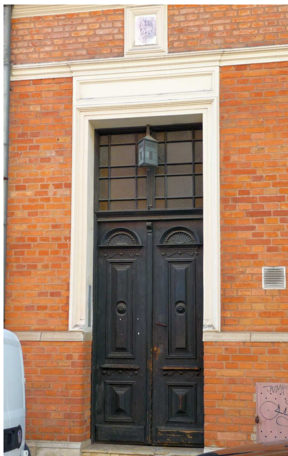
Fot. nr 264. Oryginalne drzwi. (30.07.2024)
