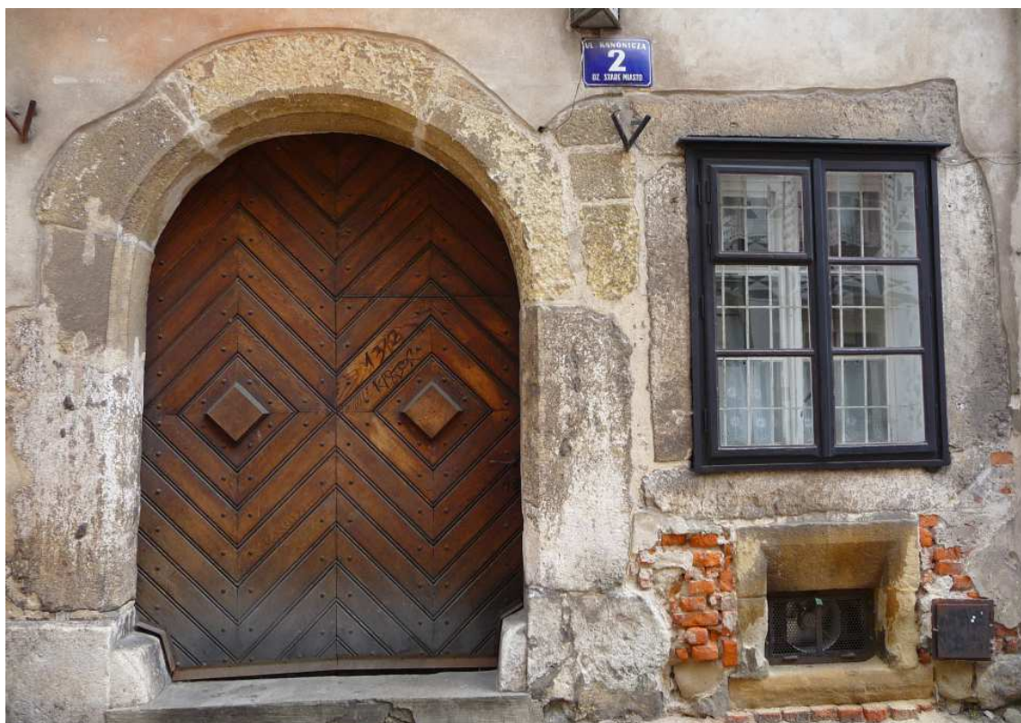
Fot. nr 125. Detale fasady kamieniczki pod nr 2. (02.07.2024)
