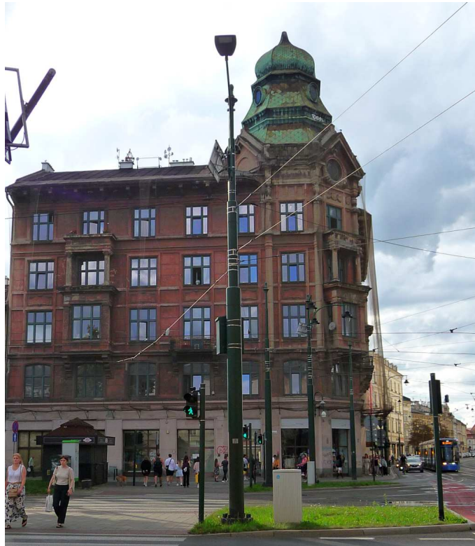
Fot. nr 356. Kamienica Ohrensteina wciąż czeka na remont generalny. (28.07.2024)
