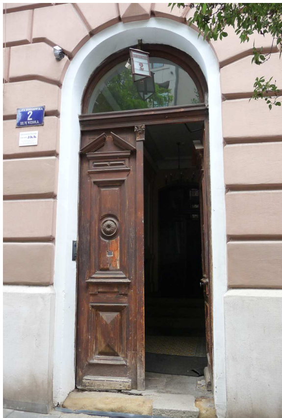
Fot. nr 151 (151-152). Drzwi i sień kamienicy pod nr 2. (11.06.2024)
