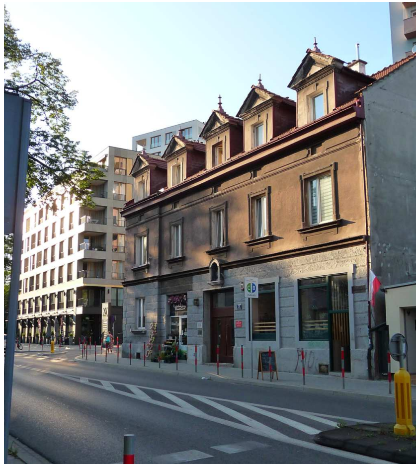
Fot. nr 278 (278-279). Nieco zniekształcona już fasada domu z ulicy Wrocławskiej 31. (30.07.2024)
