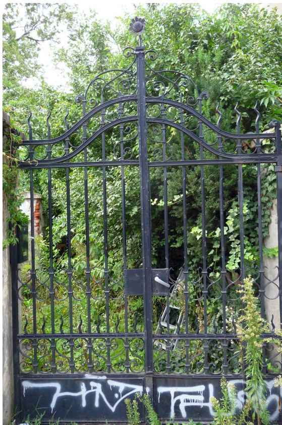
Fot. nr 178 (178-179). Opuszczony dom pod nr 19, przed którym jeszcze 90 lat temu płynęła Młynówka Królewska. Metalowa brama prze wejściu do ogrodu. (03.08.2024)
