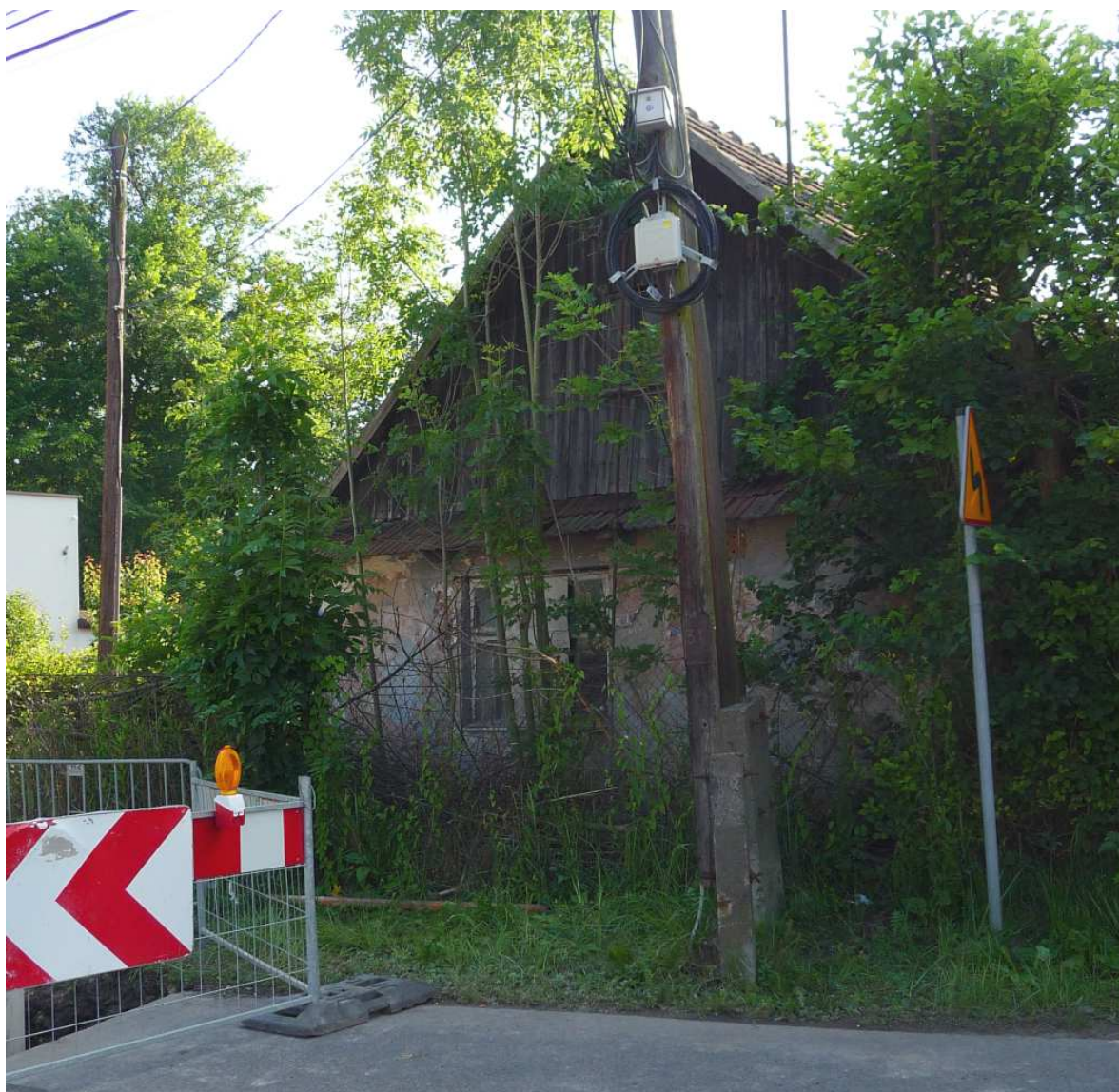
Fot. nr 354. Ściana szczytowa chałupy pod nr 105. (08.06.2024)
