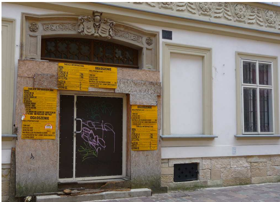
Fot. nr 131. Detale parteru odnawianej kamienicy pod nr 12. (02.07.2024)
