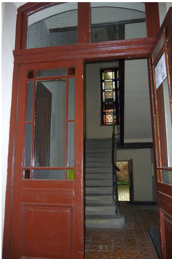
Fot. nr 152. Klatka schodowa. (11.06.2024)
