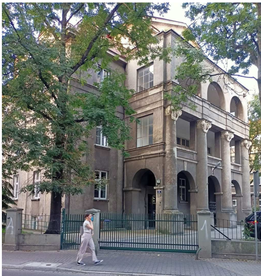
Fot. nr 283. Kamienica z roku 1927 z ulicy Friedleina 1. (20.08.2024)
