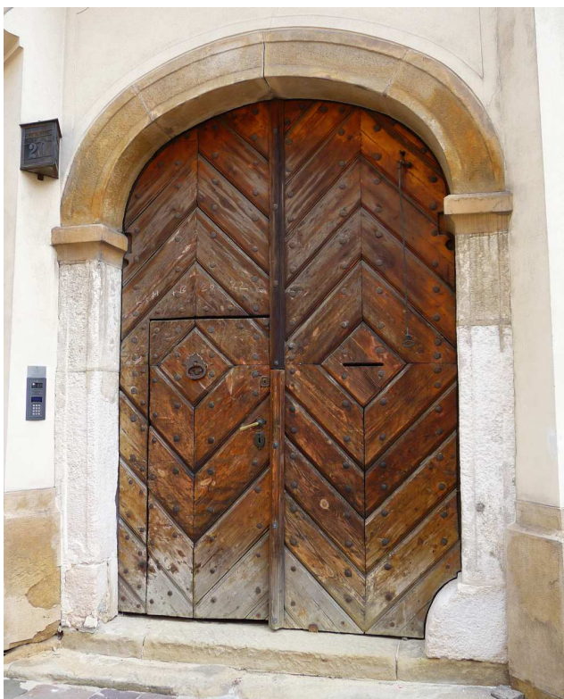
Fot. nr 135. Portal i drzwi kamieniczki pod nr 20. (02.07.2024)
