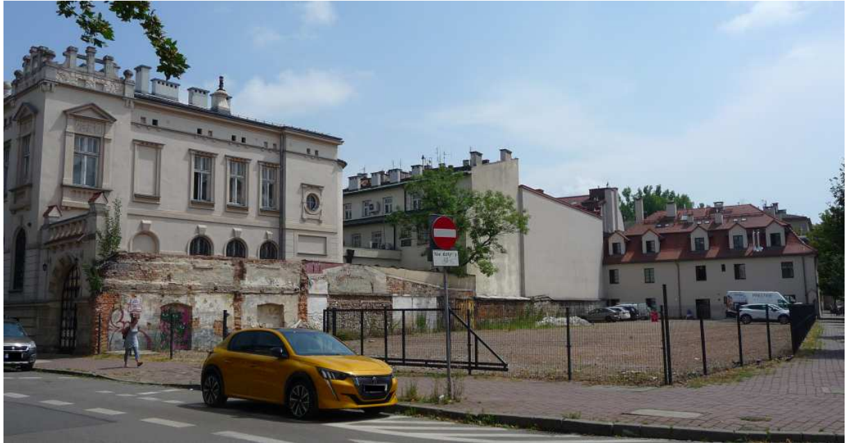
Fot. nr 424 (424-425). Pusta przestrzeń po wyburzeniu parterowych pomieszczeń w zespole dawnego zajezdu Pod Kotwicą w narożu z ulicą Węgierską. (08.07.2024)
