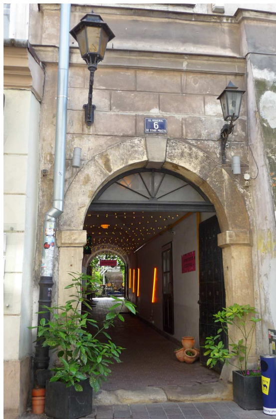
Fot. nr 111 (111-112). Detale kamienicy pod nr 6. Portal i sień. (25.06.2024)
