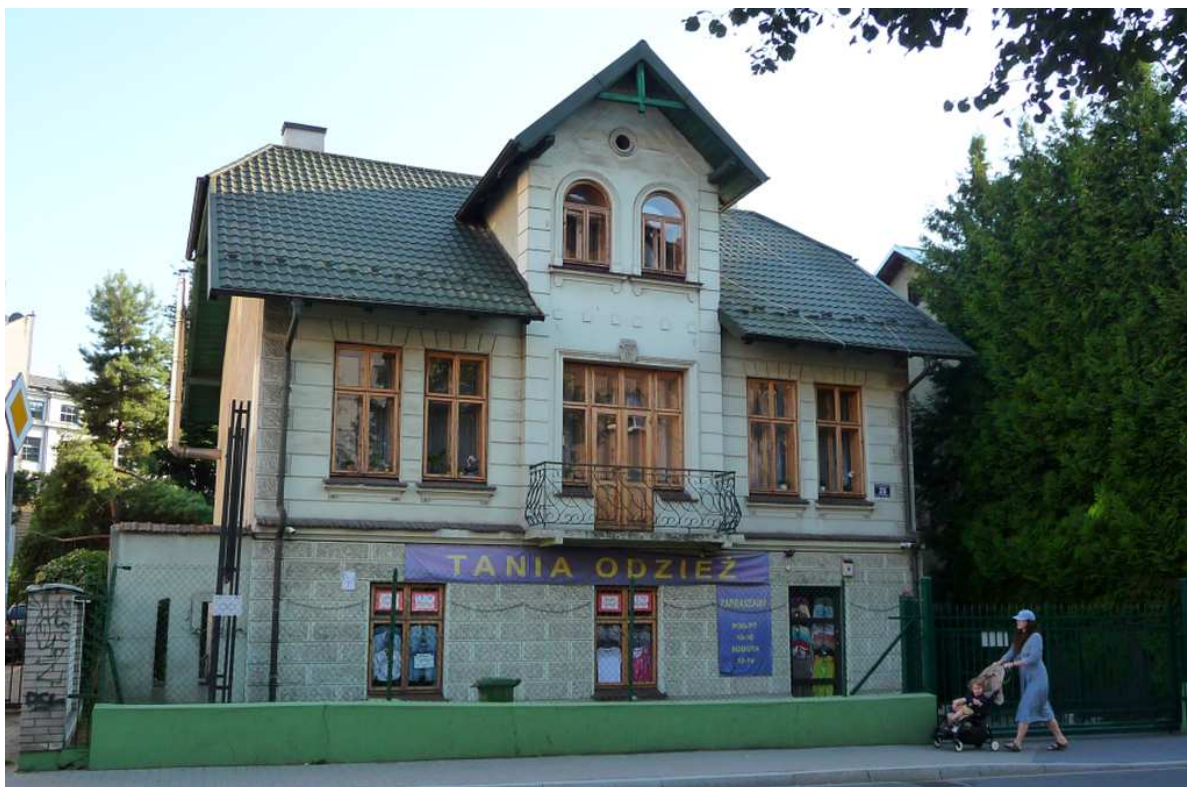
Fot. nr 273 (273-279). Wzdłuż ulicy Wrocławskiej. Stylizowana willa z roku 1908 pod nr 20. (30.07.2024)
