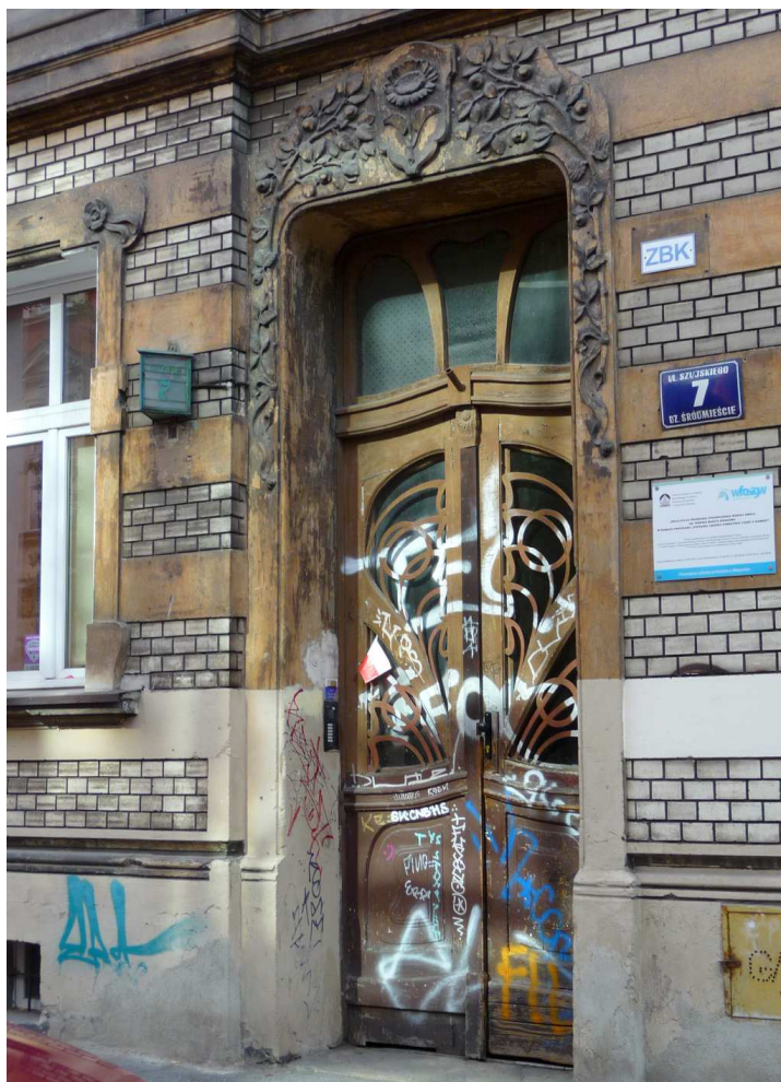
Fot. nr 194. Secesyjne drzwi pod nr 7. (07.08.2024)
