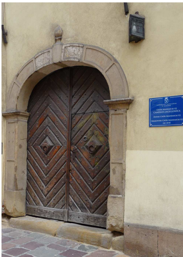
Fot. nr 126. Portal kamieniczki pod nr 6. (02.07.2024)
