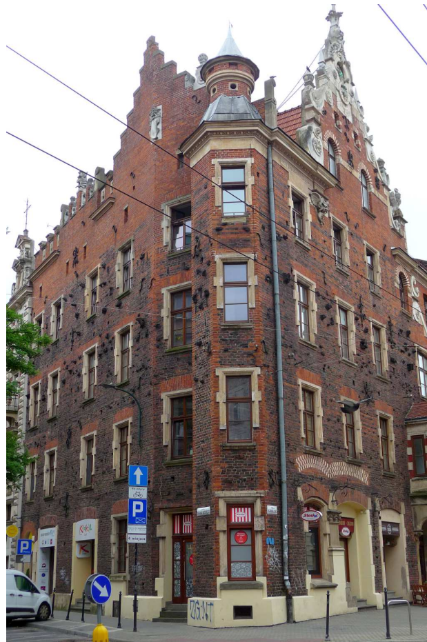
Fot. nr 209. Kamienica „Pod Pajakiem” Teodora Talowskiego pod nr 35. (14.07.2024)
