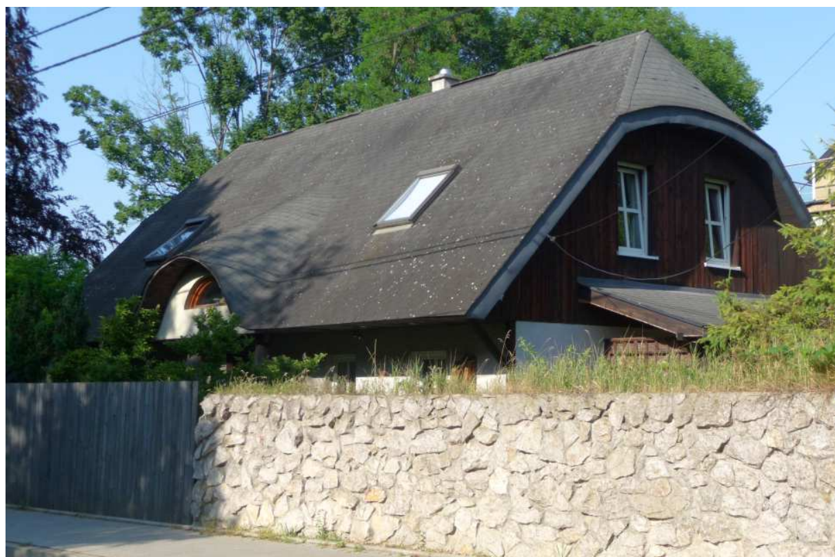
Fot. nr 333 (333-334). Dom z ulicy Smętnej 11. (08.06.2024)
