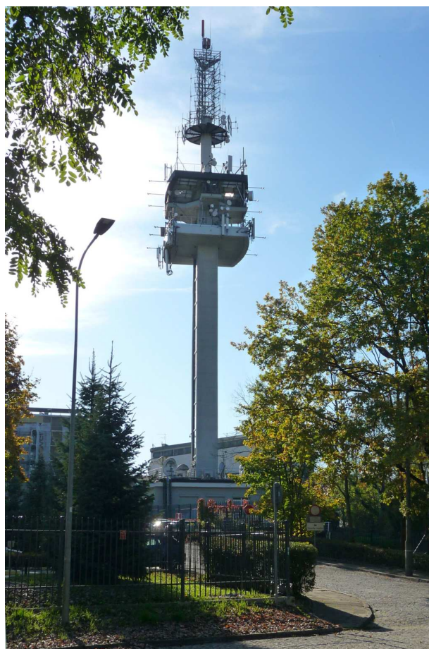
Fot. nr 331. Wieża ośrodka TVP Kraków na Krzemionkach. (21.10.2024)
