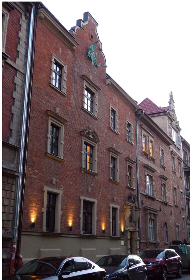
Fot. nr 107. Pierwotnie zaprojektowane przez Teodora Talowskiego kamienice pod nr: 18 (Pod Smokiem) i 20 (17.10.2024)
