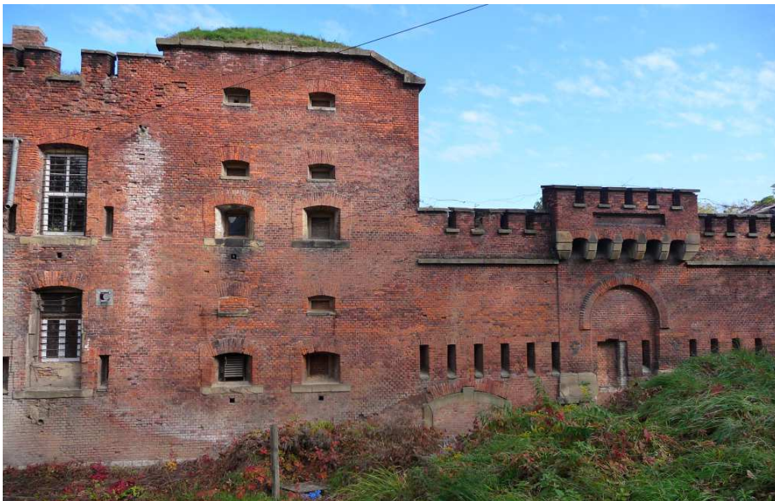
Fot. nr 158 (158-159). Kurtyna fortu od strony ulicy Kamiennej. (26.10.2024)
