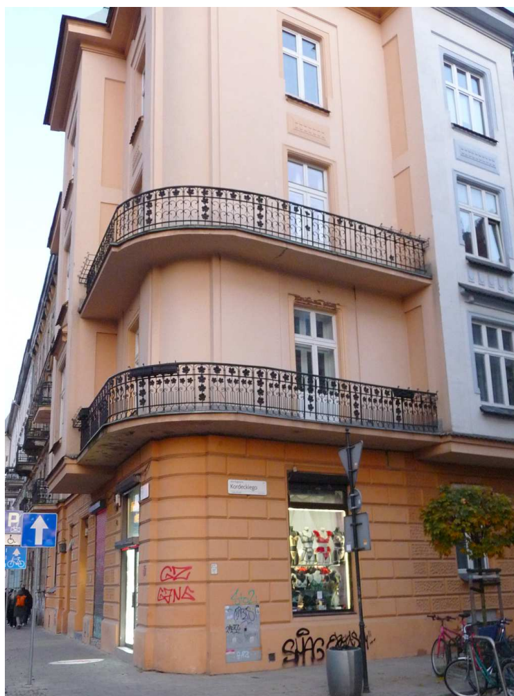
Fot. nr 287 (287-296). Wzdłuż ulicy Dietla. Metalowa balustrada ganków kamienicy pod nr 7. (06.11.2024)
