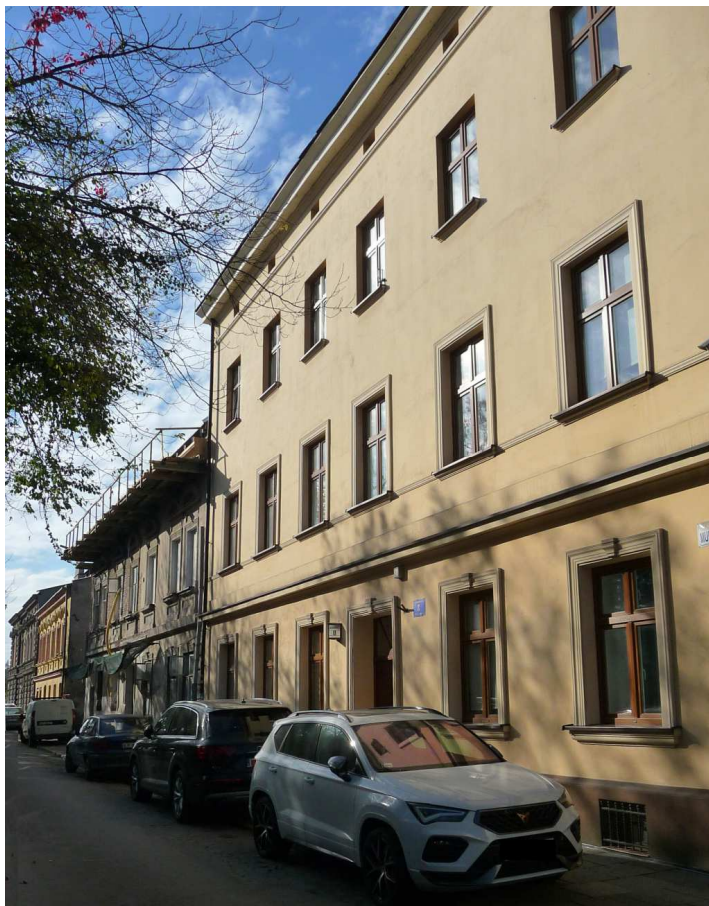
Fot. nr 138. Fragment zabudowy poniżej nr 8. (26.10.2024)
