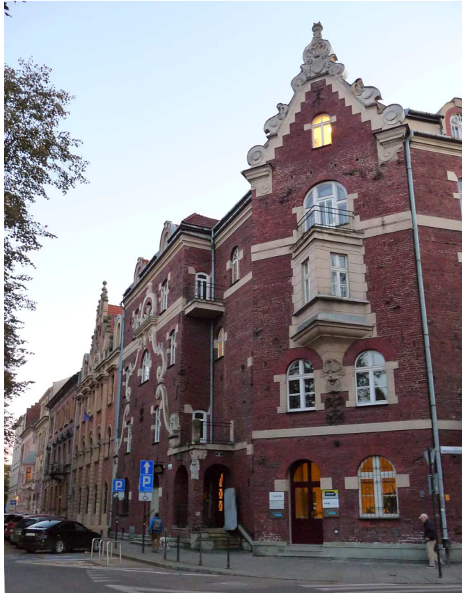
Fot. nr 110. Widok z ulicy Piłsudskiego z kamienicą „Pod śpiewającą żabą”. (17.10.2024)
