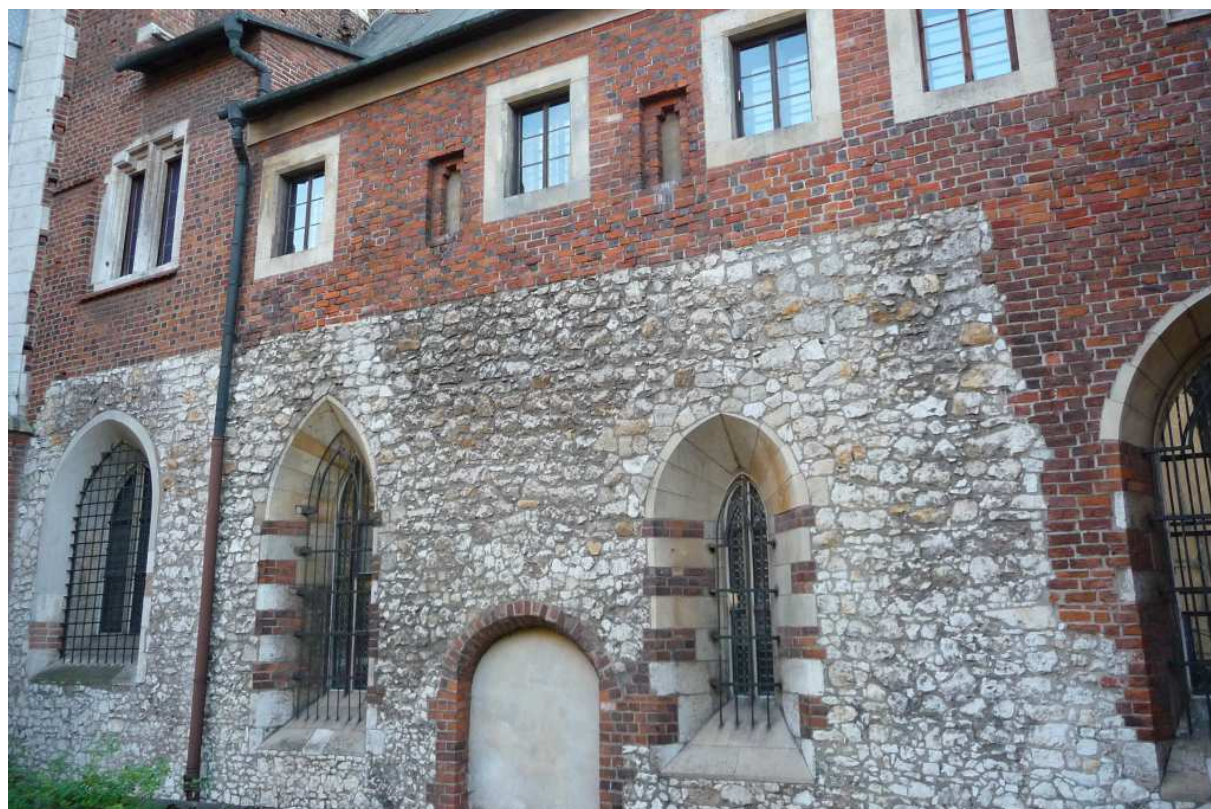
Fot. nr 267. Ostrolukowe okienka. (06.11.2024)
