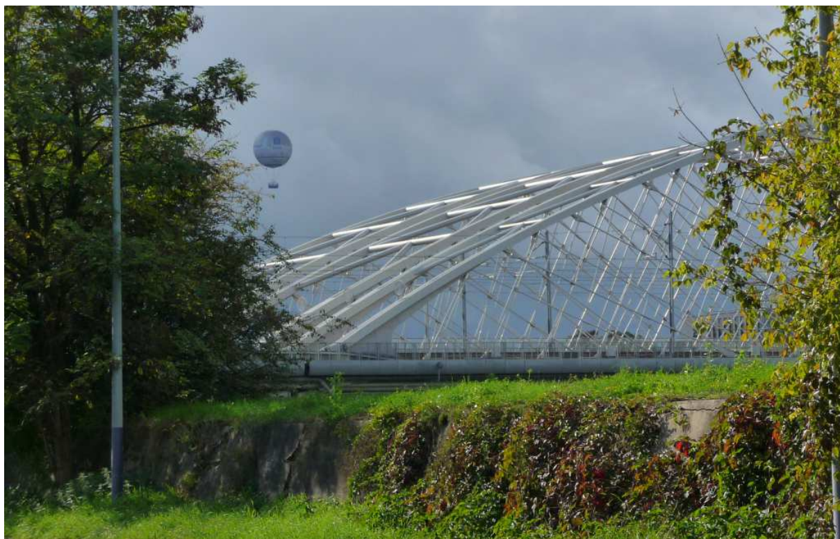
Fot. nr 374 (374-375). Widoki z ulicy Zabłocie na most Kotlarski. (06.10.2024)
