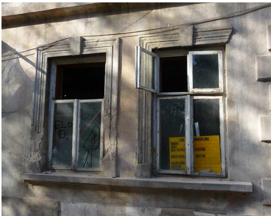
Fot. nr 137 (136-137). Oryginalne okna na etapie przebudowy. (26.10.2024)
