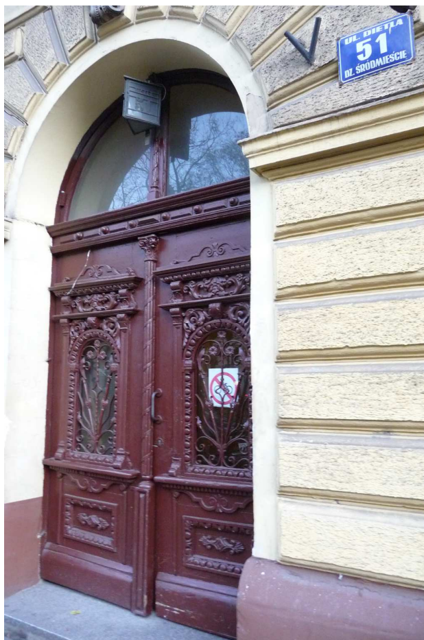
Fot. nr 294. Neorenesansowe drzwi kamienicy spod nr 51. (20.11.2024)
