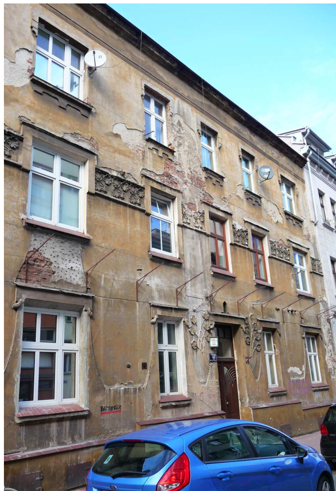
Fot. nr 352 (352-353). Zabudowa ulicy św. Kingi. Kamienica z roku 1911, z dekoracją secesyjną w fasadzie, pod nr 11. (06.10.2024)
