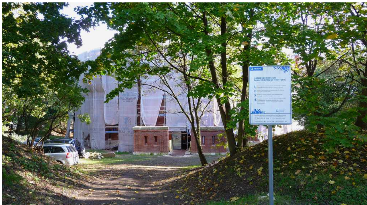
Fot. nr 310. Wreszcie trwa kompleksowy remont fortu. (21.10.2024)
