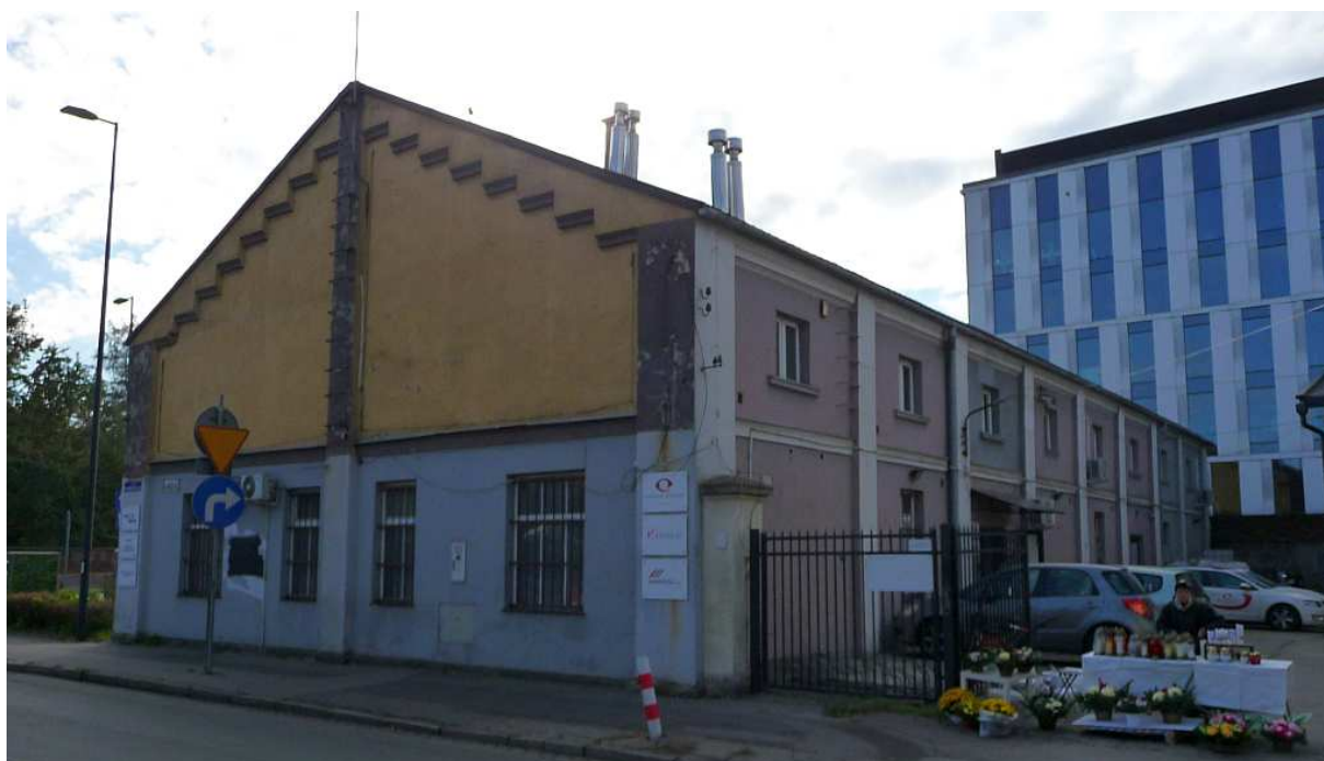
Fot. nr 161 (161-162). 100-letni budynek dawnego magazynu pod nr 45. (26.10.2024)
