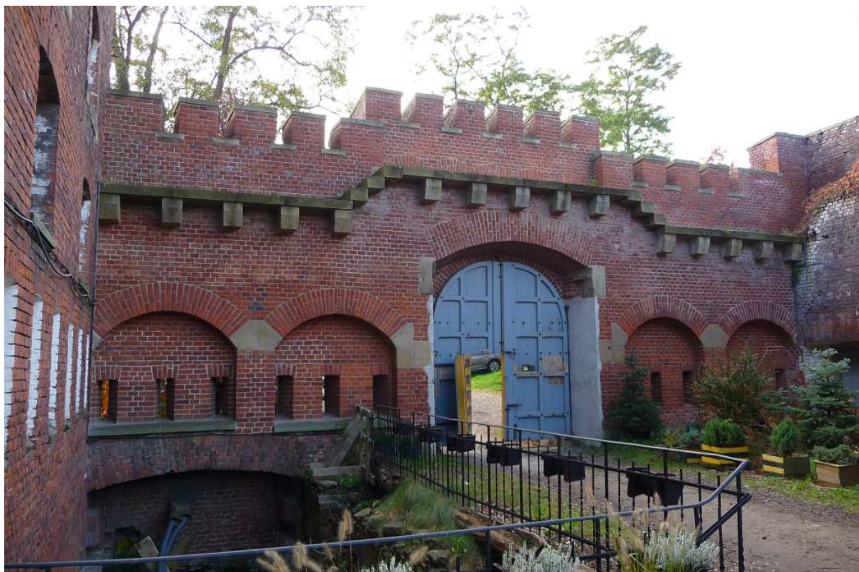
Fot. nr 154 (154-155). We wnętrzu fortu. (26.10.2024)
