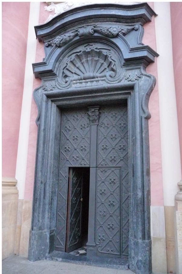
Fot. nr 281. Portal wejściowy do kościoła z czarnego marmuru dębnickiego. (06.11.2024)
