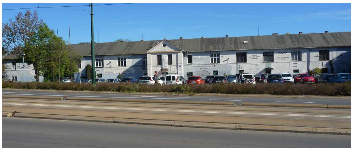
Fot. nr 365 (365-366). Najczęściej określany jako stajnie, piętrowy podłużny budynek przynależny do dawnego składu solnego przy porcie przeładunkowym wielickiej soli nad Wisłą, przy ulicy Na Zjeździe 8. Na mapie z roku 1847 zaznaczone są dwa budynki składu solnego: podłużne, drewniano-murowane, usytuowane wzdłuż Wisły, a pod koniec XIX wieku już tylko jeden. Ten ostatni został wyburzony w związku z budową III. mostu (Krakusa), łączącego Kraków z Podgórzem, oddanego do użytku w dniu 20.01.1913. W innej wersji, to wybudowane w roku 1803 dawne koszary wojskowe kawalerii (konnicy), zwane też koszarami Kilińskiego bądź salinarnymi, gdzie na parterze znajdowały się stajnie, a na piętrze pomieszczenia dla załogi. (10.10.2024)
