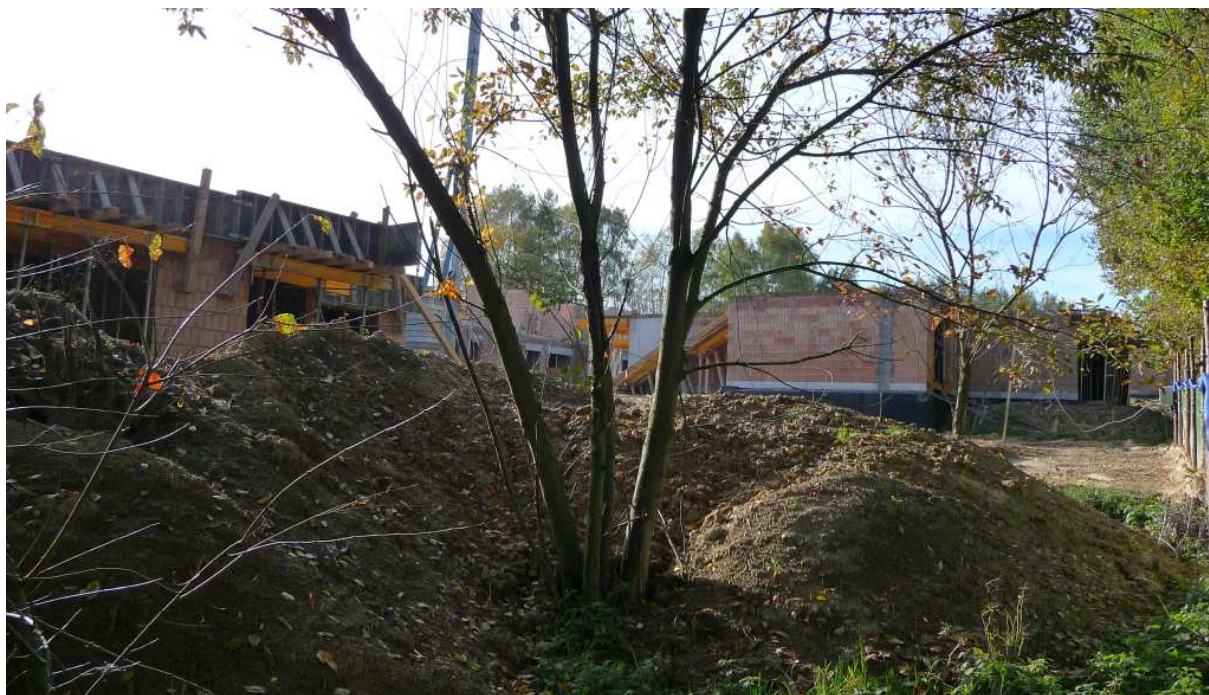
Fot. nr 467 (467-469). Rozpoczęło się betonowanie obrzeża Użytku od strony ulic: Kosocickiej i Rżackiej. (20.10.2024)
