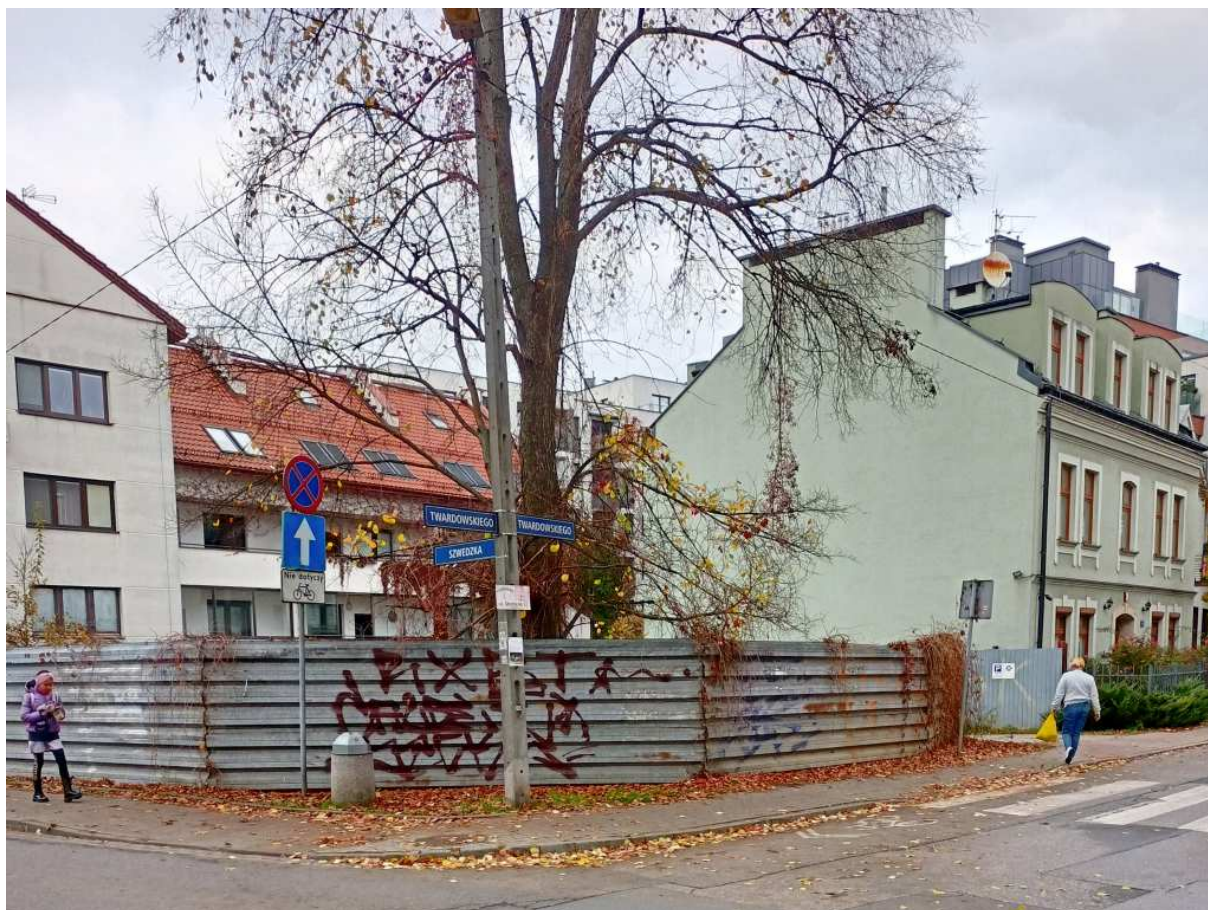
Fot. nr 201. Wyremontowana kamieniczka pod 41. (14.11.2024)
