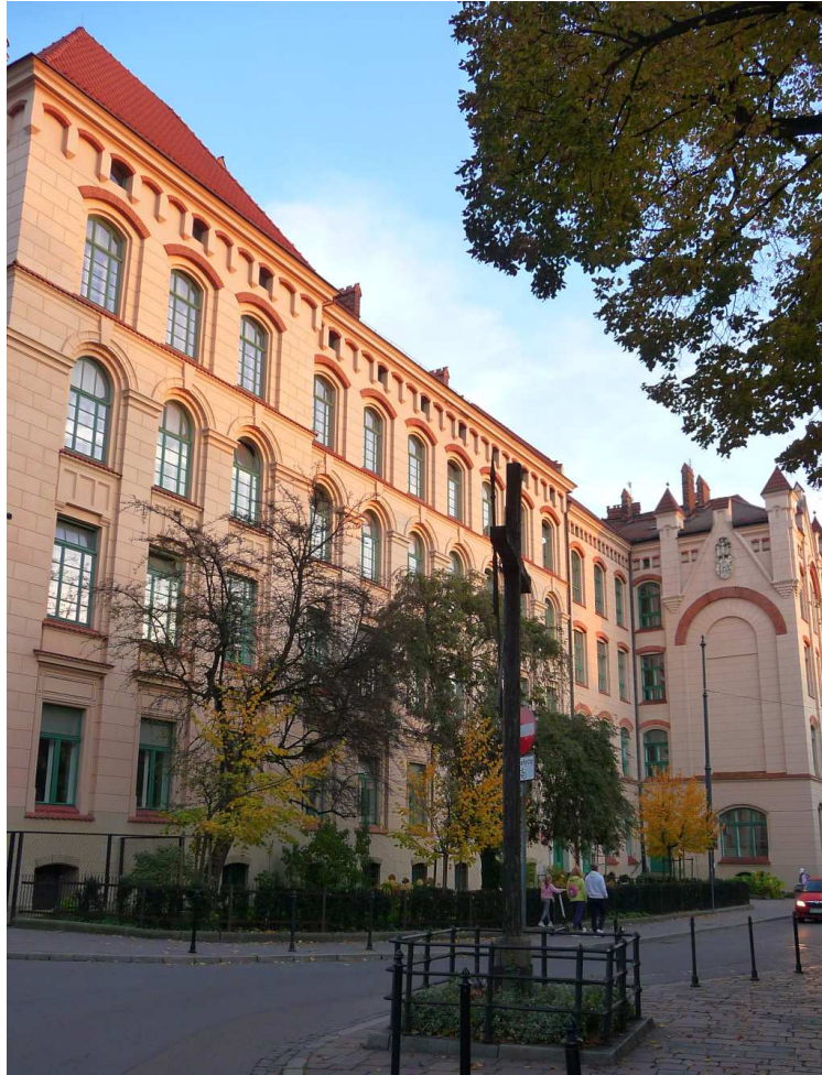
Fot. nr 112. Gmachy Zespołu Szkół Energetycznych przy ulicy Loretańskiej 16 i 18, dzieła Jana Zawiejskiego z I. dekady XX wieku. (27.10.2024)
