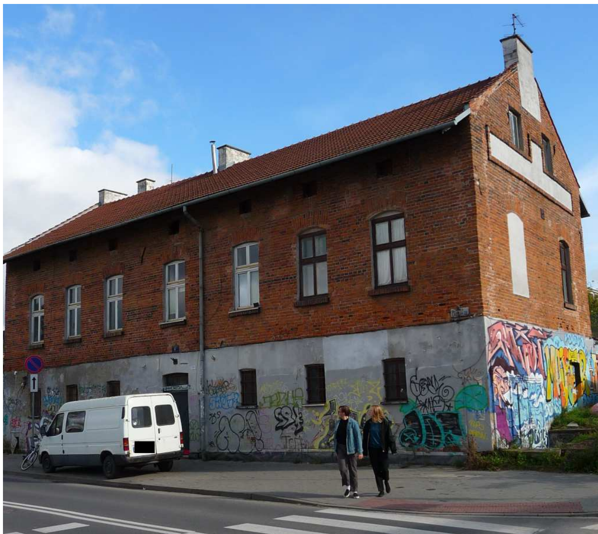
Fot. nr 370 (370-371). Budynek dawnego magazynu wojskowego pod nr 9a. (06.10.2024)
