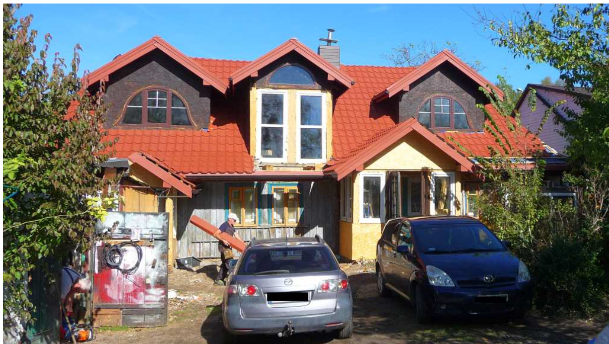
Fot. nr 417. Zapewne blisko 100-letni dom z ulicy Zbrojarzy 55 na etapie przebudowy. (08.10.2024)
