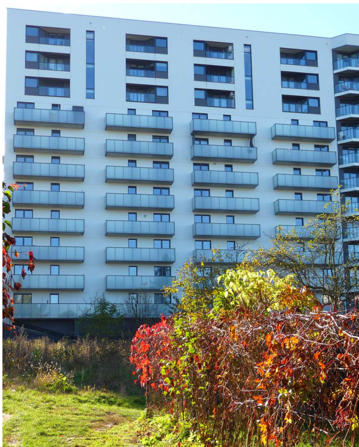
Fot. nr 423 (423-427). Nowe blokowiska przy ulicy Podedworze od nr 9 do 13, dosłownie wlewające się do parku – Fot. nr: 423-425. Widoki od strony Drwinki. (24.10.2024)
