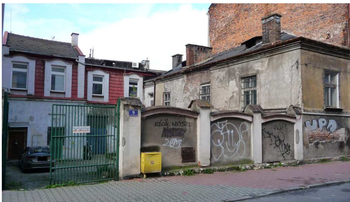
Fot. nr 353. Parterowy dom z początku XX wieku, pod nr 9. (06.10.2024)
