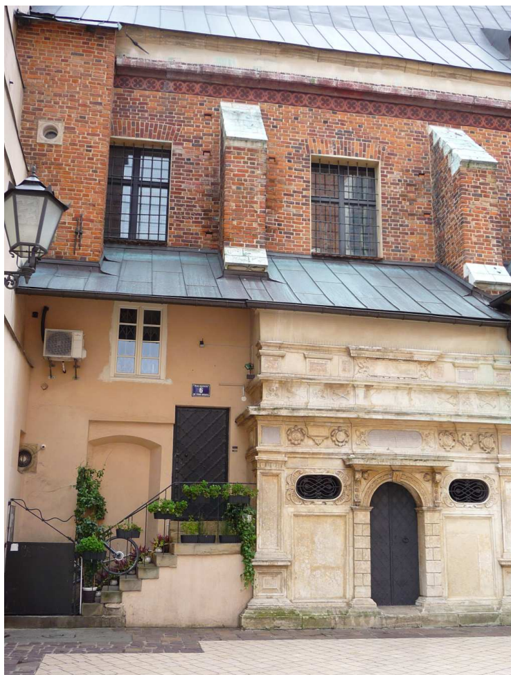
Fot. nr 40. Fragment północnej elewacji kościoła. (03.10.2024)
