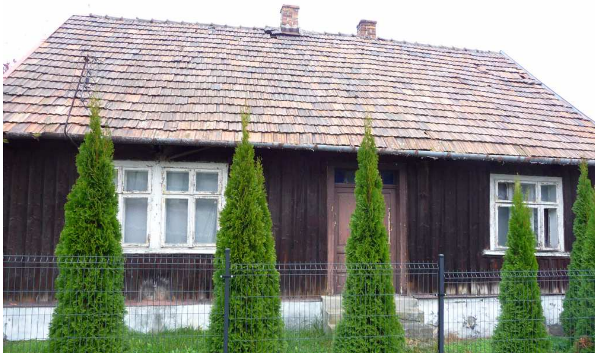
Fot. nr 434. Ciągłe oryginalne okna typu skrzynkowego. (10.11.2024)
