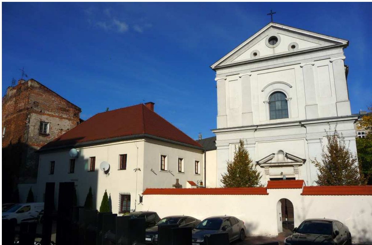
Fot. nr 223 (223-224). Kościół i przylegający do niego budynek parafialny. (23.10.2024)
