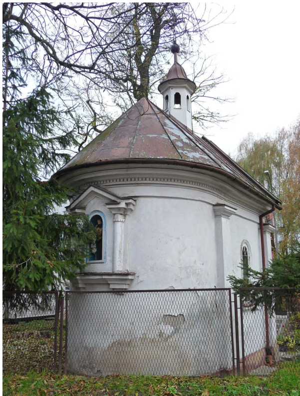
Fot. nr 208. Widok na absydę. (07.11.2024)
