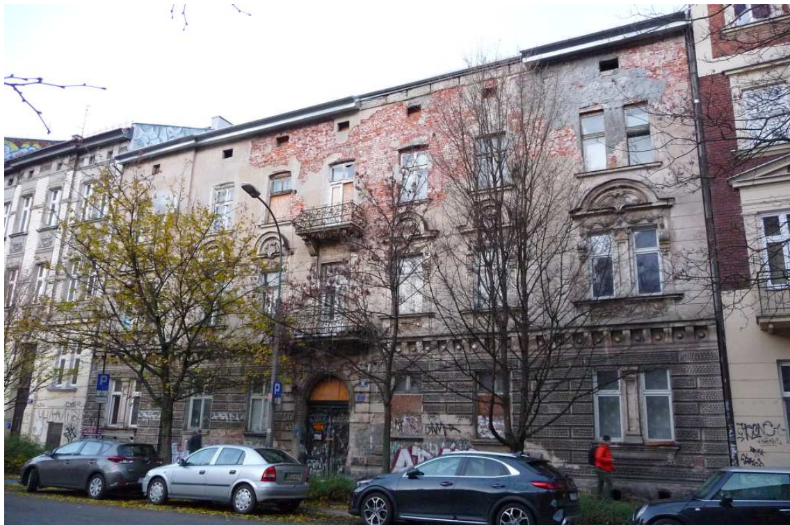
Fot. nr 301. Oczekująca na remont kamienica z ulicy Brzozowej 16. (20.11.2024)
