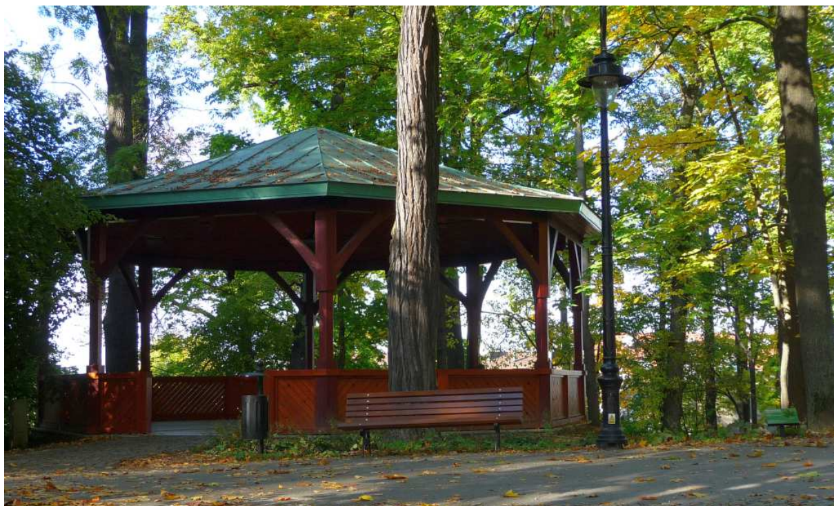
Fot. nr 344. Nowo wybudowana altana. (21.10.2024)
