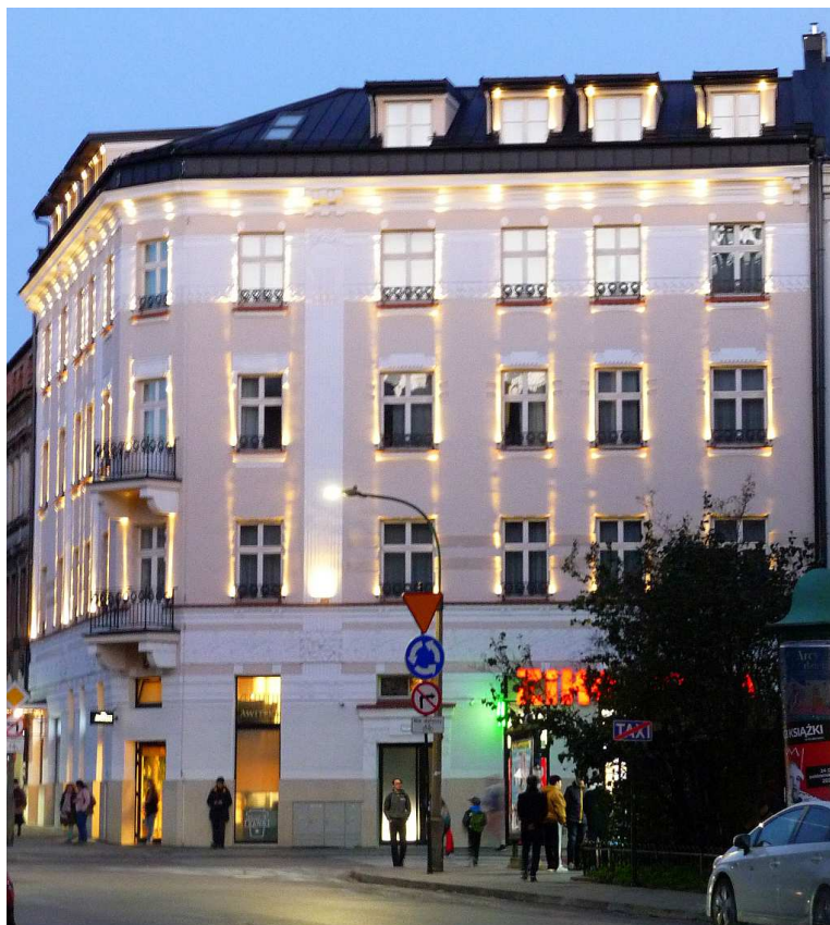
Fot. nr 90. Odnowiona kamienica przy ulicy Garncarskiej 2. (17.10.2024)
