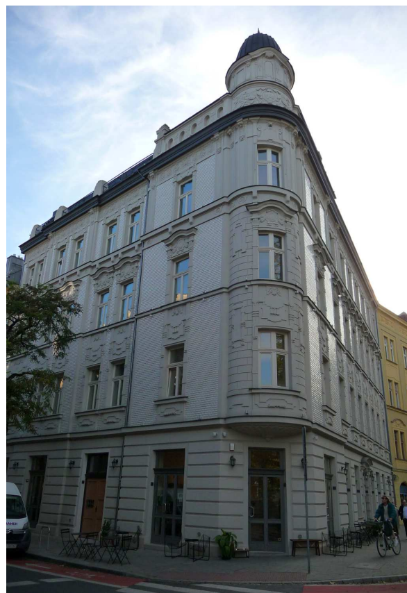
Fot. nr 289. Narożnik kamienicy pod nr 13. (23.10.2024)
