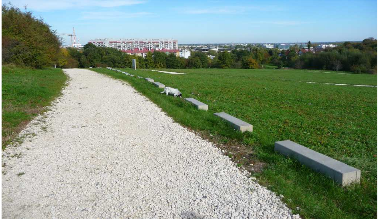
Fot. nr 386. Wysypane grubym żwirem aleje, które są sporym utrudnieniem dla pieszych i osób z wózkami. (08.10.2024)
