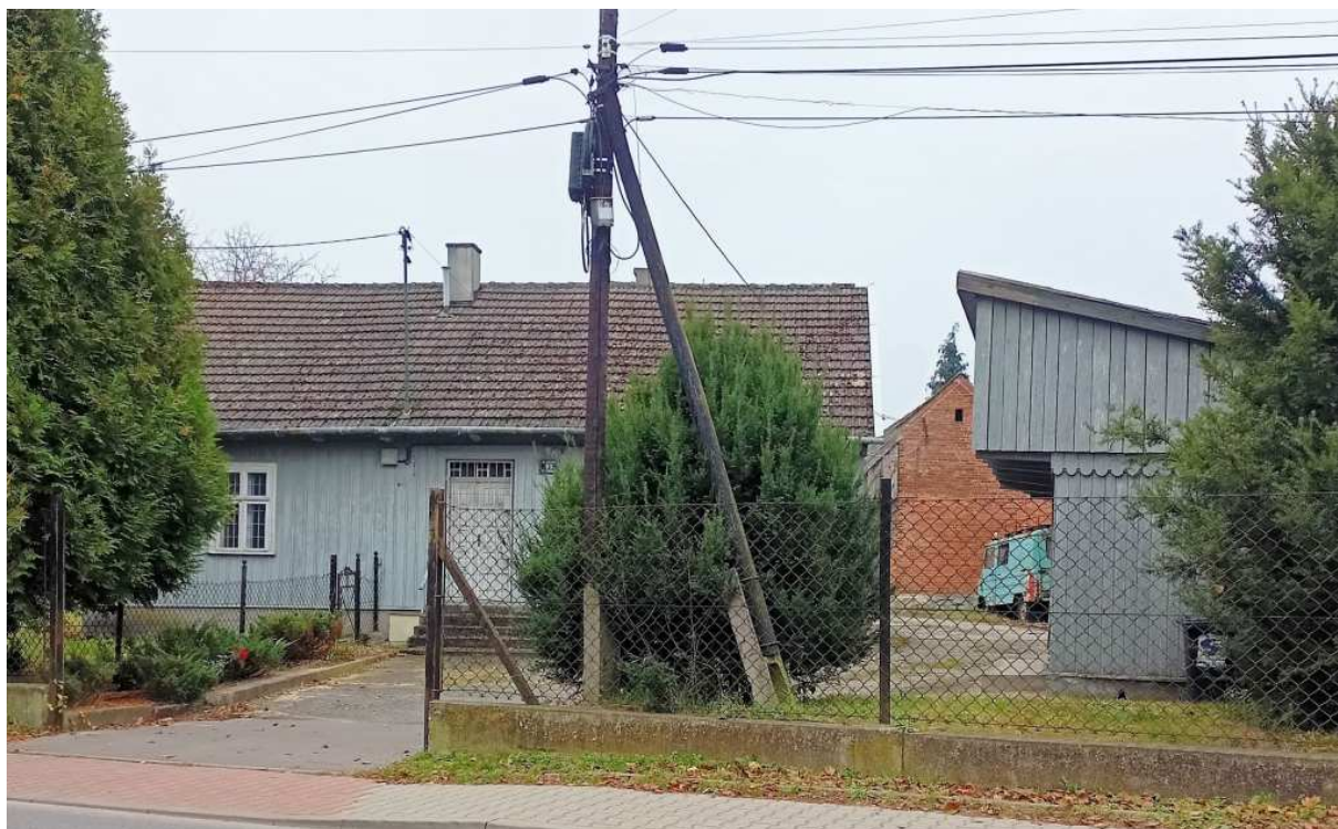
Fot. nr 430. Przedwojenny dom w zagrodzie przy ulicy Łużyckiej 80. (10.11.2024)
