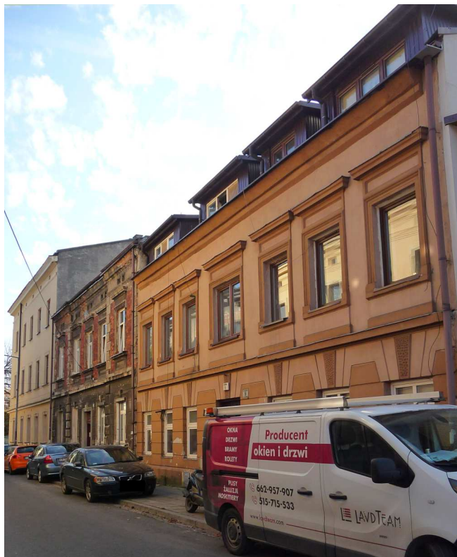
Fot. nr 143. Fragment zabudowy powyżej nr 9. (26.10.2024)
