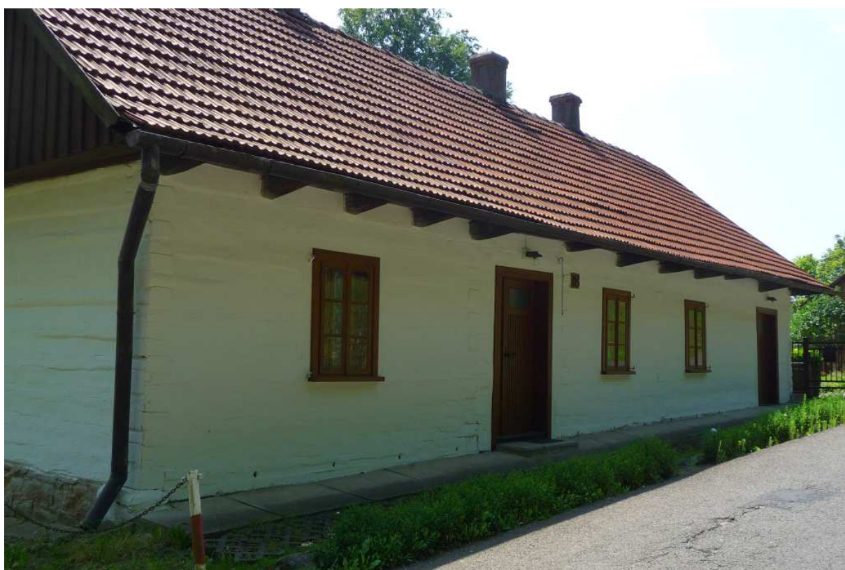
Fot. nr 63. Bielona fasada z oryginalnymi okienkami sześciopłowymi typu ościeżnicowego. (09.07.2024)
