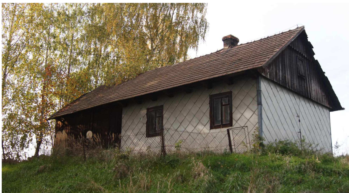
Fot. nr 117 (117-120). Około 100-letnia chałupa pod nr 38. Fot. Joanna Kucharz. Fot. nr: 117-118 – Fasada obiektu, którego ściany zewnętrzne są pokryte szalunkiem z eternitowych rybich łusek. Część mieszkalna w jednym korpusie ze stodołą. (06.11.2024)
