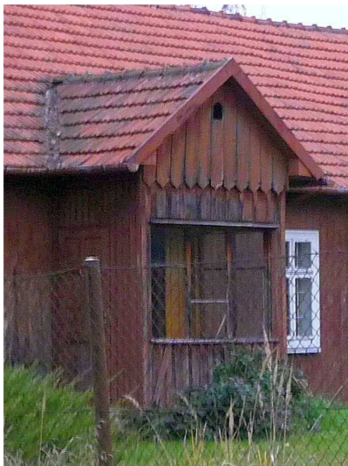
Fot. nr 111. Nieco już przekształcony ganek, kiedyś zapewne przeszklony. (31.10.2024)
