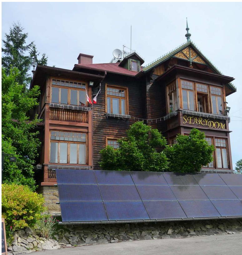
Fot. nr 42 (42-44). Fasada obiektu. (26.06.2024)
