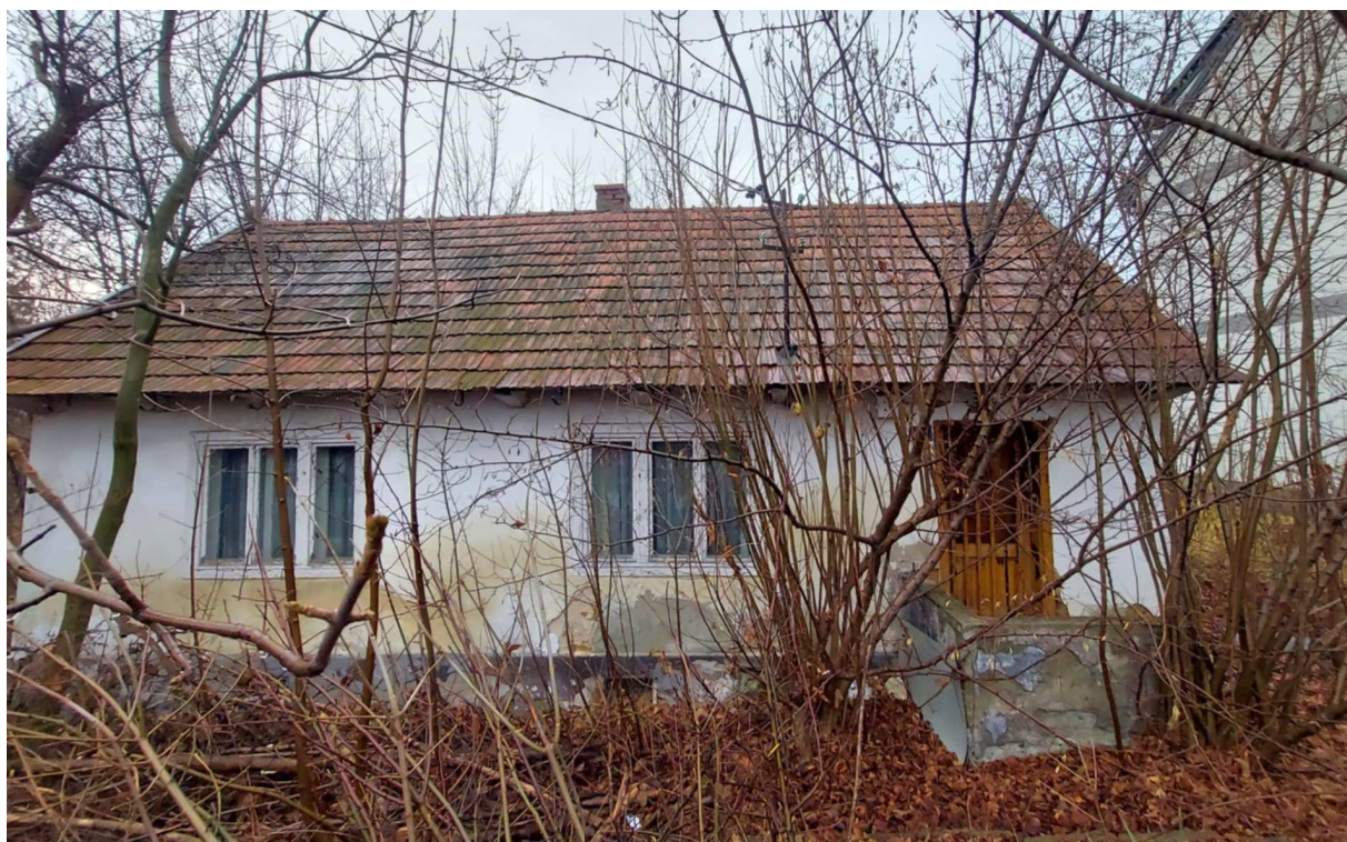
Fot. nr 139. Fasada z nieoryginalnymi już oknami. (04.12.2024)
