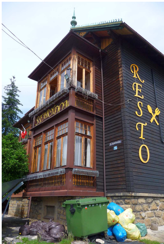
Fot. nr 44. Wykusze w prawym fragmencie fasady. (26.06.2024)
