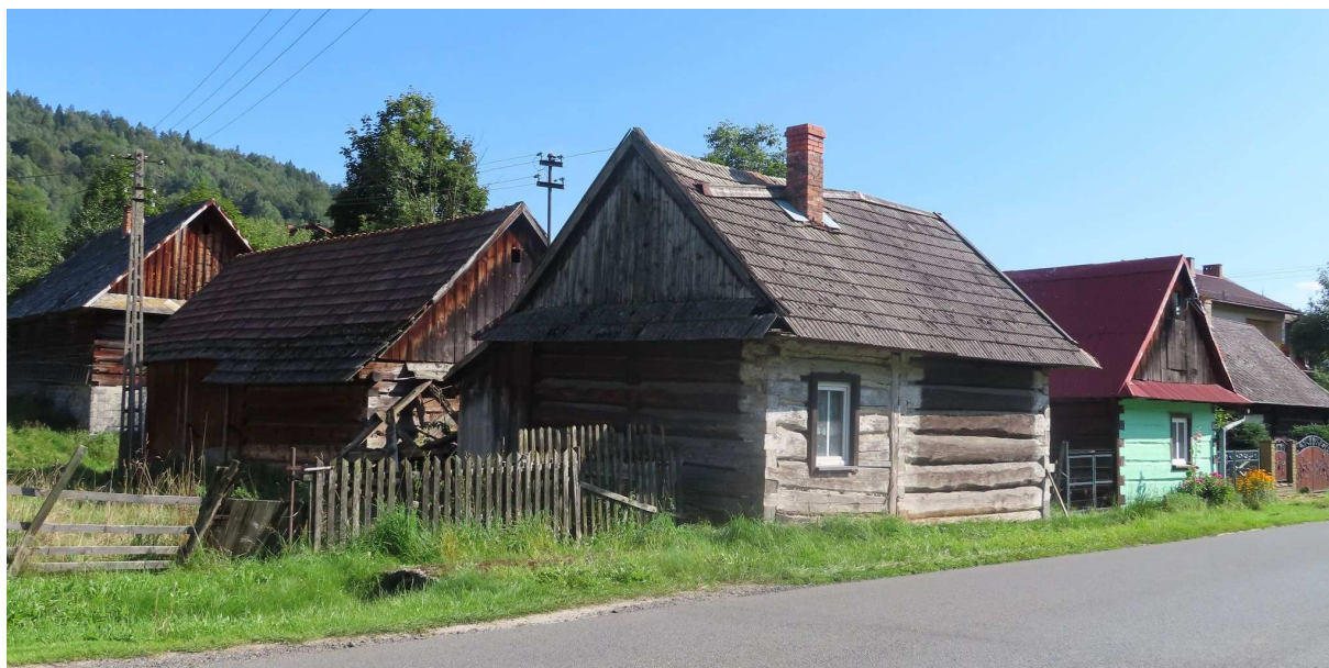
Fot. nr 176 (176-177). Fragment tradycyjnej zabudowy ulicówki. (13.09.2023)
