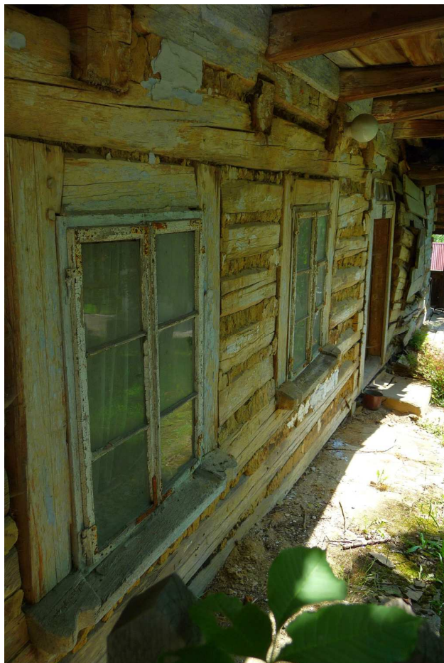
Fot. nr 60 (60-61). Fasada z oryginalnymi oknami typu ościeżnicowego. (09.07.2024)
