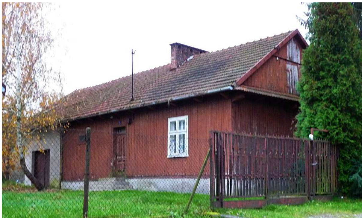
Fot. nr 112. Tylne fragment domu, którego ściany są pokryte drewnianym szalunkiem, a okno jest typu skrzynkowego. (31.10.2024)
