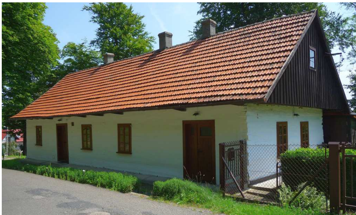
Fot. nr 64 (64-65). Narożnik obiektu. (09.07.2024)
