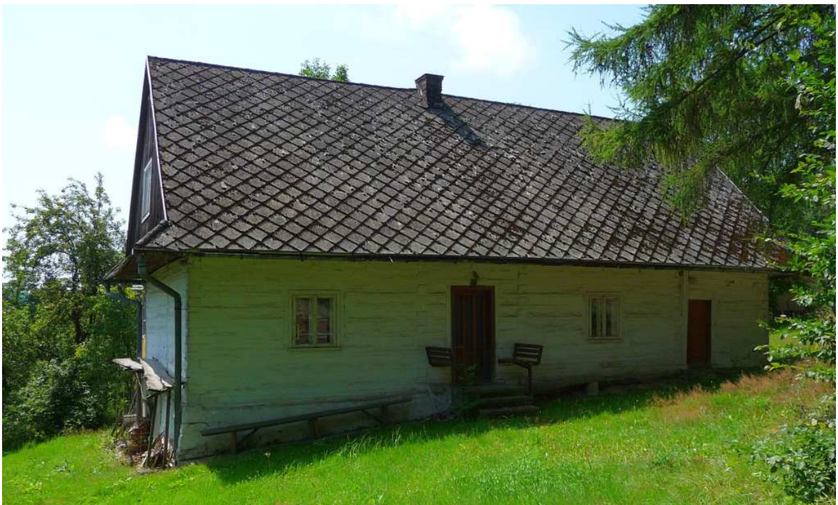
Fot. nr 75 (75-79). Oryginalna, ciągle solidnie bielona na glinianej polepie ściana fasadowa chałupy pod nr 21, z archaicznymi okienkami dwupolowymi typu ościeżnicowego. Chałupa ostatnia w ciągu obiektów, jest zapewne dwutrakowa, z przelotową sienią i komórką gospodarczą na skraju. W przybliżeniu można ją datować na ostatnią ćwierć XIX wieku. (09.07.2024)
