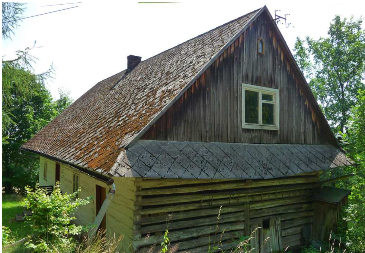
Fot. nr 77. Narożnik, z przylegającą do ściany szczytowej komórką. (09.07.2024)
