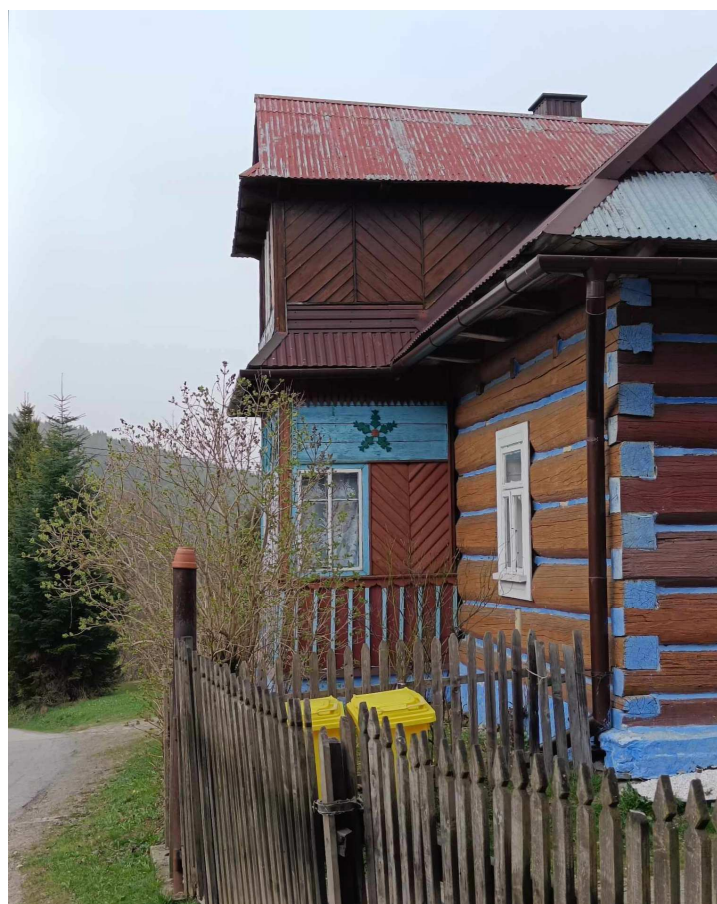
Fot. nr 175. Oryginalne okienko trójskrzydłowe. (31.03.2024)
