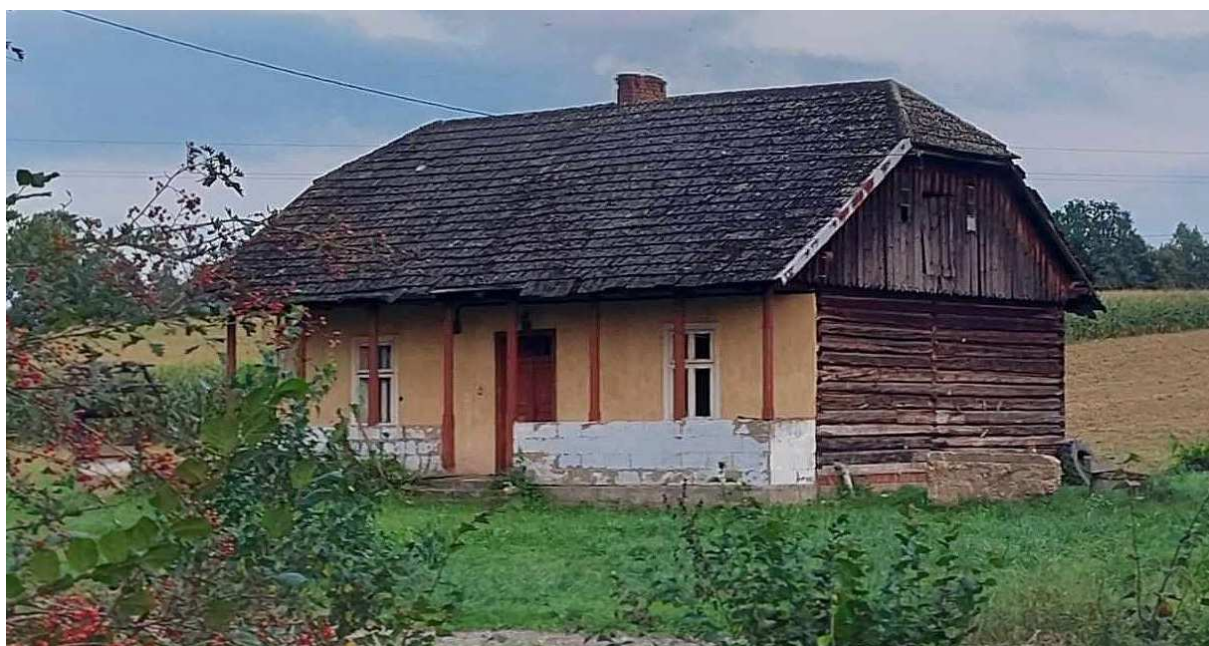
Fot. nr 151. Drewniany dom z okapowym dachem wspartym na słupach, z otynkowaną już fasadą, na posesji obok działki pod nr 4. (27.08.2024)
