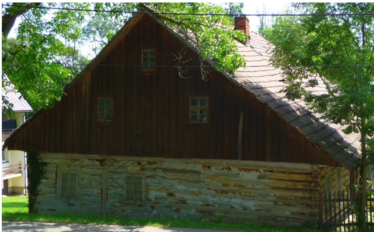
Fot. nr 58. Boczna ściana szczytowa, z zachowanymi fragmentami bielenia na glinianej polepie. (09.07.2024)
