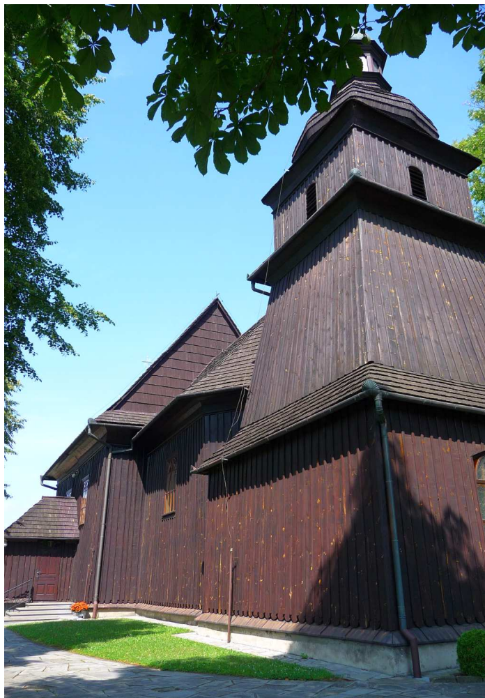
Fot. nr 85. Widok od strony dzwonnicy. (26.06.2024)
