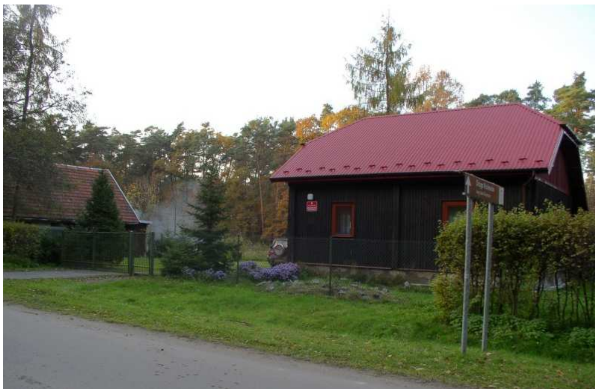
Fot. nr 165. Stąd można rozpocząć wypad w głąb Puszczy. (23.10.10)
