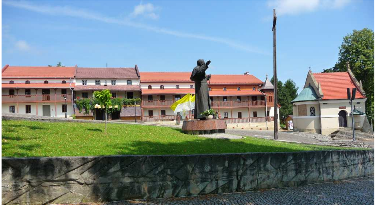
Fot. nr 4 (4-9). Zabudowa północnego fragmentu placu przed bazyliką Matki Boskiej Anielskiej o nr: 38-44, a z prawej kaplica św. Rafała. (09.07.2024)
