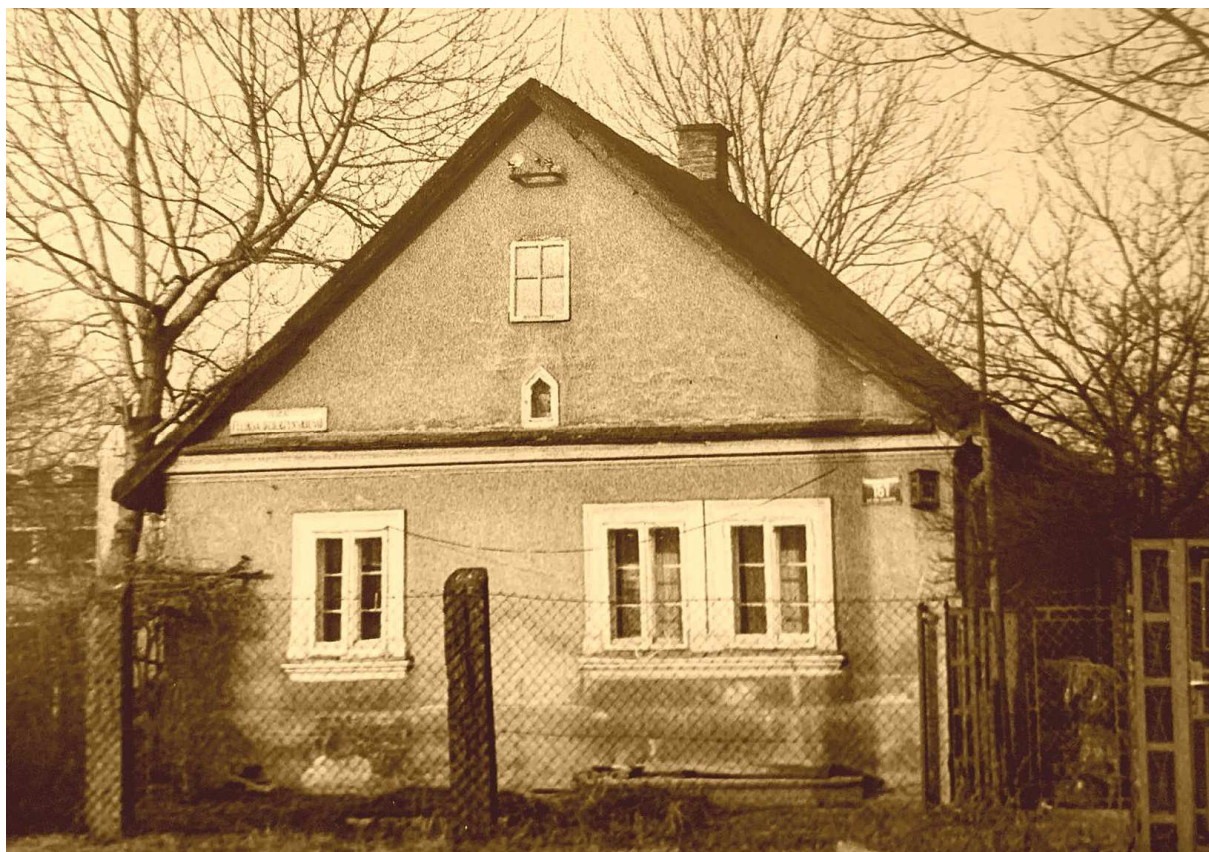
Fot. nr 197. Łobzów – Ściana szczytowa domu przy ulicy Lea 161. (lata 70.)
