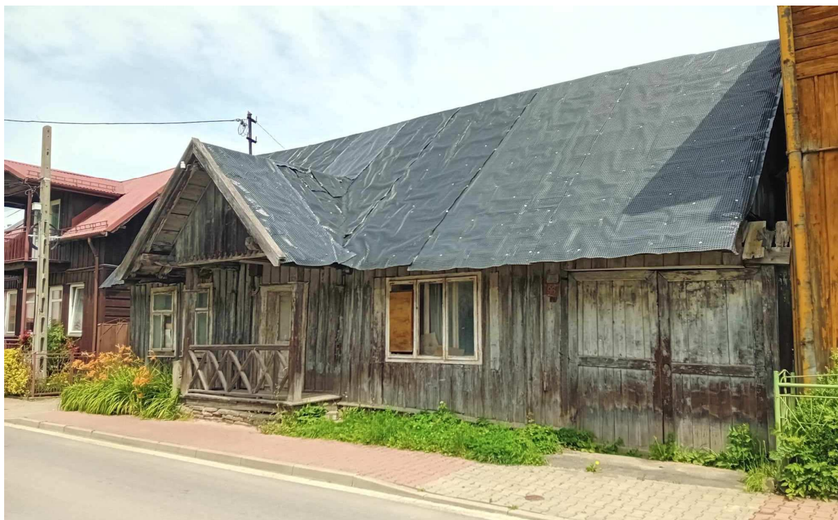
Fot. nr 179 (179-181). Ok. 90-letni dom z gankiem z ulicy Zdrojowej. (15.07.2024)
