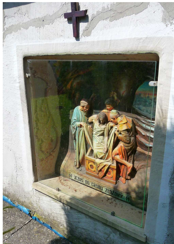
Fot. nr 85 (85-98). Stacje drogi krzyżowej posadowione w kamiennym murze z roku 1863, otaczającym kościół. (09.07.2024)
