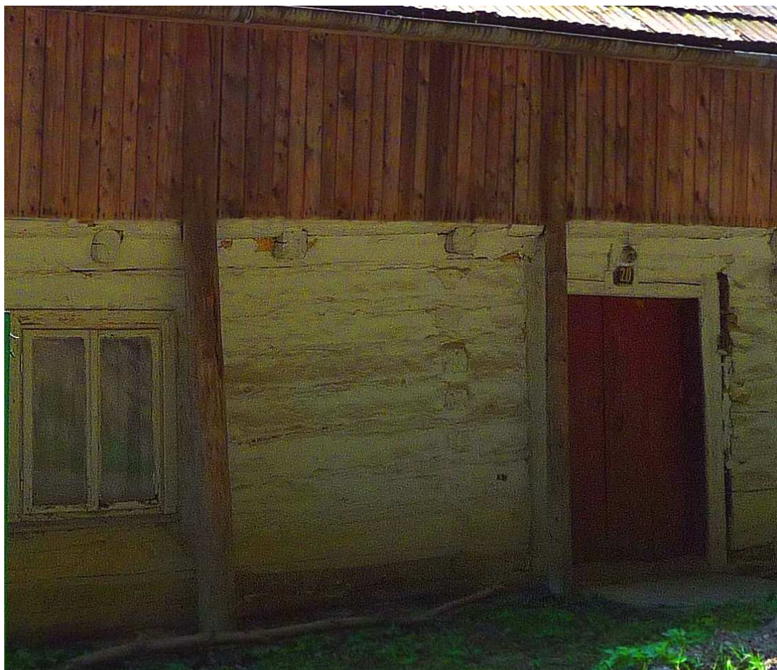
Fot. nr 72. Fragment bielonej ściany frontowej, w której drzwi są już współczesne, a okno jest nieco późniejsze. (09.07.2024)
