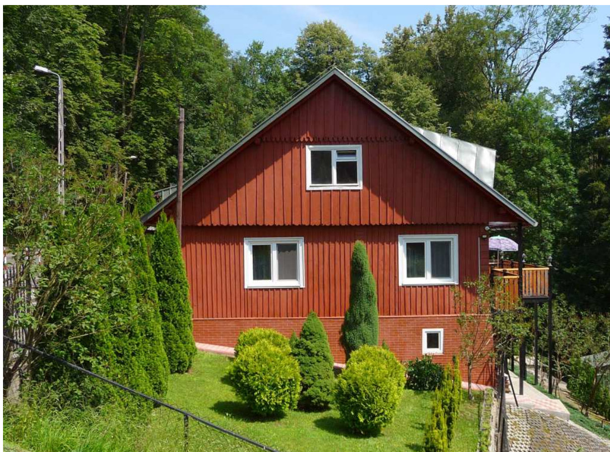
Fot. nr 55. Ściana szczytowa. (09.07.2024)
