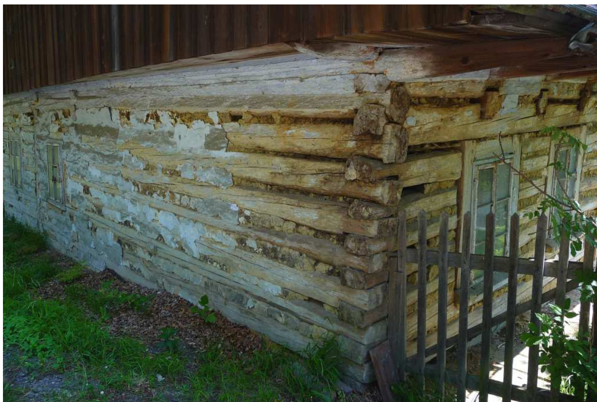
Fot. nr 59. Narożnik ściany szczytowej z fasadą, w nim odsłonięte detale konstrukcji zrębowej. (09.07.2024)
