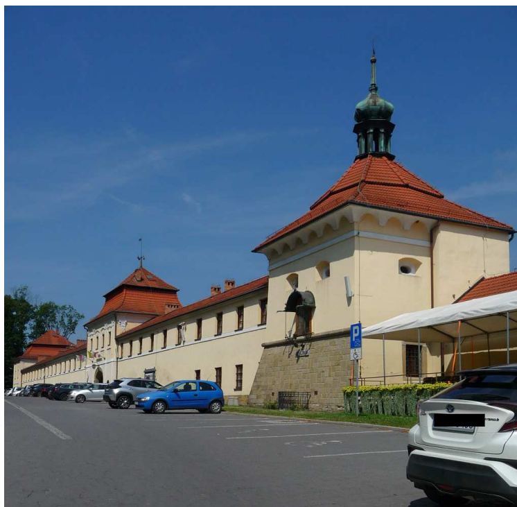
Fot. nr 31. Widok od strony kościoła. (09.07.2024)
