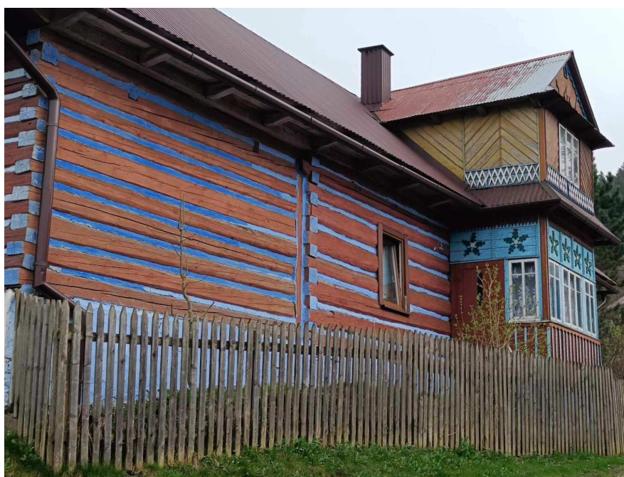
Fot. nr 171. „Ogacone” belki malowane w naprzemiennych kolorach z wypełnieniem. (31.03.2024)
