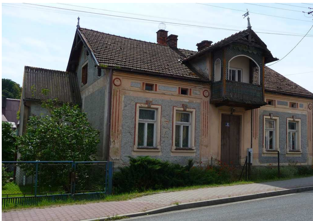
Fot. nr 102 (102-104). Wybudowany w roku 1923 dom z profilowaną w drewnie facjatą w kształcie podwieszonego ganku, pod nr 2. (26.06.2024)
