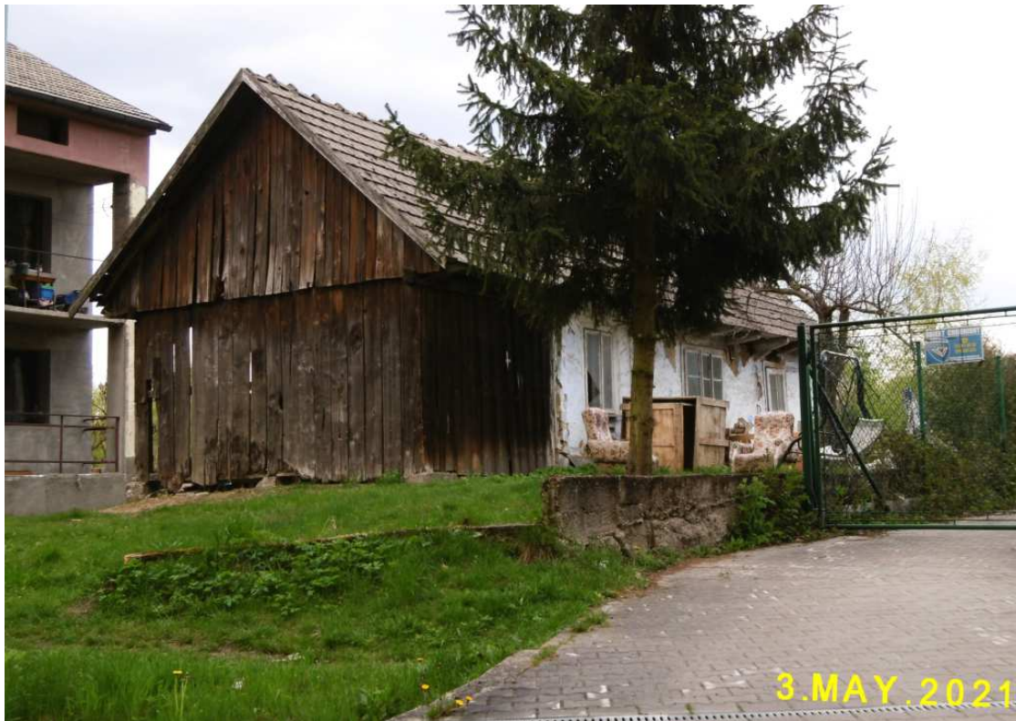
Fot. nr 166 (166-168). Archaiczna, wiejska chałupa spod nr 178. Część mieszkalna w jednym korpusie z częścią gospodarczą.
