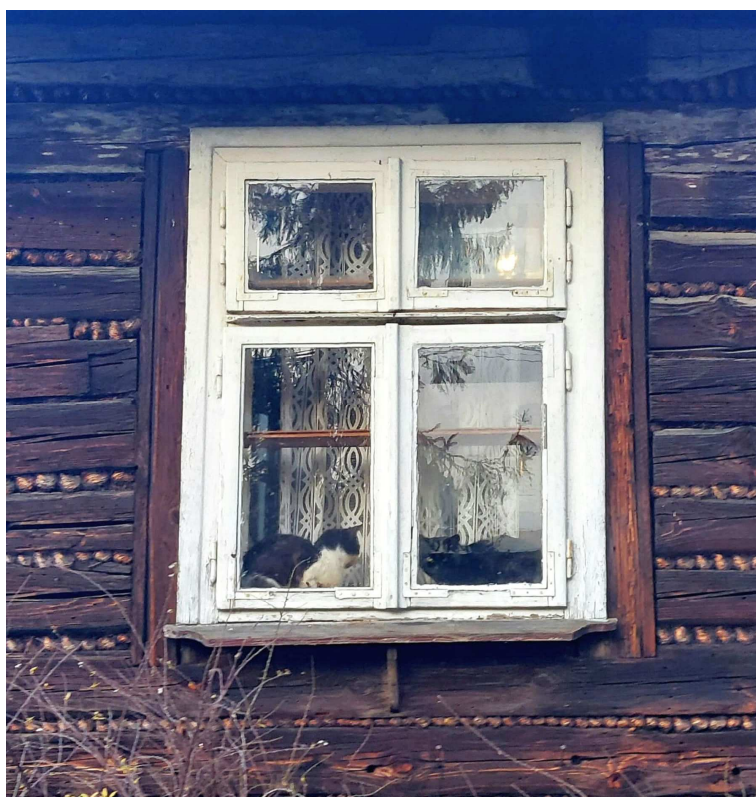
Fot. nr 131. Oryginalne okno typu skrzynkowego. (29.11.2024)
