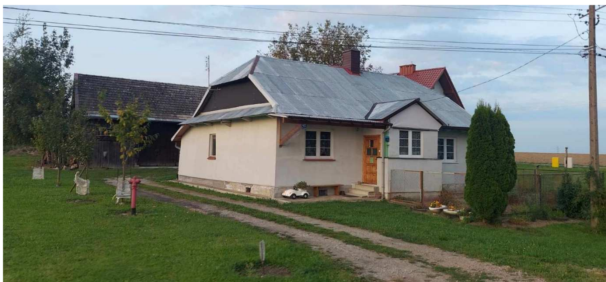
Fot. nr 149. Znacznie przebudowany już dom z zagrodzie pod nr 92. (27.08.2024)
