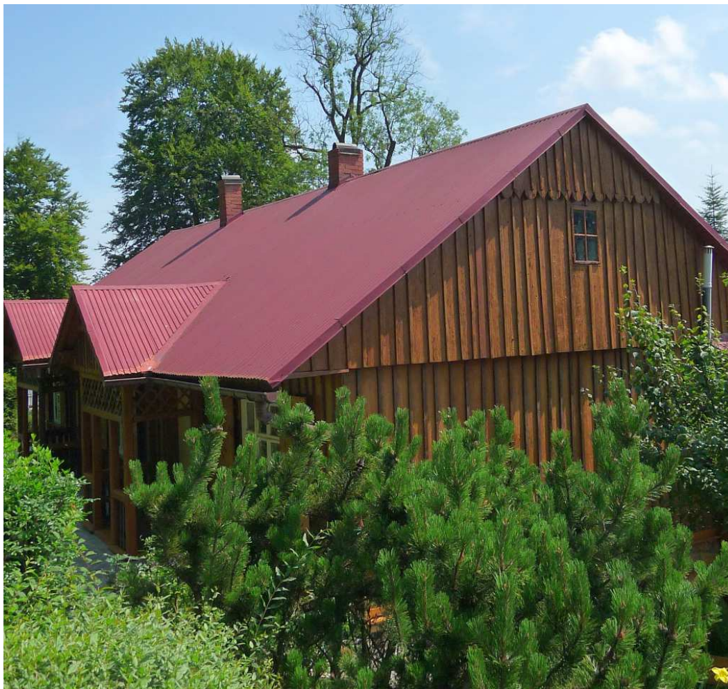
Fot. nr 70. Oszalowana deskami ściana szczytowa, pod którą zapewne kryje się drewniana faktura. (09.07.2024)
