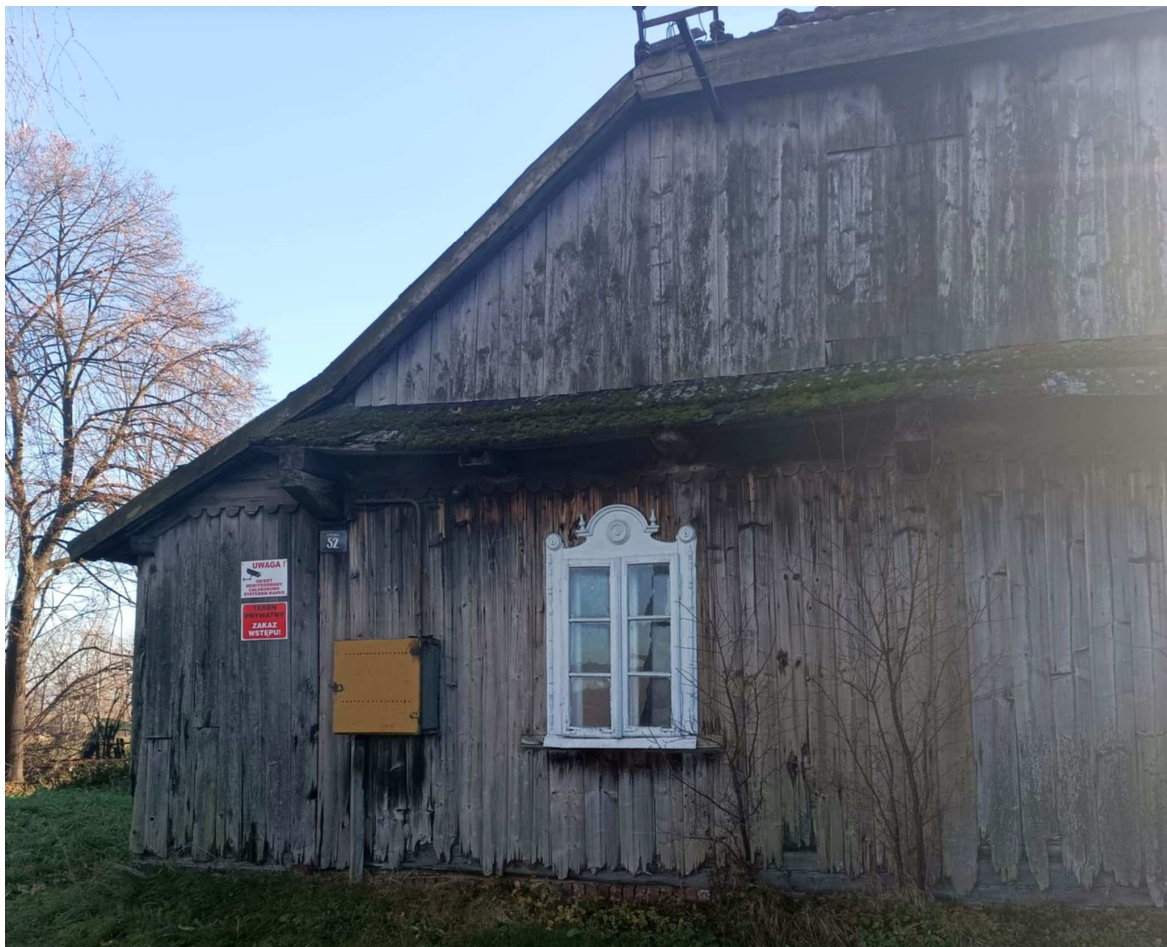
Fot. nr 125 (125-126). Fragment ściany szczytowej od strony drogi i jej detale. Ozdobne obramienie okna profilowane w drewnie, nieczęsto spotykane. (04.12.2024)
