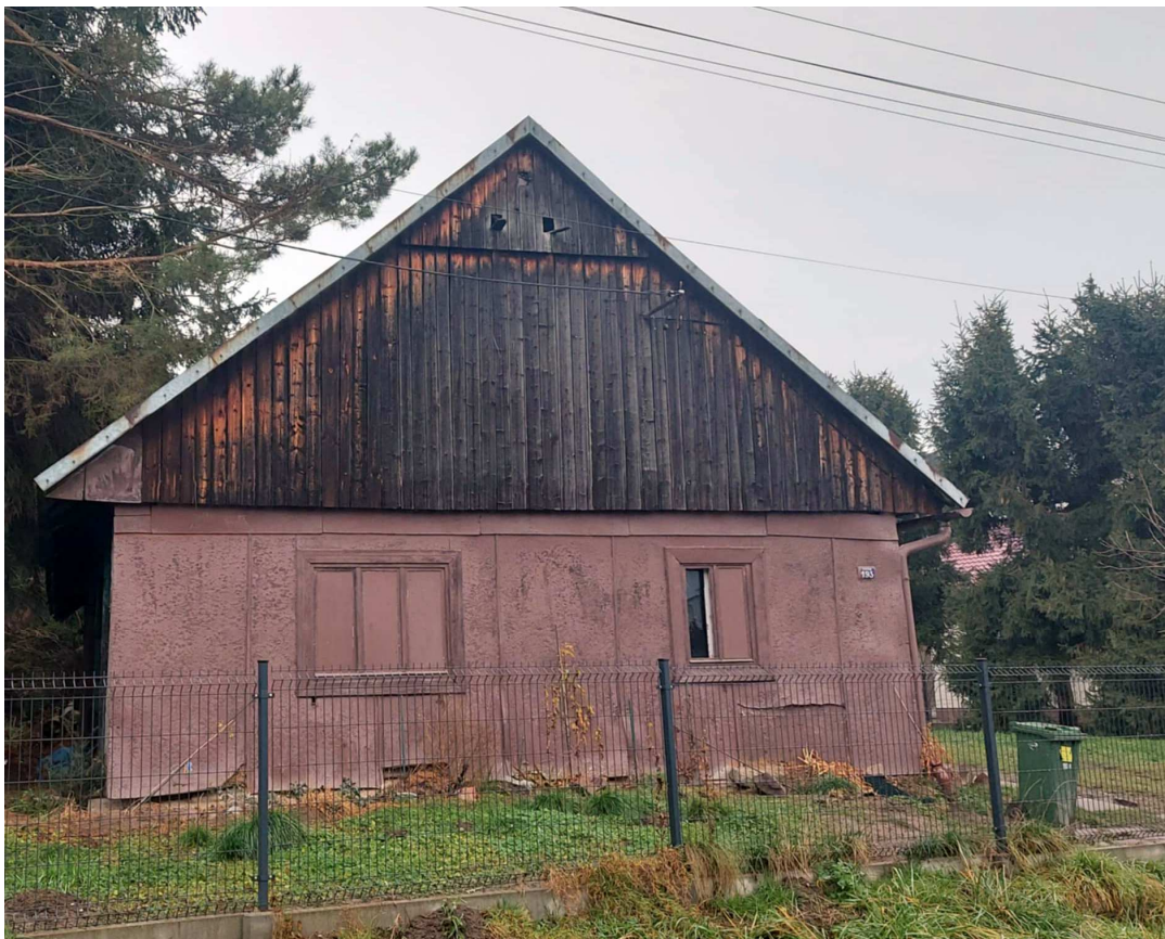
Fot. nr 137. Ściana szczytowa. (04.12.2024)
