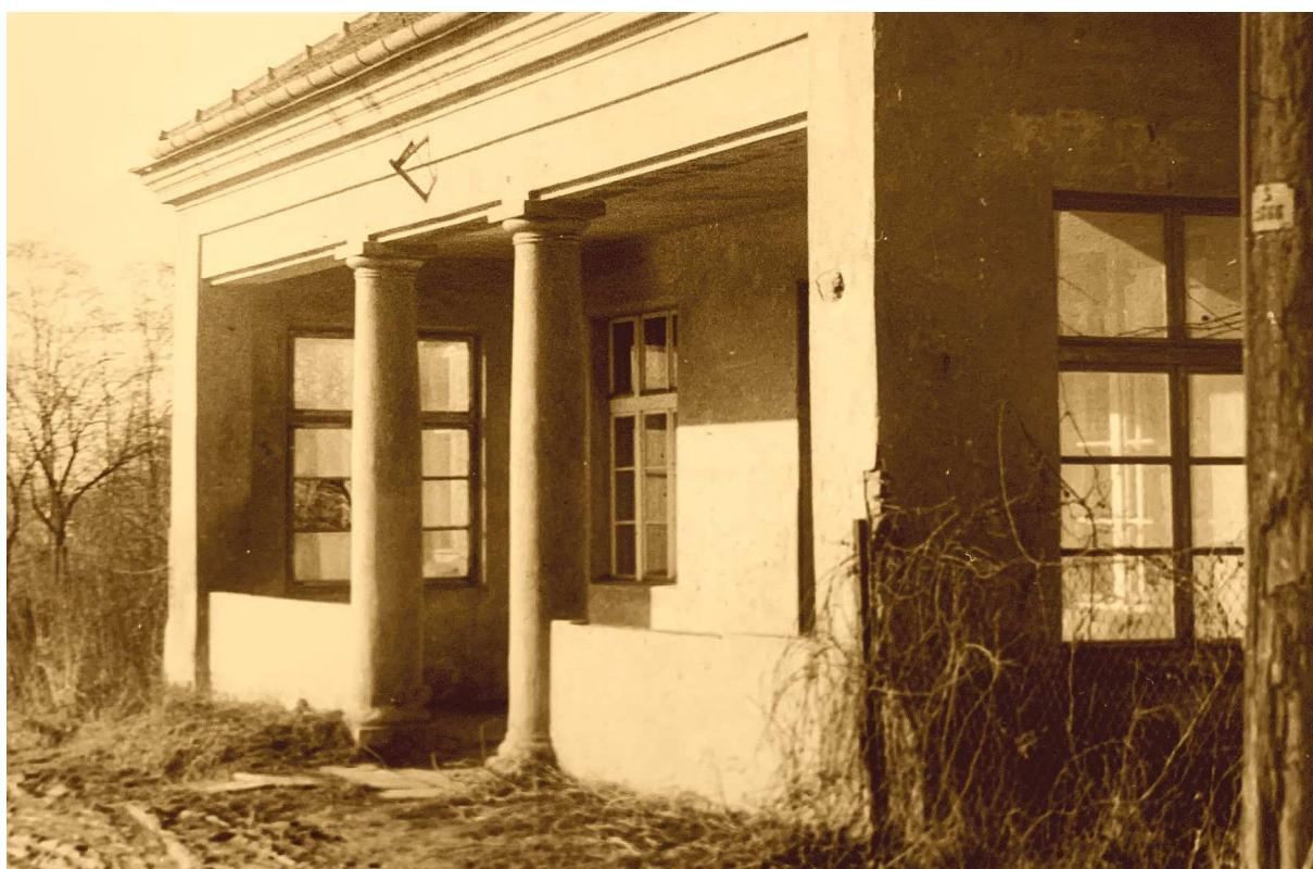
Fot. nr 218. Pychowice – dawna roгатka z ulicy Tynieckiej 46. (lata 70.)
