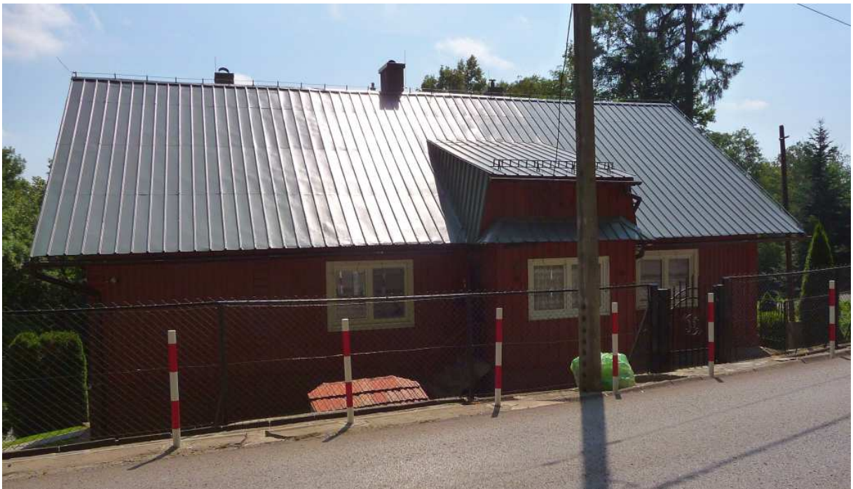
Fot. nr 53 (53-55). Pierwszy z sześciu obiektów we fragmencie wsi Bugaj na styku z Kalwarią Zebrzydowską, które tworzą swoisty skansen etnograficzny in situ. Dom, zapewne niespełna 100-letni dom z gankiem, który zachował swój dawny kształt, ale okna o współczesnych podziałach, są już z innej epoki. Fot. nr 53-54. Fasada od strony drogi. (09.07.2024)
