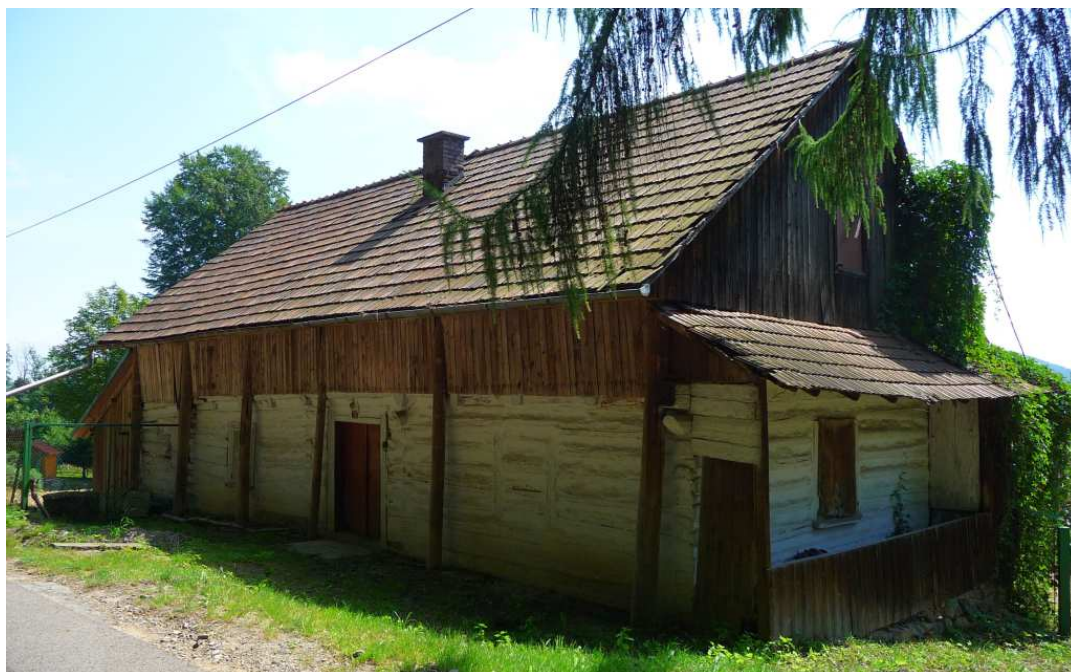
Fot. nr 73. Fasada i narożnik archaicznej chałupy, w której część mieszkalna i gospodarcza znajdują się we wspólnym korpusie. Jej los wydaje się zagrożony. (09.07.2024)
