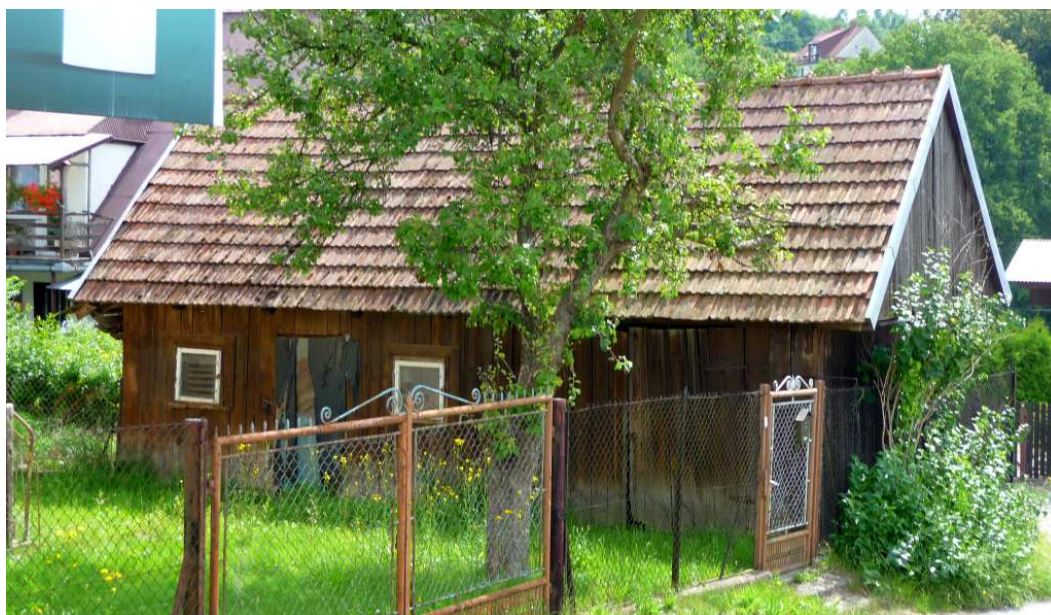
Fot. nr 105. Tylony fragment zapewne pomieszczenia gospodarczego: stodoły ze stajnią we wspólnym korpusie, na posesji poniżej domu pod nr 2. (26.06.2024)
