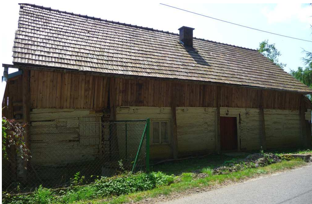
Fot. nr 71 (71-74). Leciwa, z podwyższonym dachem w stosunku do dawnego oryginału, zapewne wybudowana w II. połowie XIX. wieku, chałupa pod nr 20. (09.07.2024)
