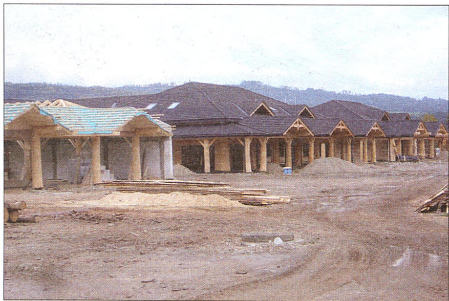
Fot. 6. Budowa stałych obiektów handlowych na targowisku przy ulicy Targowej w 2015 r., fot. K. Miraj
