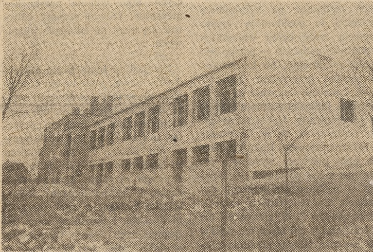
W Łabędziach rozbudowuje się Szkołę Podstawową; prace budowlane — w toku
