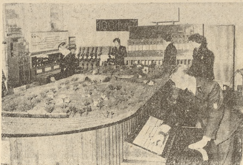
Sala przedmiotowa urządzeń zabezpieczenia ruchu kolejowego
