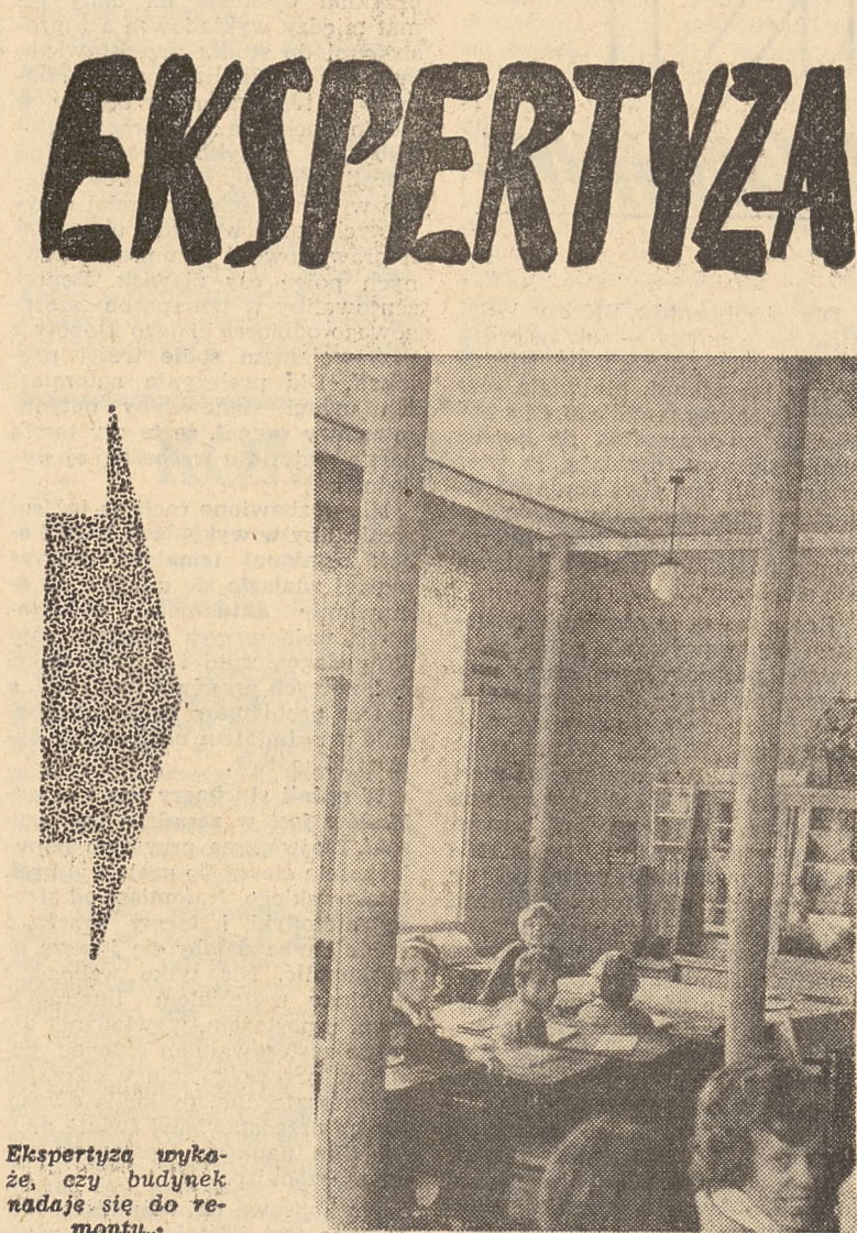
Ekspertyza wykazała, że budynek nadaje się do remontu...
