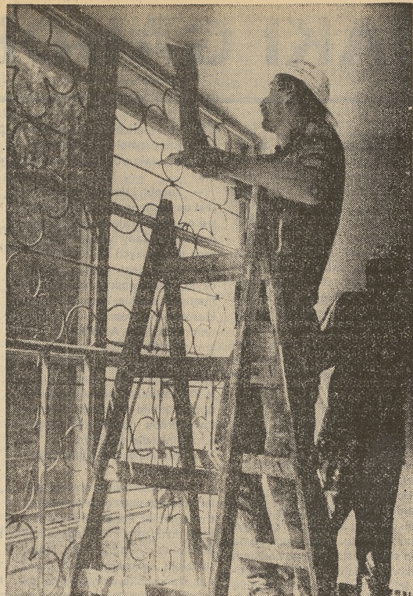
Remont Szkoły Podstawowej nr 229 w Warszawie.
