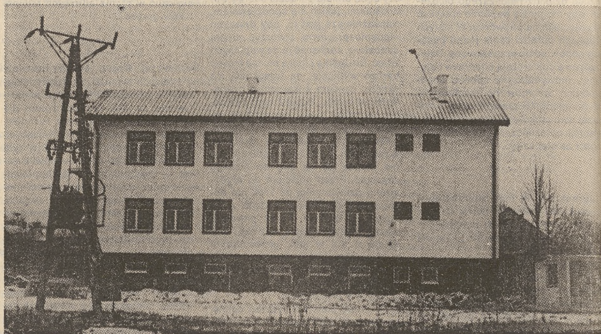
Tę piętrową, podpiwniczoną szkołę wybudowano w pięć miesięcy.
