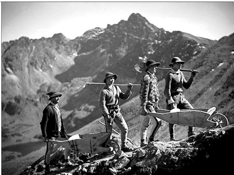
Budowa kolejki linowej z Kuźnic na Kasprowy Wierch
