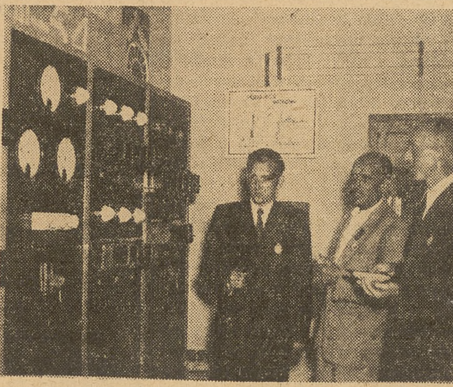
NA zdjęciu: producujący nauczyciele szkół zawodowych z woj. warszawskiego, odznaczani na konferencji sierpniowej srebrnymi krzyżami za zasługi. Marian Olbrycht i Stefan Świątalski oraz wizytator DOSZ Franciszek Kozłowski oglądają tablice rozdzielczą, wykonaną przez uczniów Zasadniczej Szkoły Metalowo-elektrycznej przy ul. Okopowej w Warszawie.
