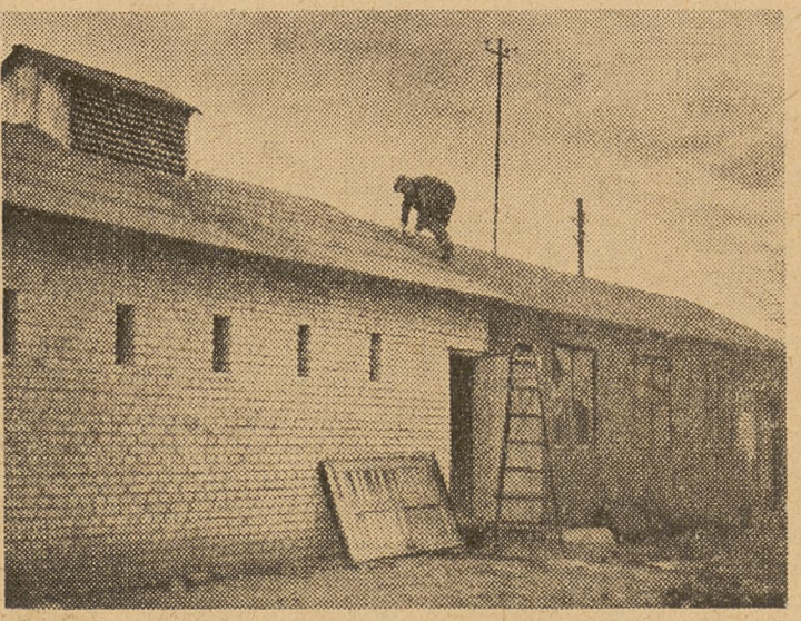
bo tyleż lat trwa budowa tego ustępu w Szkole TPD nr 6 w Pruszkowie
