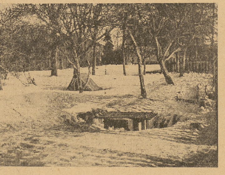
A w Szkole nr 2 w Pruszkowie od dwu lat zieje na dziedzińcu otwór przyszłej studni...
