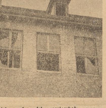
Oplek nad częścią zamieszkałą „sprawuje” Pow. Wleobranowa Spółdzielnia Pracy Usług Różnych w Wałcu. Jak sprawuje — widzieliśmy na zdjęciu. Wszystkie szyny na i pietro są wybite, do sal wpada śnieg i deszcze i niszczą stropy części zamieszkałej. Centralne ogrzewanie niewyremontowane do dziś do końca. Ubikacje montowane i niezabezpieczone przed mrozem. Przy drzwiach brak klamek, płytki podłogi ruszają się jak klawiatura. Dymiący kocioł zacządza całą szkołę.
