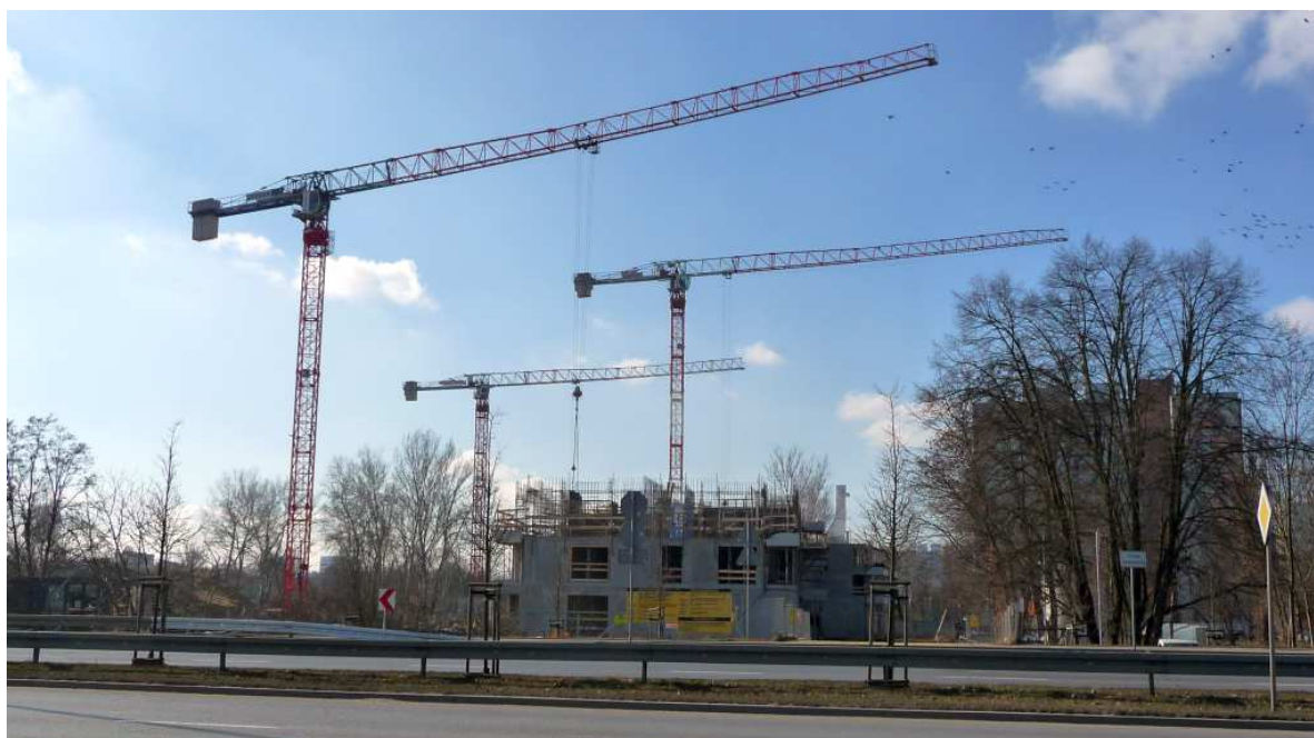
Fot. nr 532. Nowo powstający kompleks hotelowy przy ulicy Konopnickiej, na styku z osiedlem Podwawelskim. (17.02.2025)
