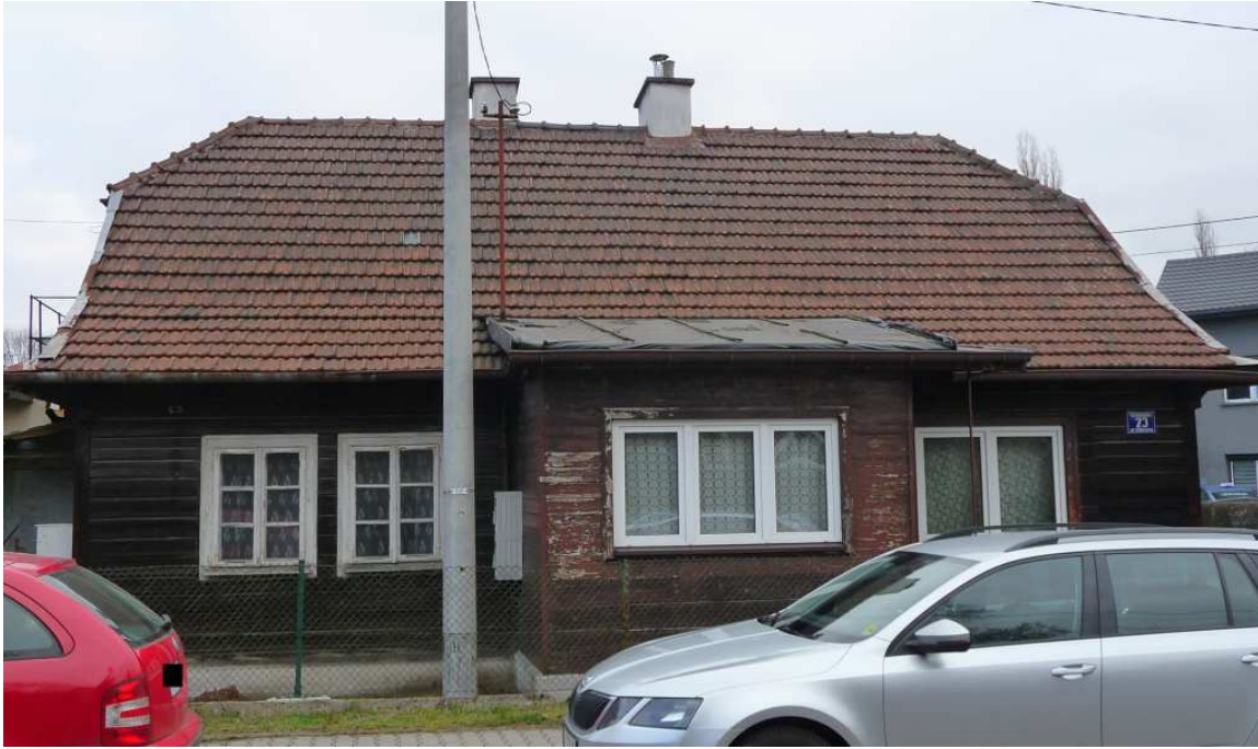
Fot. nr 337. Częściowo przebudowana fasada. (02.02.2025)
