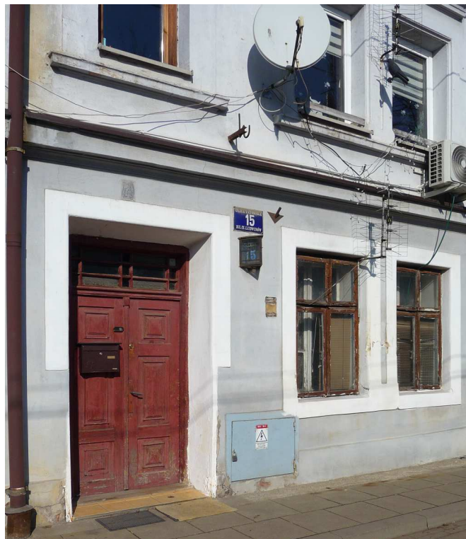
Fot. nr 522 (522-523). Dom pod nr 15 i jego detale. (17.02.2025)
