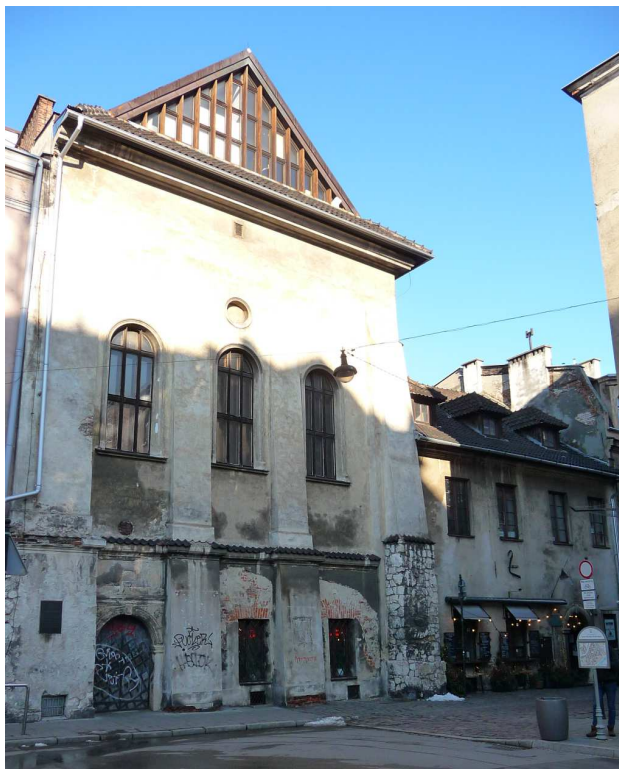
Fot. nr 414. Bożnica Wysoka pod nr 38. (17.01.2025)
