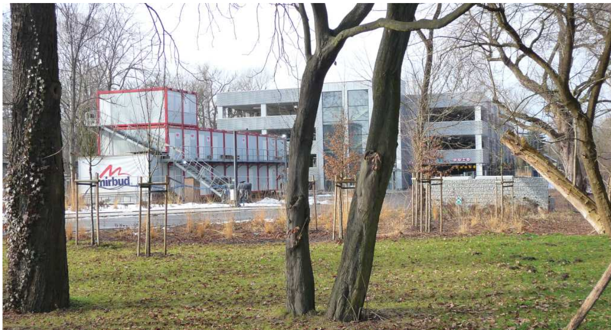
Fot. nr 183 (183-184). Centrum Muzyki przy ulicy Piastowskiej na etapie budowy. (25.01.2025)
