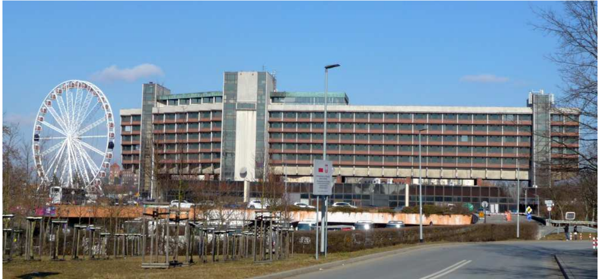
Fot. nr 533. Dawny Hotel Forum, który jest już wpisany do Rejestru Zabytków. (17.02.2025)
