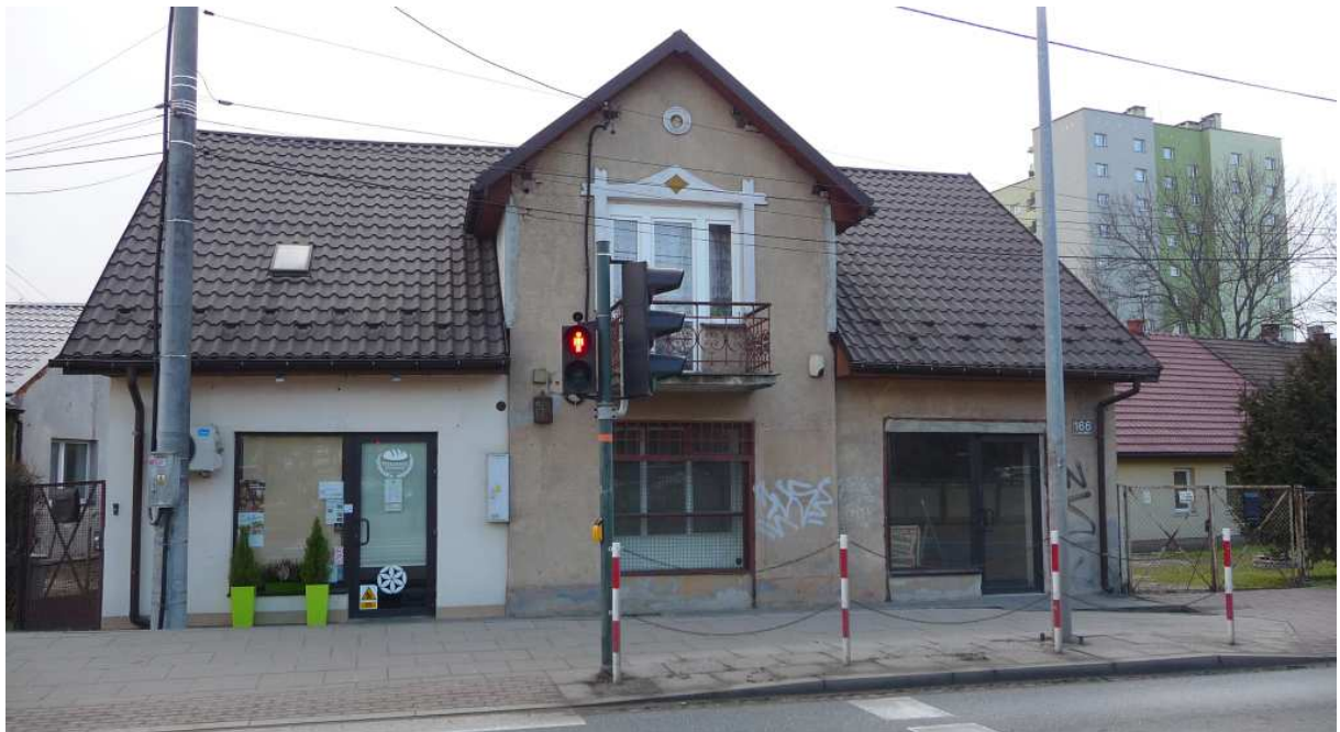
Fot. nr 322. Zniekształcona już fasada domu przy alei JP II 166. (02.02.2025)
