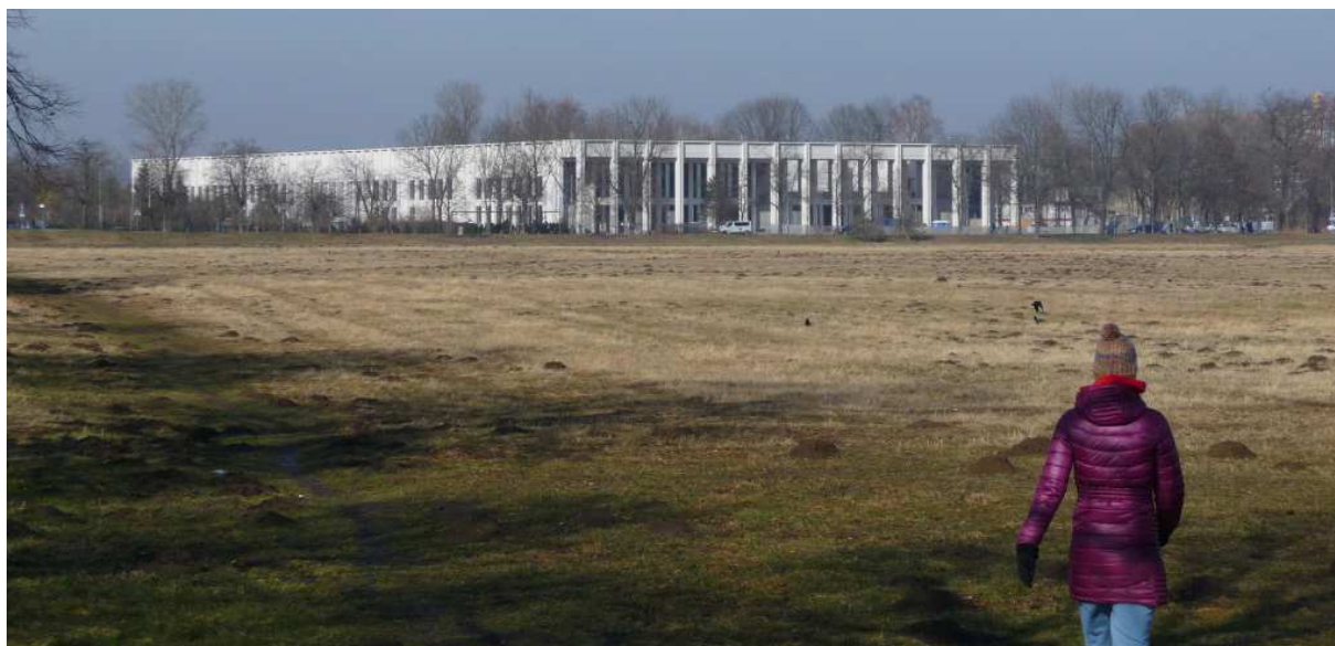
Fot. nr 204. Budowa Centrum Muzyki przy ulicy Piastowskiej. (25.02.2025)
