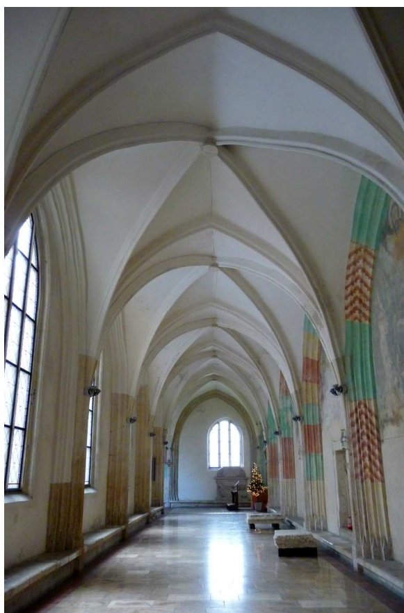
Fot. nr 480 (480-482). Skrzydło północne. (06.01.2025)
