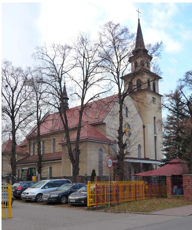
Fot. nr 327 (327-328). Kościół p.w. św. Tadeusza Judy pod nr 6, wybudowany w latach 1936-42 wg. projektu Leopolda Poleskiego; wieża dobudowana w latach 1889-91. (02.02.2025)
