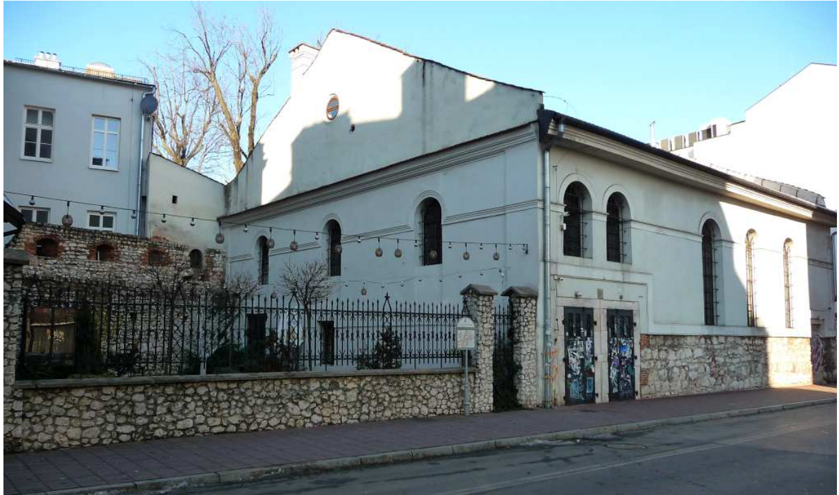
Fot. nr 401 (401-403). Bożnica Kupa przy ulicy Warszawiera 8 i przylegający do niej fragment średniowiecznego muru obronnego Kazimierza. (17.01.2025)
