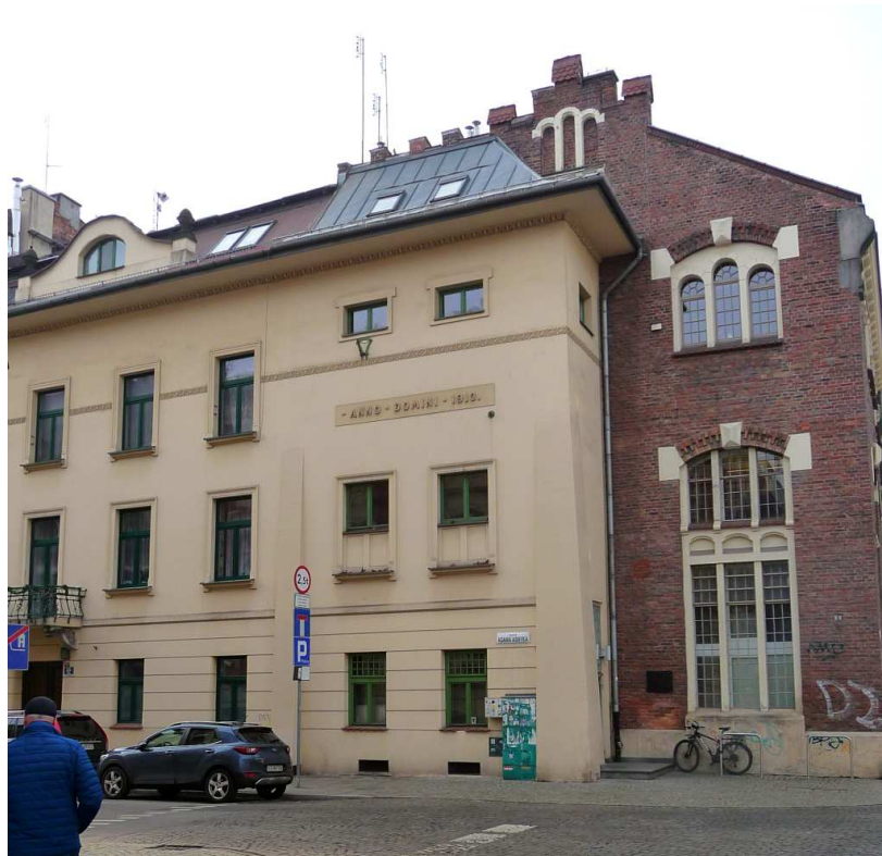
Fot. nr 154. Budynek dawnej podstacji sieci trakcyjnej – widok z od strony ulicy Biskupiej. (21.01.2025)
