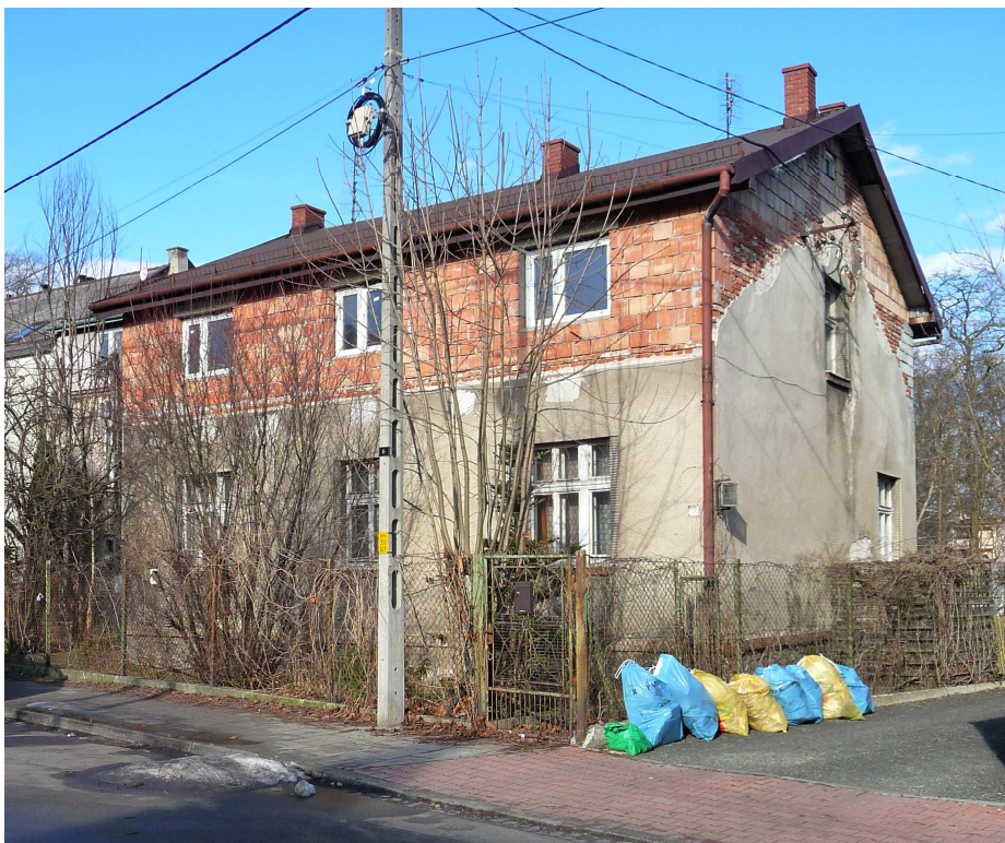
Fot. nr 239. Nadbudowywany dom pod nr 9. (26.01.2025)
