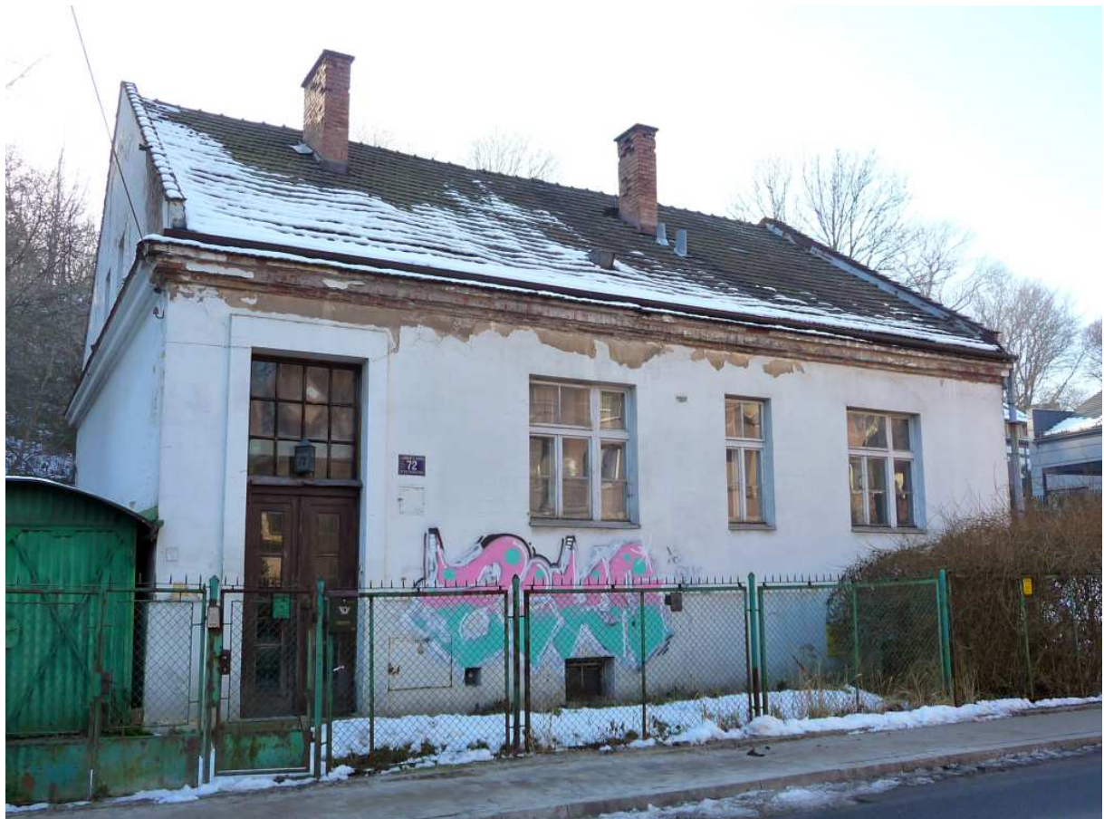
Fot. nr 217. Raczej ostatnie chwile murowanego domu pod nr 72. (19.01.2025)
