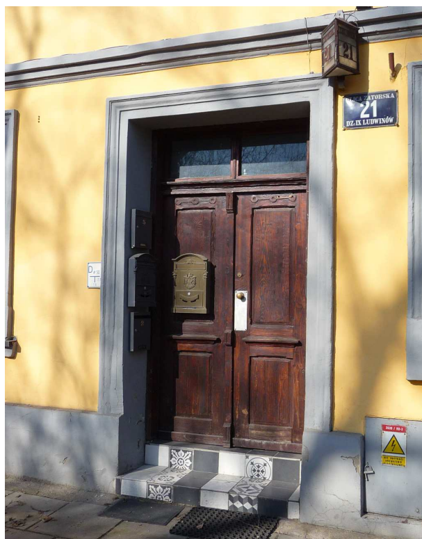
Fot. nr 524. Drzwi domu pod nr 21. (17.02.2025)
