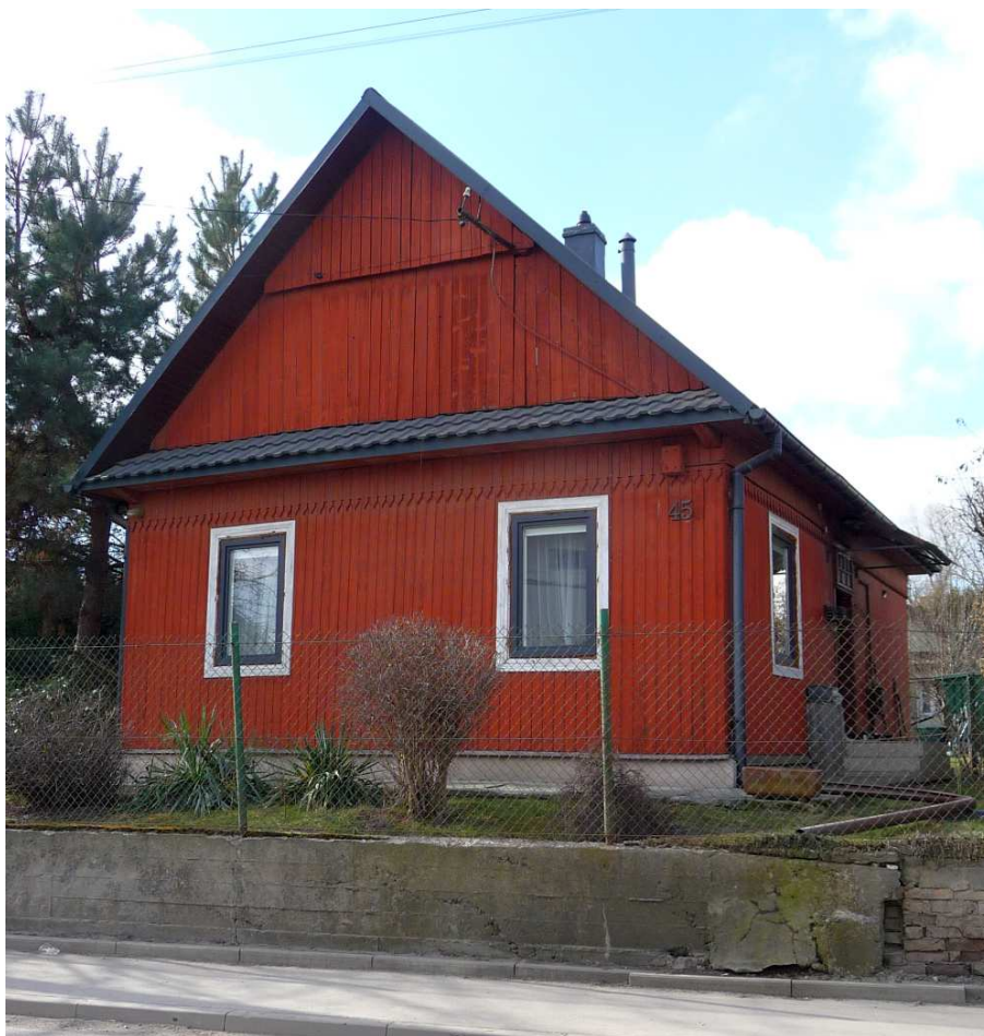
Fot. nr 369. Dom pod nr 45, już z wymienionymi na bezpodziałowe plastiki oknami. (19.02.2025)
