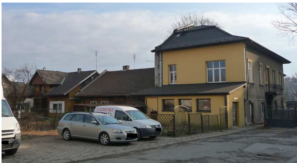
Fot. nr 299 (299-304). Fragmenty dawnej zabudowy ulicy Mogiłskiej pod nr: 71-75. (02.02.2025)
