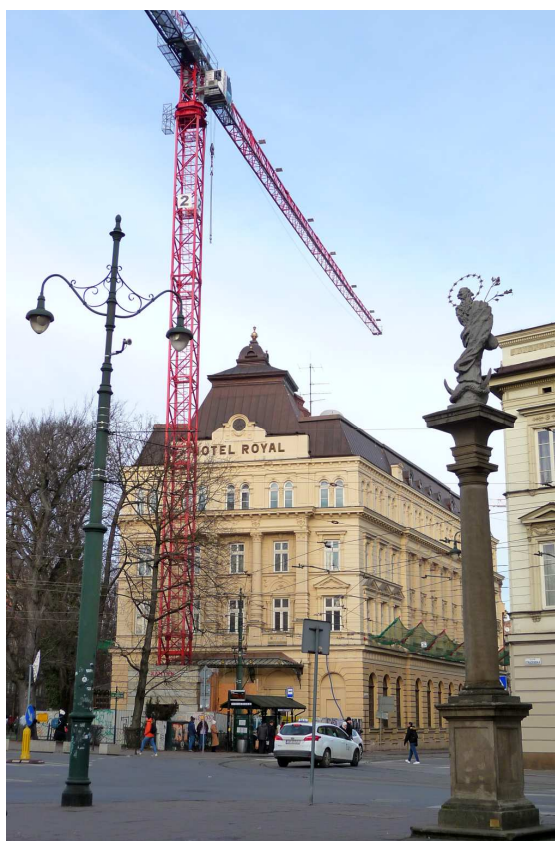
Fot. nr 371. Trwają prace remontowe przy Hotelu Royal. (01.01.2025)
