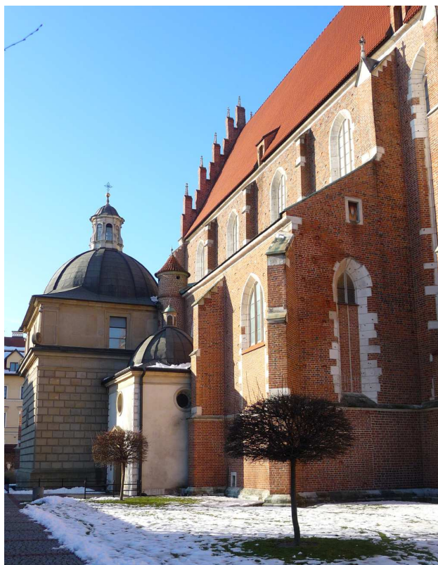
Fot. nr 443. Południowa elewacja. (17.01.2025)
