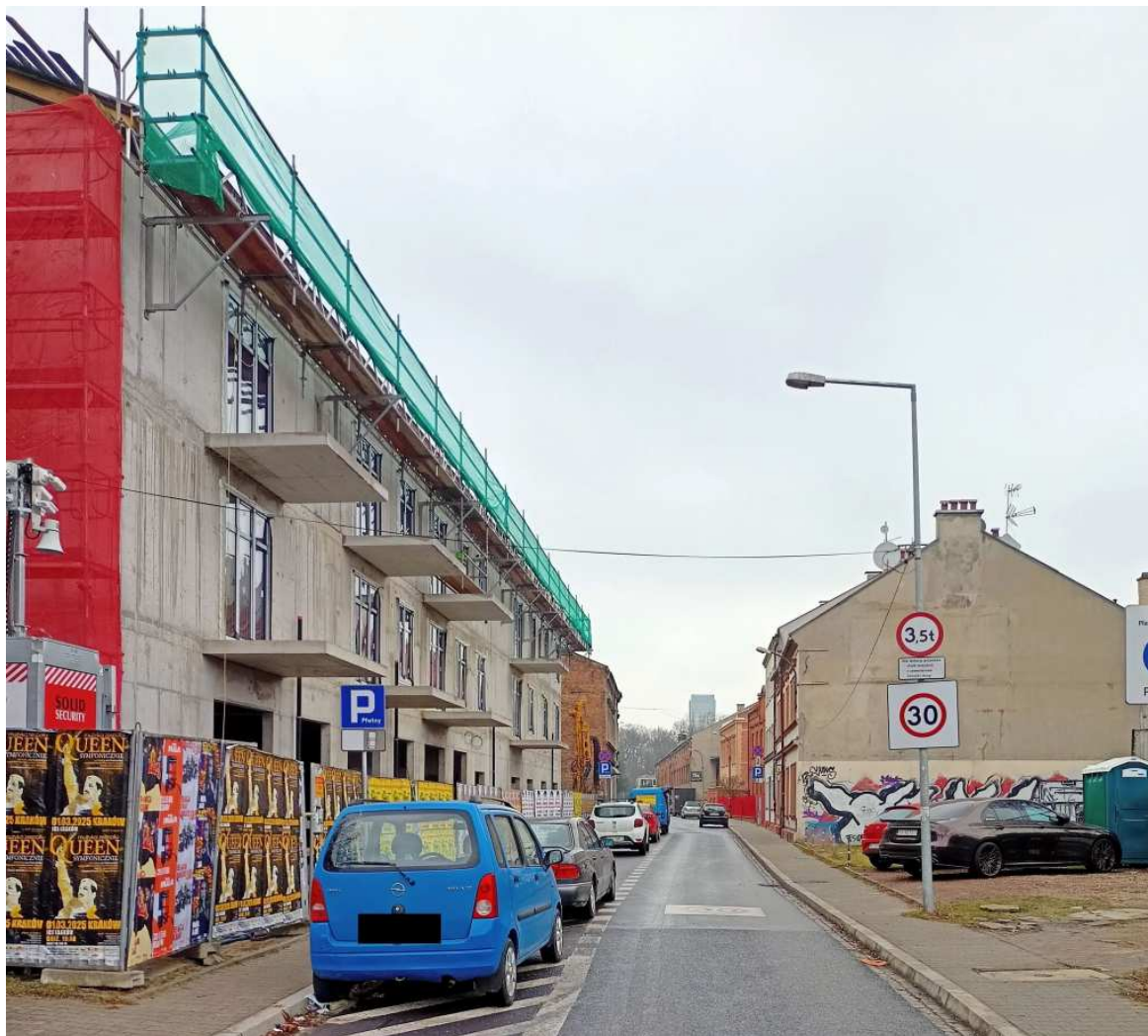
Fot. nr 298. Wzdłuż rozbudowywanej ulicy Żółkiewskiego. (06.02.2025)
