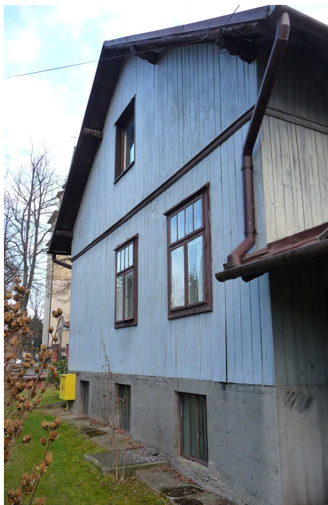
Fot. nr 332. Ściana szczytowa z oryginalnymi oknami. (02.02.2025)
