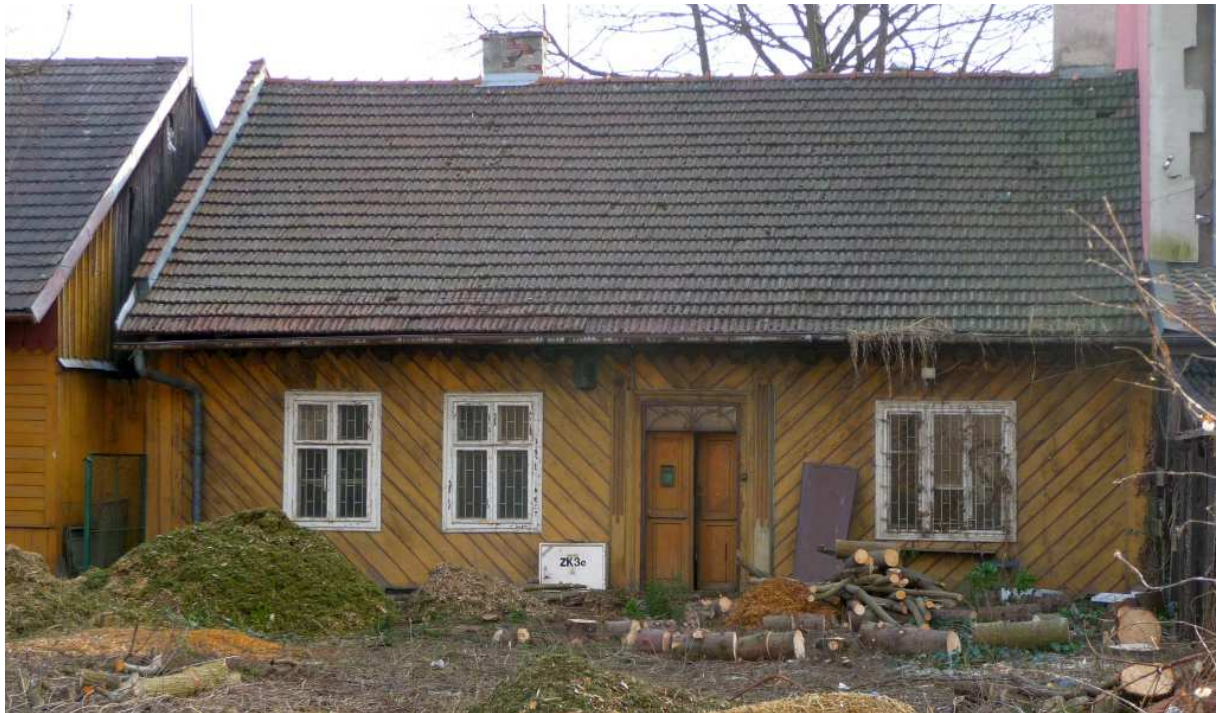
Fot. nr 300 (300-301). Podmiejski mom pod nr 73 i jego detale. (02.02.2025)
