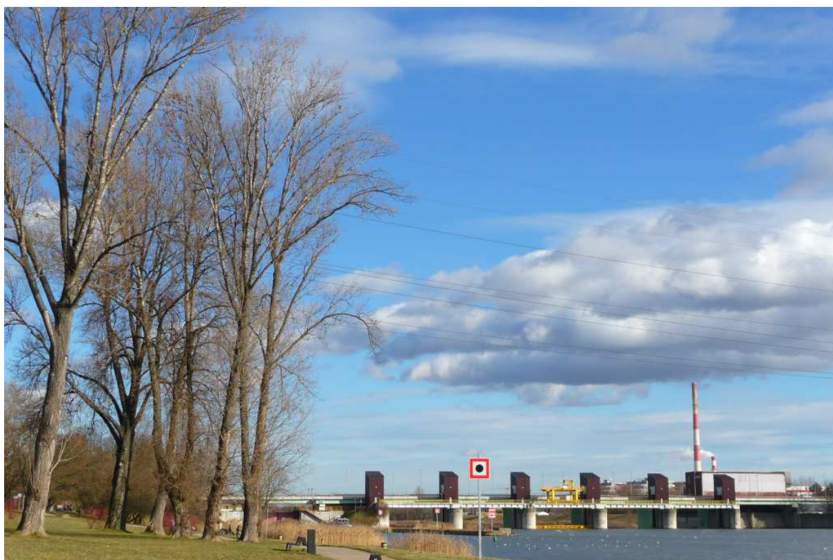
Fot. nr 295. Zapora na Dąbiu. (29.01.2025)
