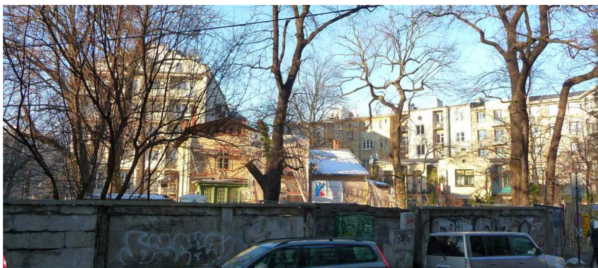
Fot. nr 167 (167-168). Kossakówka na etapie remontu. (18.01.2025)
