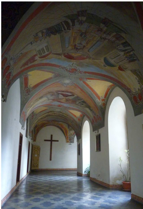
Fot. nr 132. Zachodnie skrzydło. (21.01.2025)
