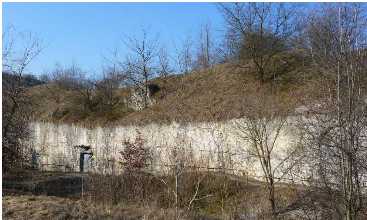
Fot. nr 515. Wejście do schronu po dawnym kamieniołomie. (20.02.2025)
