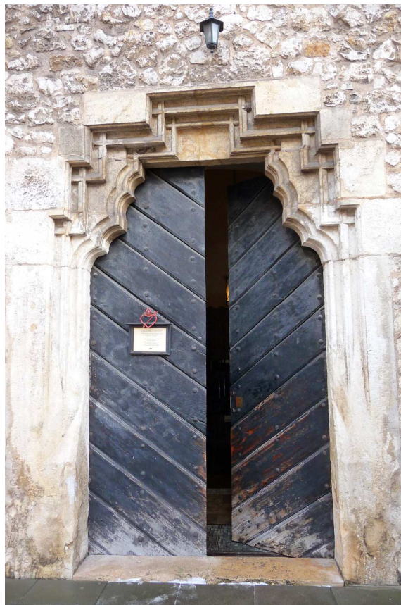
Fot. nr 475 (475-476). Gotycki portal schodkowy przy wejściu do krużganków. (06.01.2025)
