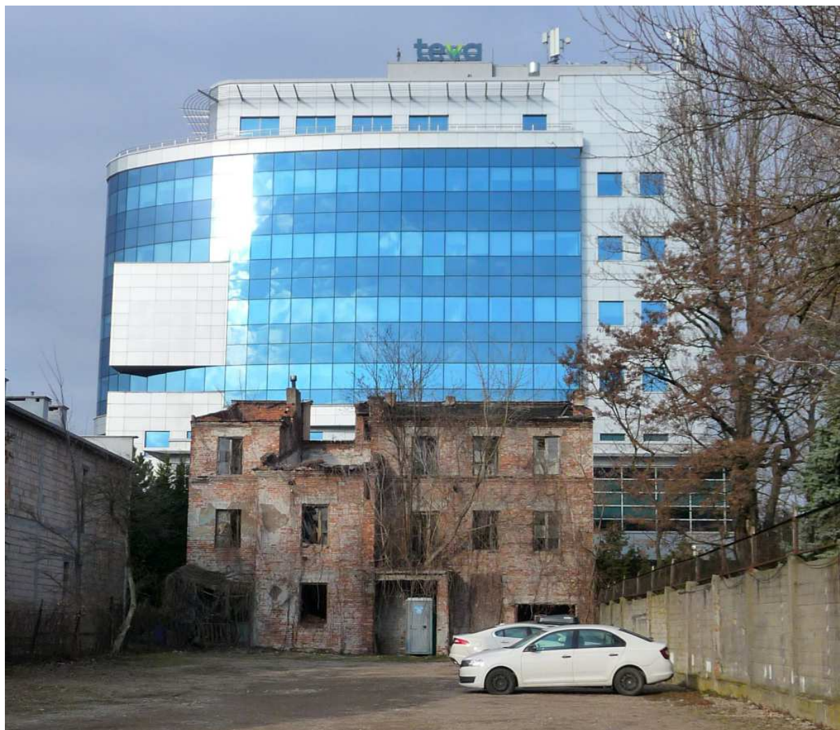
Fot. nr 303. Ruina kamieniczki pod nr 80. (02.02.2025)
