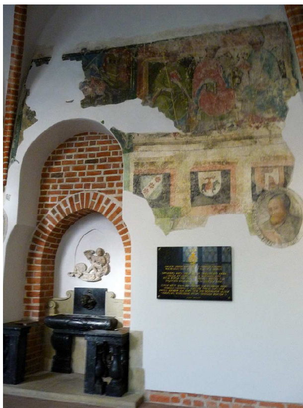
Fot. nr 65. Oryginalne, fragmenty gotyckich fresków i ceglane detale. (01.01.2025)
