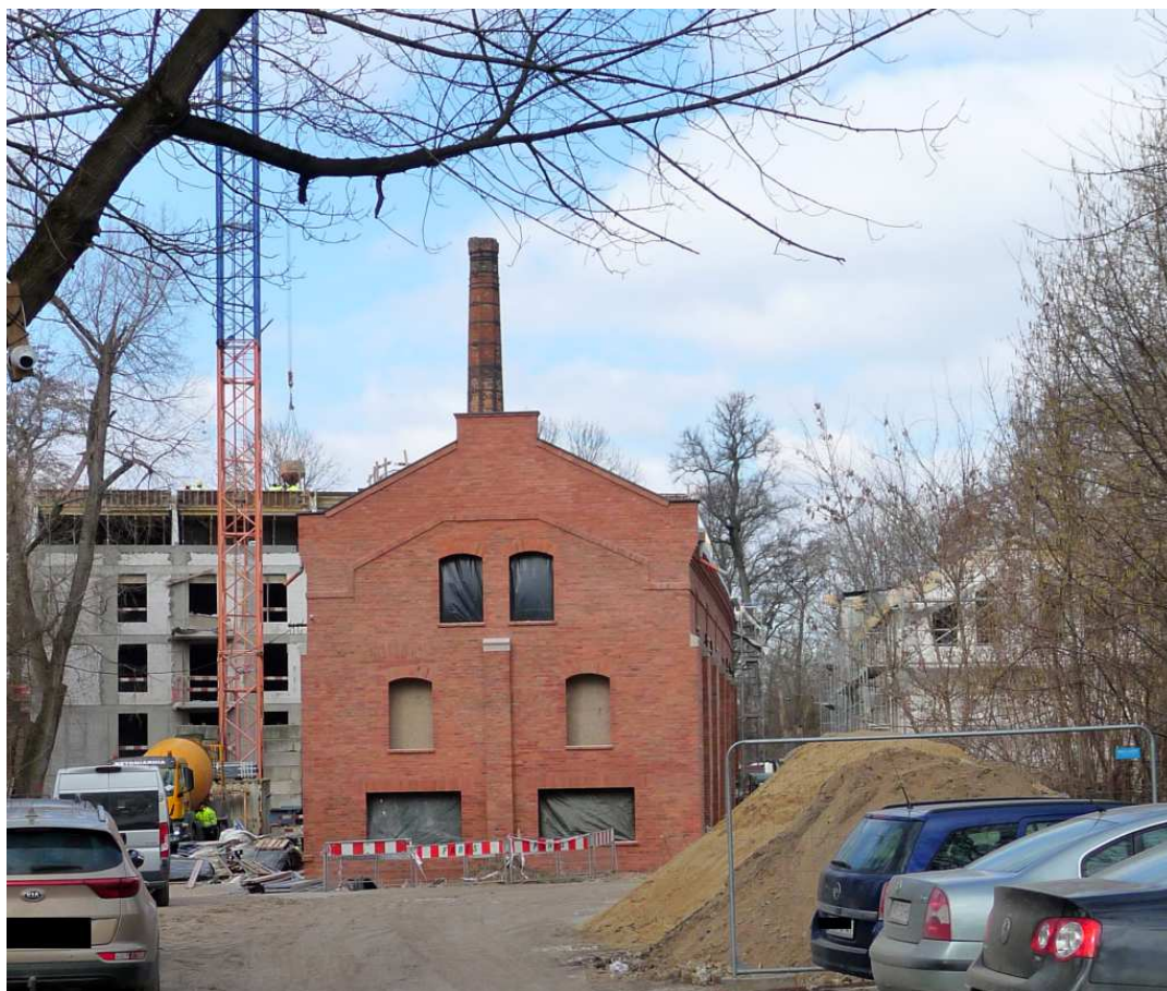
Fot. nr 356. Widok z ulicy Kocmyrzowskiej na posesje pod nr 3. (19.02.2025)
