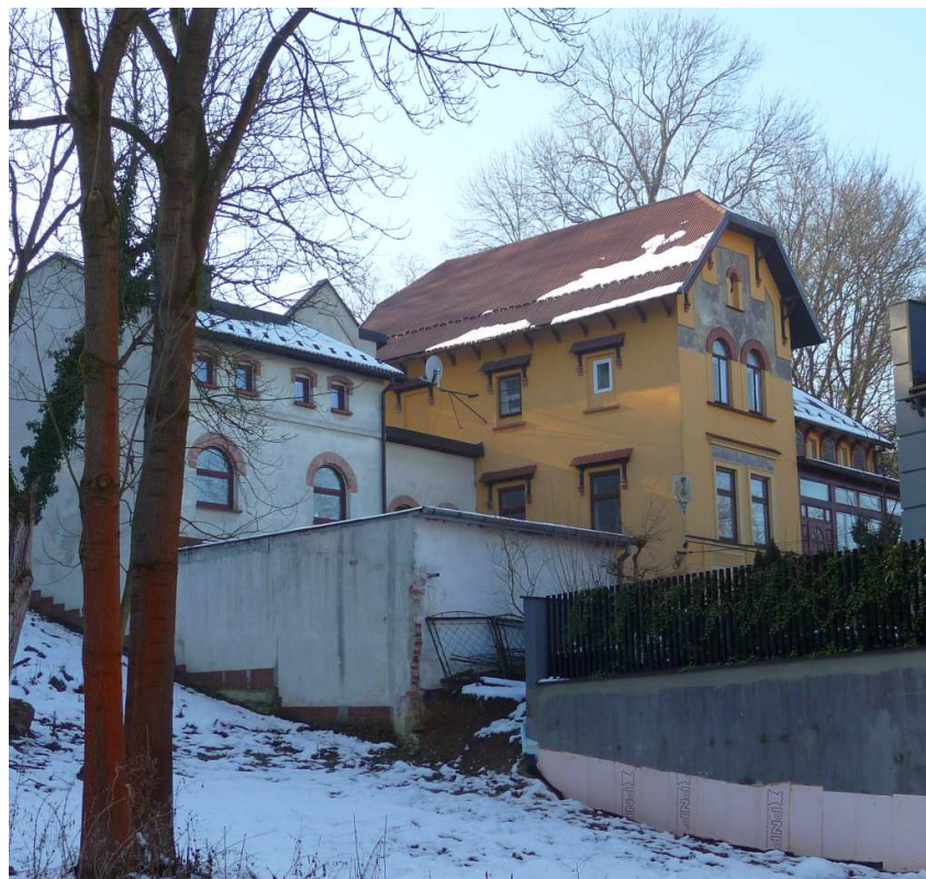
Fot. nr 218 (218-219). Romantyczna willa pod nr 76 i jej detale. (19.01.2025)
