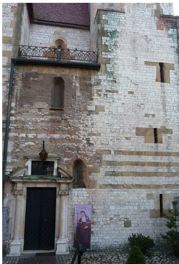
Fot. nr 99. Romańskie detale ściany północnej. (01.01.2025)
