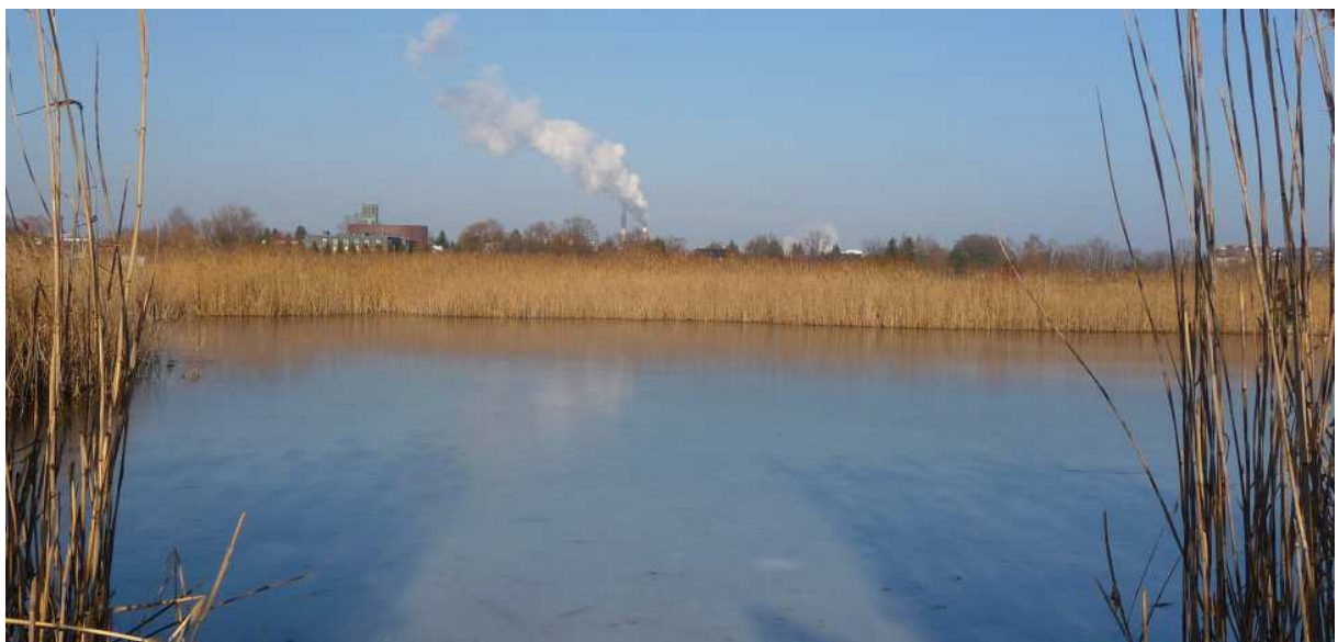
Fot. nr 571 (571-577). Widoki od strony torów kolejowych. Z kominami elektrociepłowni w Łęgu w tle. (10.02.2025)
