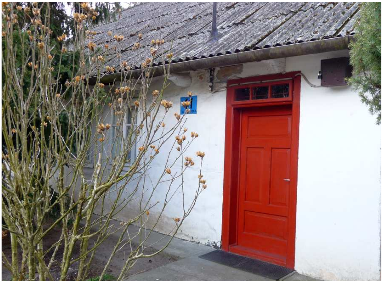
Fot. nr 364 (364-365). Chałupa pod nr 11. Oryginalny fragment fasady. (19.02.2025)
