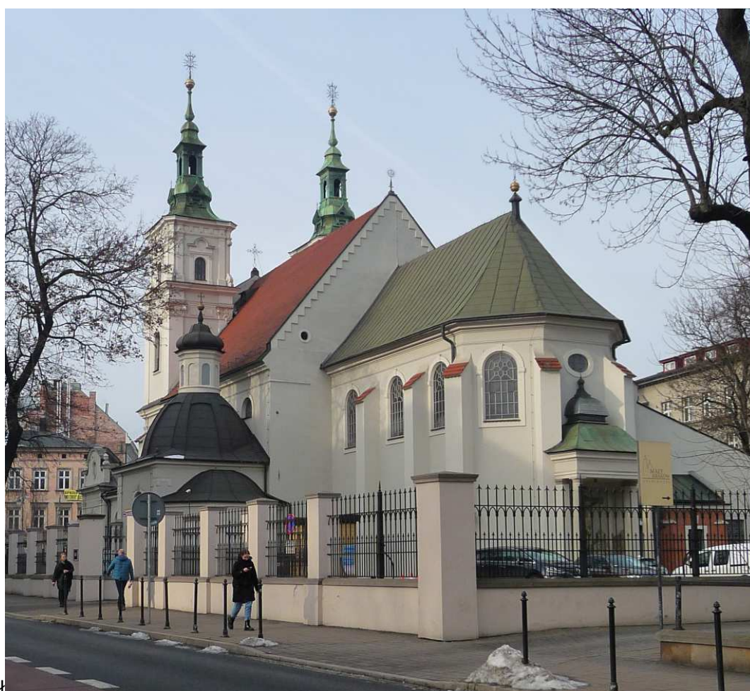
Fot. nr 273. Prezbiterium kościoła – widok z ulicy Kurniki. (21.01.2025)
