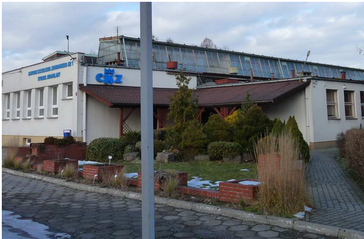
Fot. nr 244. Dawne warsztaty Technikum Energetycznego przy ulicy Wesele 37, gdzie bywałem w roku szkolnym 1968/69.
