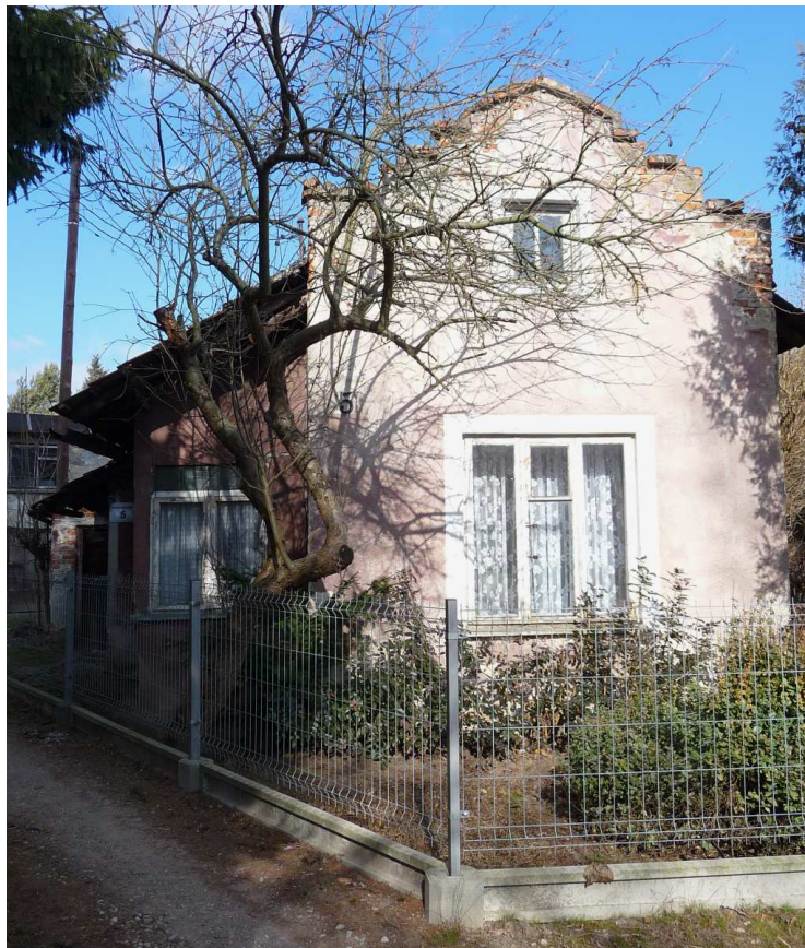
Fot. nr 346. Przedwojenny budynek straży ogniowej z ulicy Kaczeńcowej 5. (19.02.2025)
