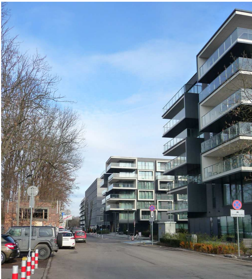
Fot. nr 179. Wjazd na teren dawnego stadionu lekkoatletycznego. (25.01.2025)
