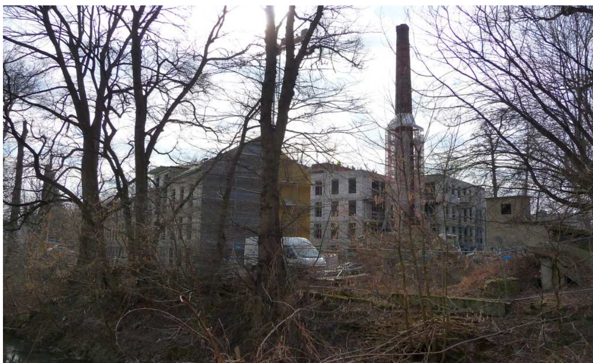
Fot. nr 354 (354-356). Zabudowania dawnego młyna Lelity na etapie przebudowy i rozbudowy na blokowisko Faktoria Młyn. (19.02.2025)
