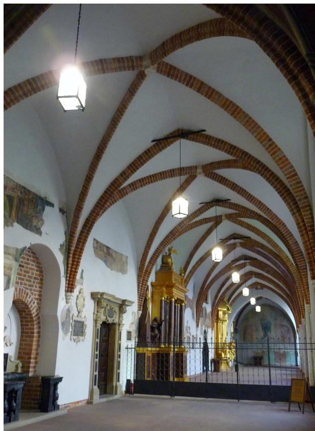
Fot. nr 63. Skrzydło południowe. (01.01.2025)
