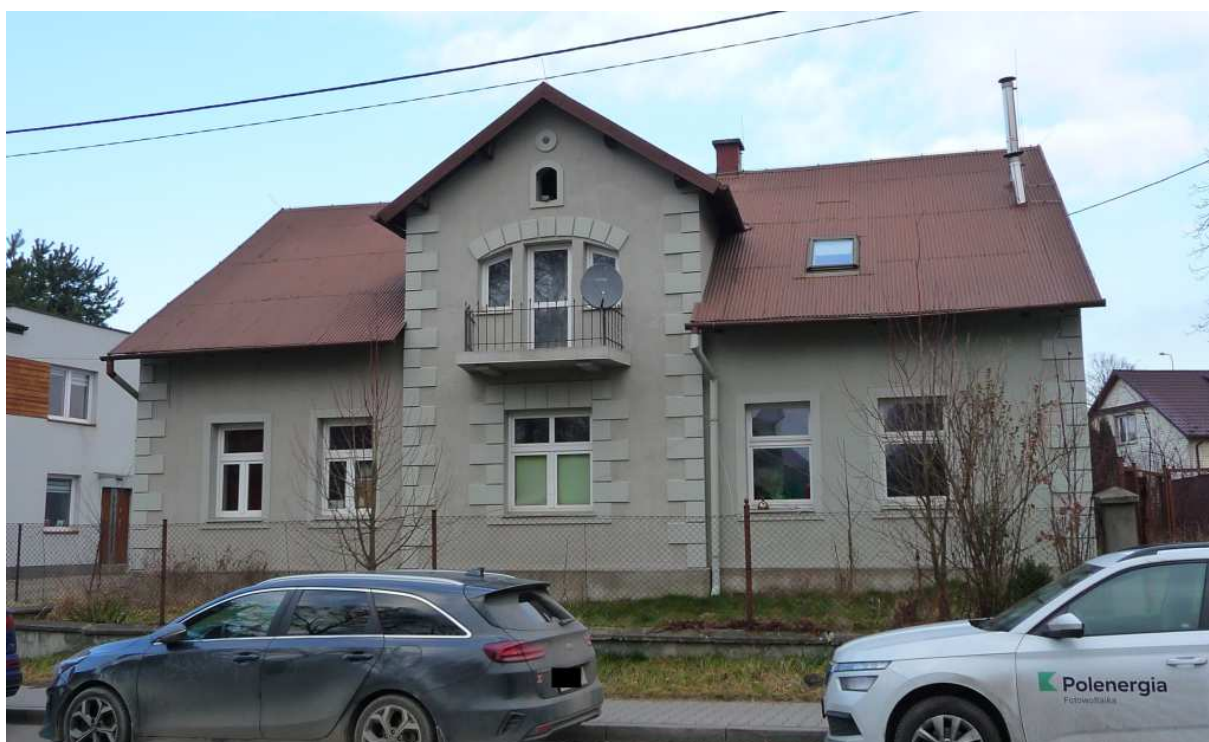
Fot. nr 334. Dom pod nr 9. (02.02.2025)
