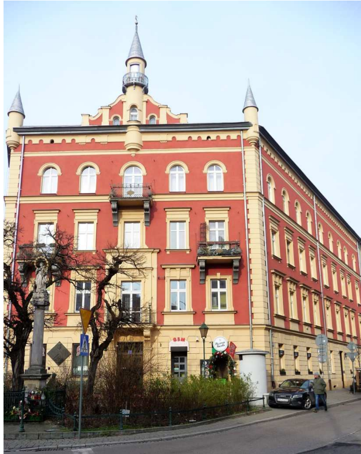
Fot. nr 289. Dom Pod Minaretem na rogu ulic: Długiej 31 i Pędzichów 2. (21.01.2025)
