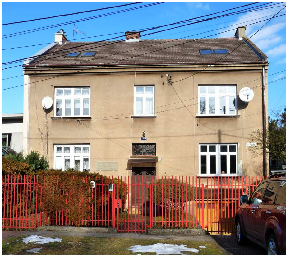
Fot. nr 238 (238-259). Wzdłuż ulicy Zarzecze. Dom pod nr 1. (26.01.2025)
