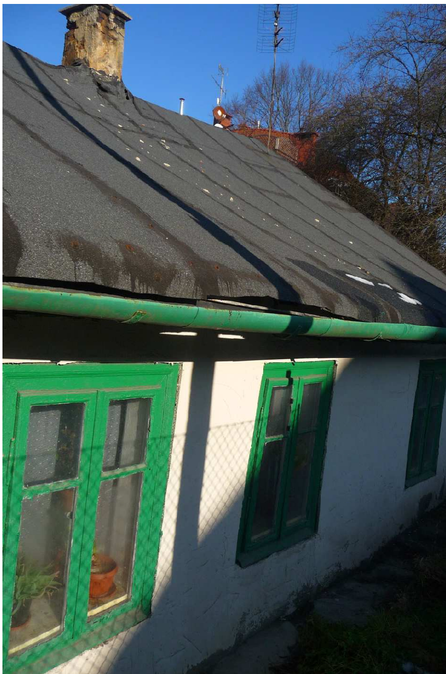
Fot. nr 231. Oryginalne okna w otynkowanej już fasadzie. (19.01.2025)
