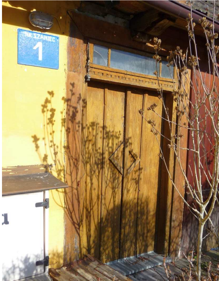
Fot. nr 314. Oryginalne drzwi z oberlichtem. (29.02.2025)
