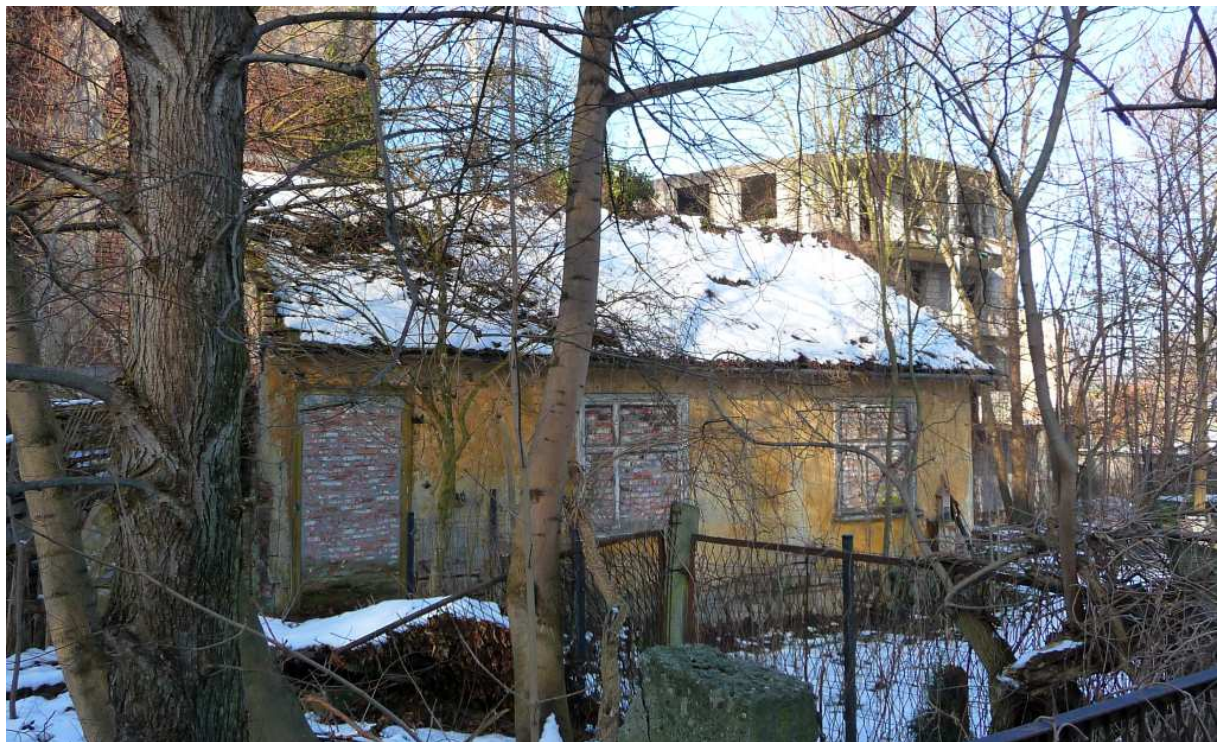
Fot. nr 216. Ruina domu pod nr 63. (19.01.2025)
