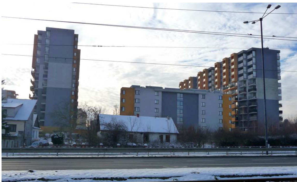
Fot. nr 601. Stare chałupy w zabudowie ulicy Wielickiej o numerach 249 i 251, a w tle nowe blokowisko przy ulicy Polonijnej. (14.01.2025)
