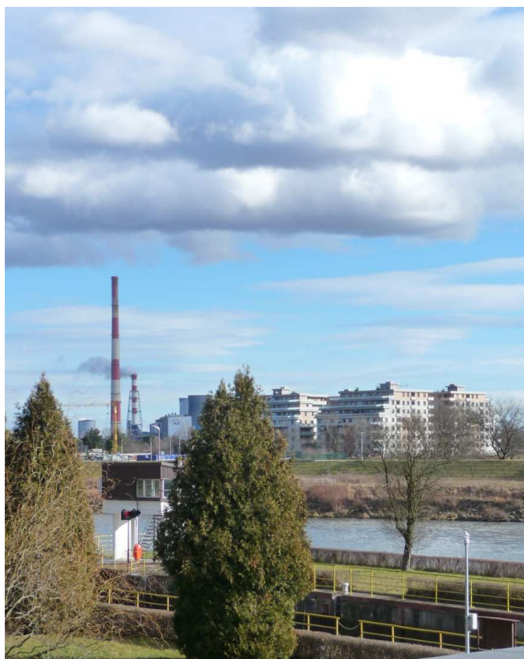
Fot. nr 305. W stronę elektrociepłowni w Łęgu. (29.02.2025)
