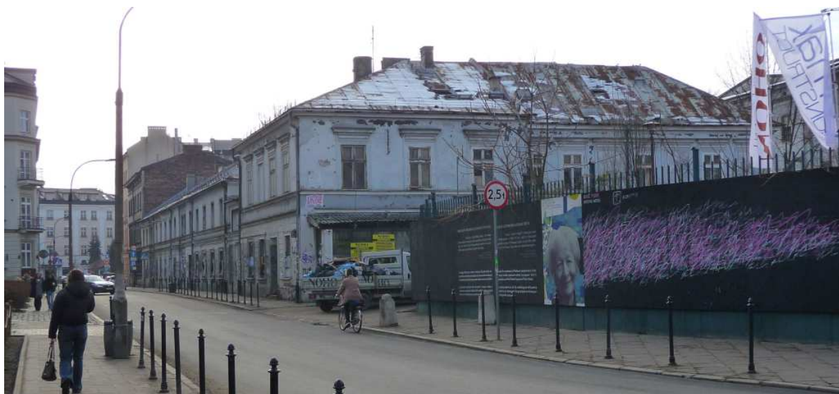
Fot. nr 147 (147-148). Dawna „cygar fabryka” wg stanu przed jej przebudową. (25.01.2025)
