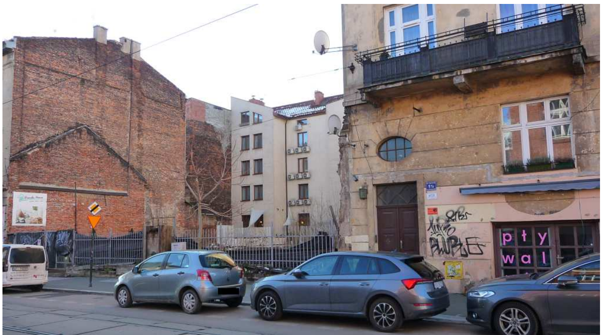
Fot. nr 436 (436-438). Pusta przestrzeń na posesji pod nr 19 i jej tajemnice. (17.01.2025)
