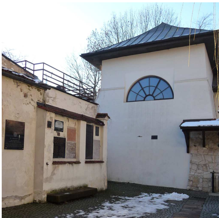
Fot. nr 425 (425-427). Na dziedzińcu wewnętrznym. (17.01.2025)
