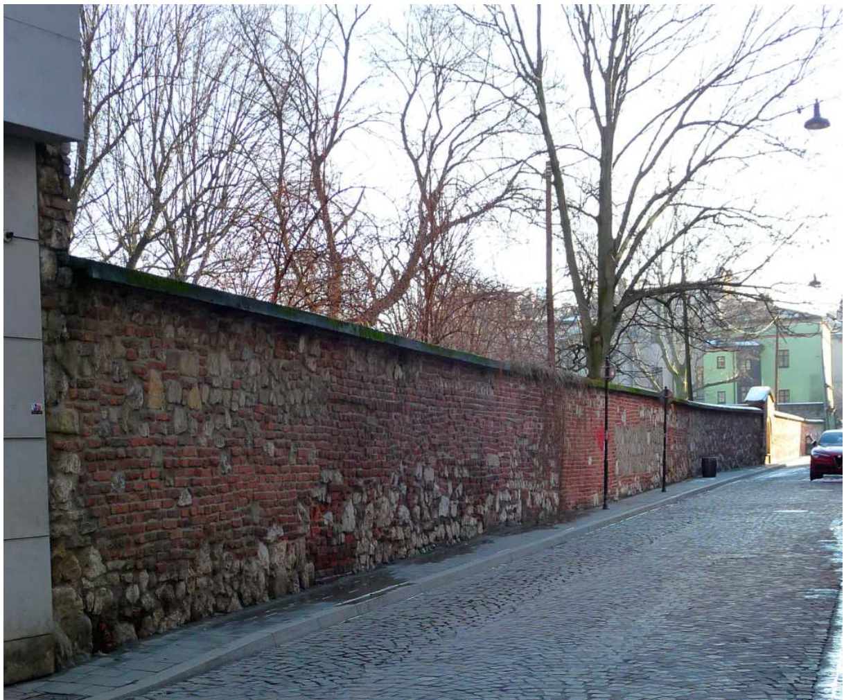
Fot. nr 406 (406-410). Wzdłuż ulicy Jakuba. Mur kirkutu przy bożnicy Remuh. (17.01.2025)
