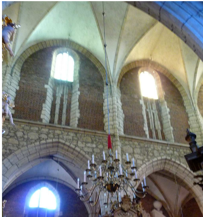
Fot. nr 457. Gotycka faktura ścian i sklepienne krzyżowo-żebrowe. (17.01.2025)
