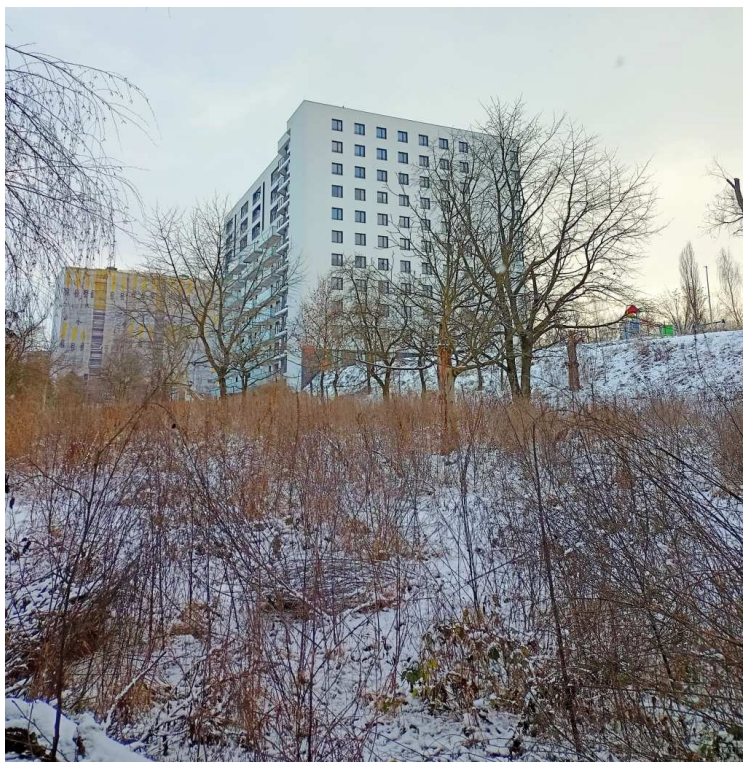
Fot. nr 613 (613-618). Nowe blokowisko powstające przy ul. Podedworze 9. (04.01.2025)
