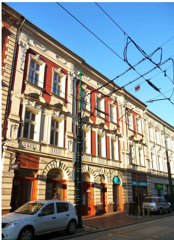
Fot. nr 163. Odnowione kamienice przy ulicy Zwirzyńskiej: 5 i 7. (18.01.2025)
