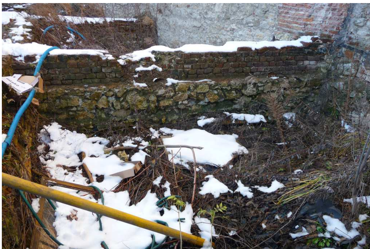
Fot. nr 438. Przyziemie wyburzonego budynku. (17.01.2025)
