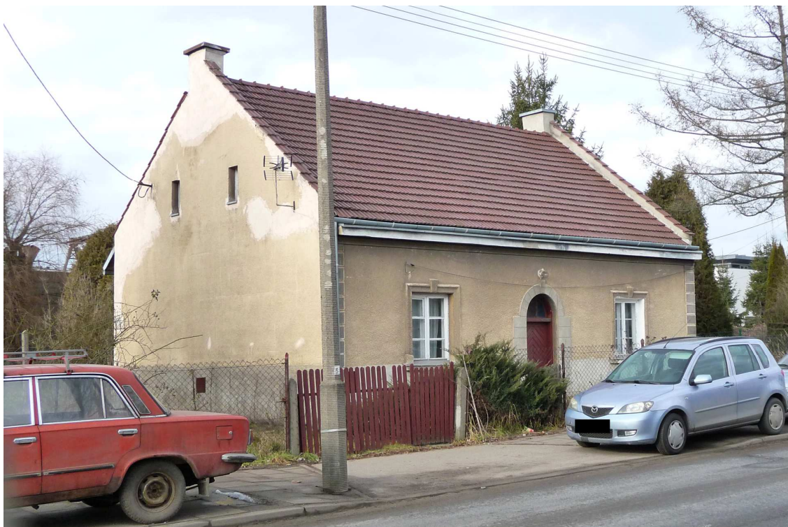
Fot. nr 271. Murowany dom z ulicy Na Błonie 14. (26.01.2025)
