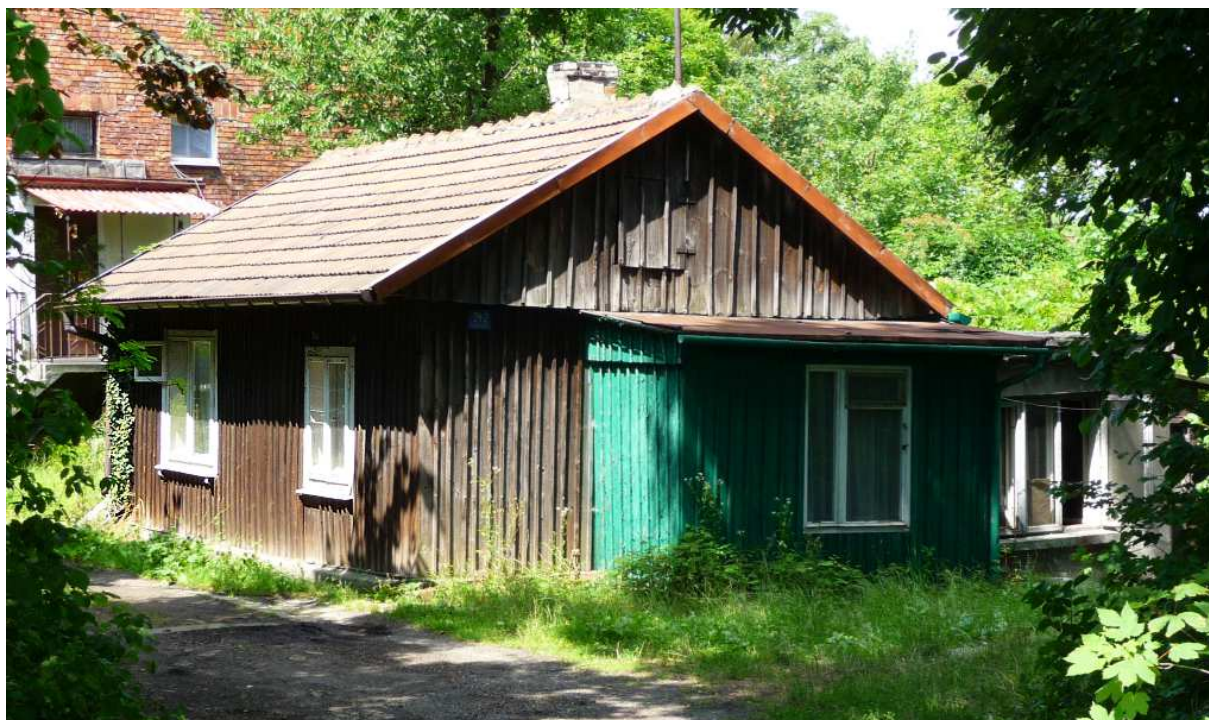
Fot. nr 353. Oszalowana dawna chałupa pod nr 242. (16.07.2025)
