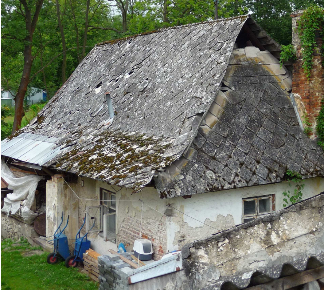
Fot. nr 93. Podwójne pokrycie dachowe dawnej chałupy, to wyższe, ochronne, wykonane z eternitu. (10.07.2025)
