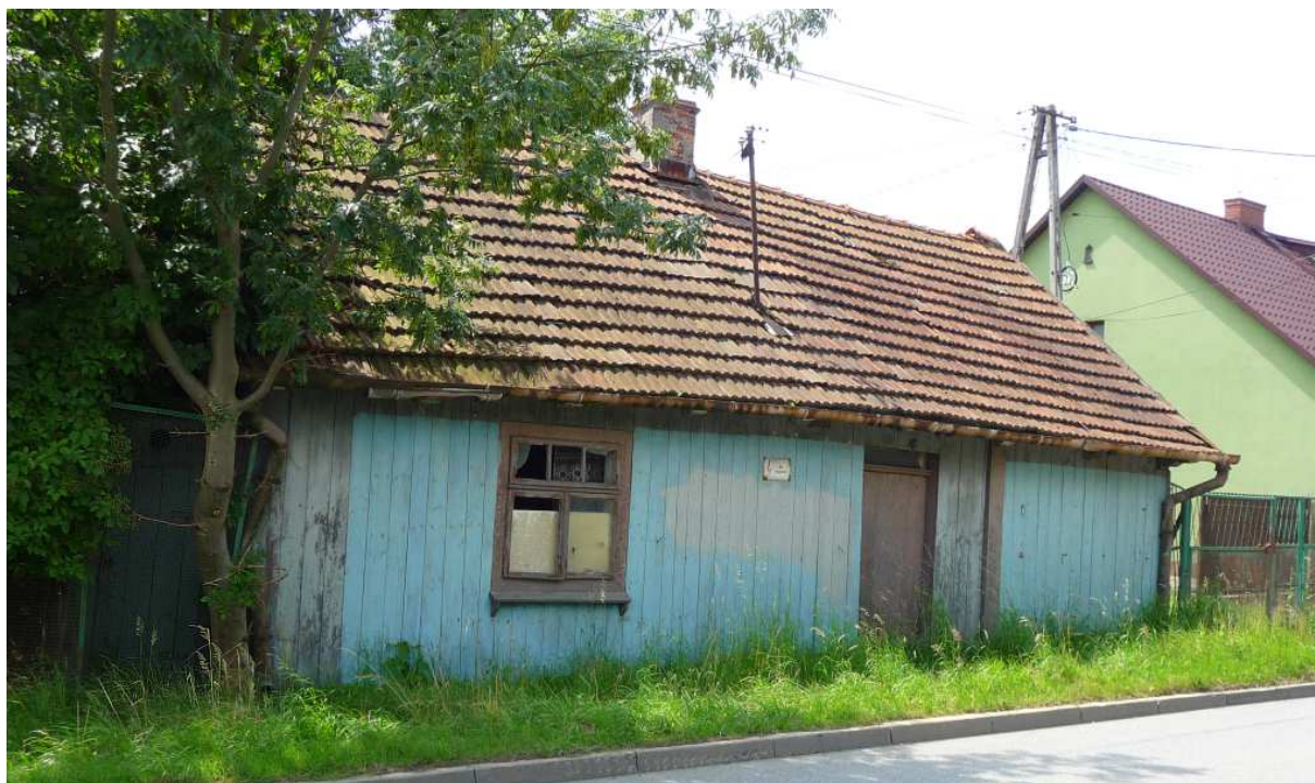
Fot. nr 335 (335-336). Oszalowana chałupa, zapewne z początku XX wieku, pod nr 133. Okno trójskrzydłowe, z górnym, uchylnym fragmentem, podzielonym na trzy kwatery, typowe dla lat 30. XX wieku. (16.07.2025)
