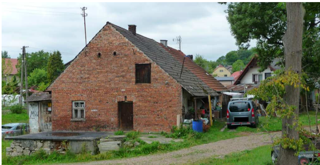
Fot. nr 89 (89-90). Ściana szczytowa i fragment od strony podwórka. (10.07.2025)
