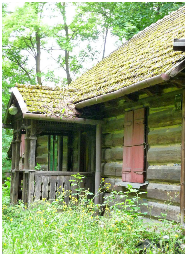
Fot. nr 101. Fasada z odkrytym gankiem. (10.07.2025)
