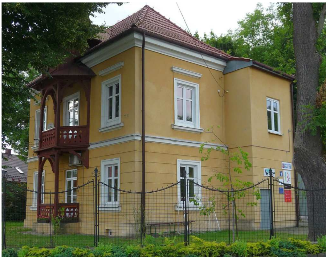
Fot. nr 36. Fasada i prawy bok. (24.06.2025)
