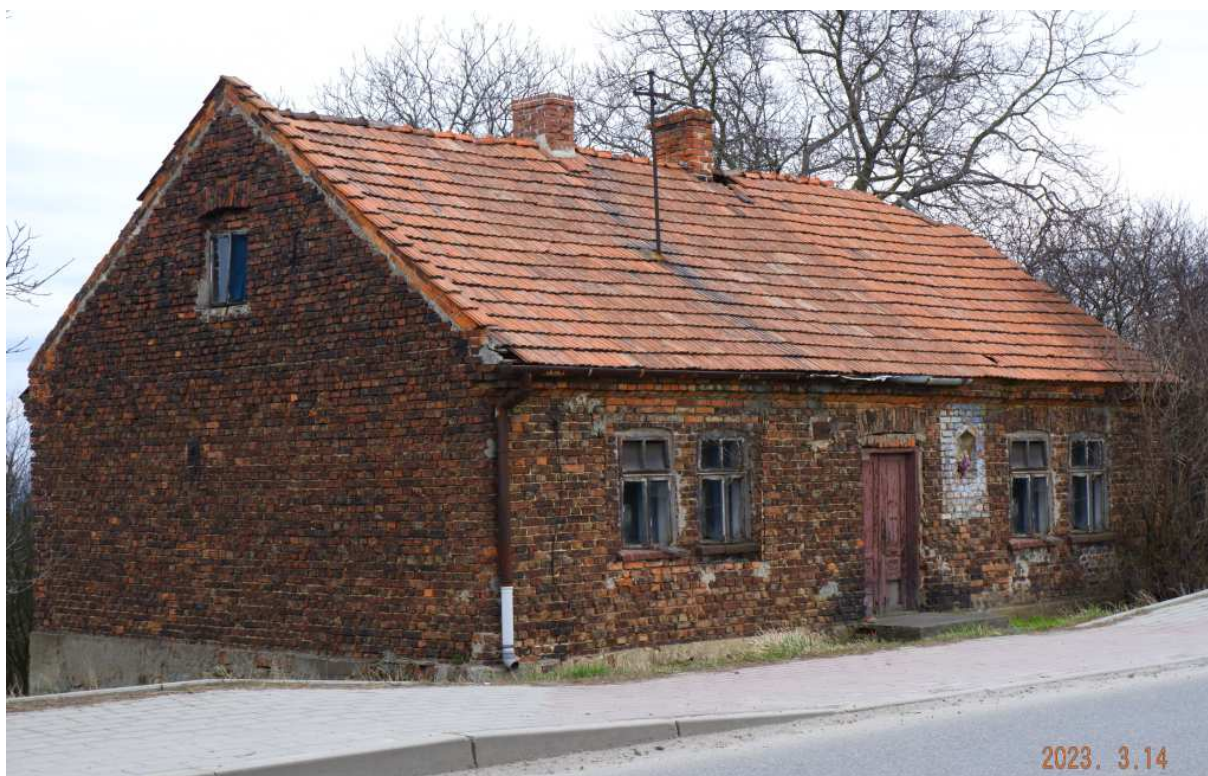
Fot. nr 302. Próba rekonstrukcji fasady.
