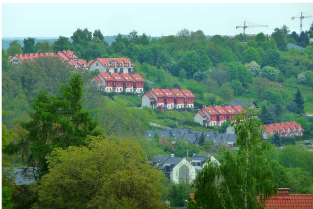
Fot. nr 211 (210-212). Podlegające coraz intensywniejszej zabudowie zbocze wzgórza Kaim, gdzie już miały miejsce się pierwsze osuwiska. (16.05.2023)
