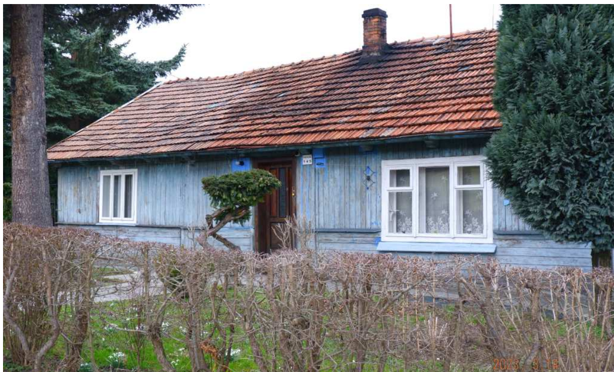
Fot. nr 282 (282-285). Zagroda na skraju kirkutu spod nr 145. Widok na fasadę zapewne około 100-letniego domu.
