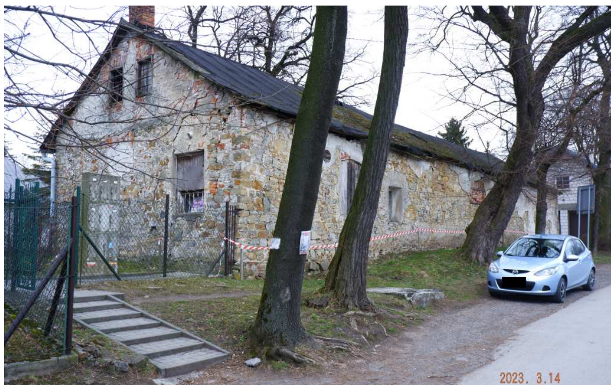
Fot. nr. 291 (291-293). Dawne zabudowania dworskie. Fot. nr 291-292. Budynek pośrodku dziedzińca. Tu widok z ulicy.
