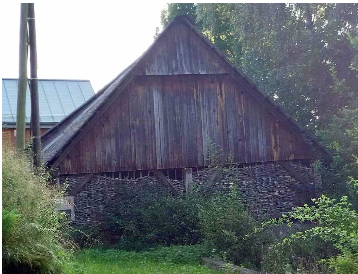
Fot. nr 372. Stodoła a archaiczną ścianą wyplataną z wikliny.
