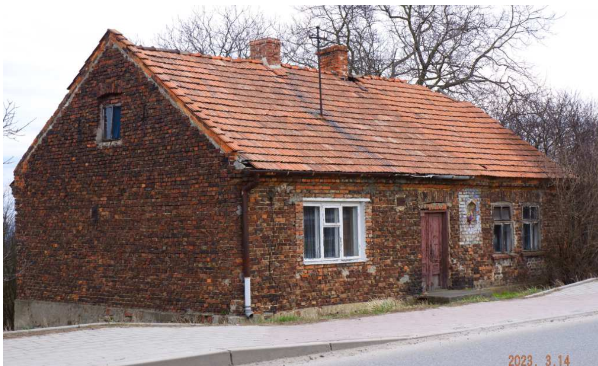
Fot. nr 310 (301-303). Murowany, zapewne międzywojenny dom spod nr 144. Stan obecny.
