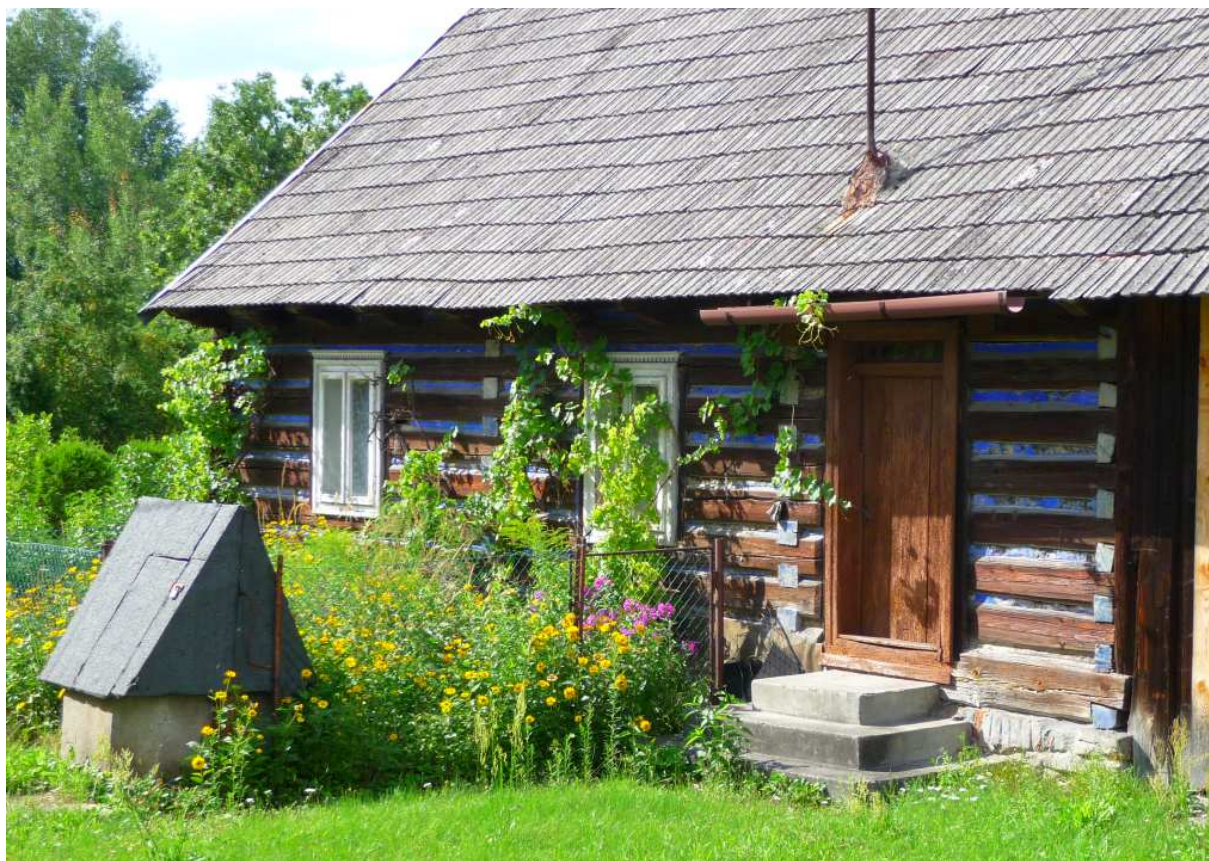
Fot. nr 150. Część mieszkalna. (29.07.2025)
