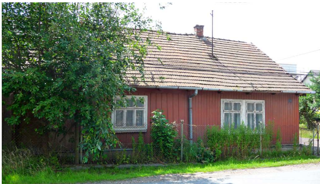
Fot. nr 334. Zapewne około 100-letni dom pod nr 120. Prawy, oszalowany fragment z oknami typu skrzynkowego. (16.07.2025)
