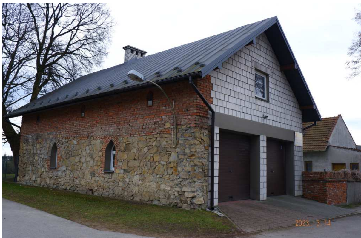
Fot. nr 293. Budynek gospodarczy po prawej stronie dziedzińca, przerobiony na garaż.
