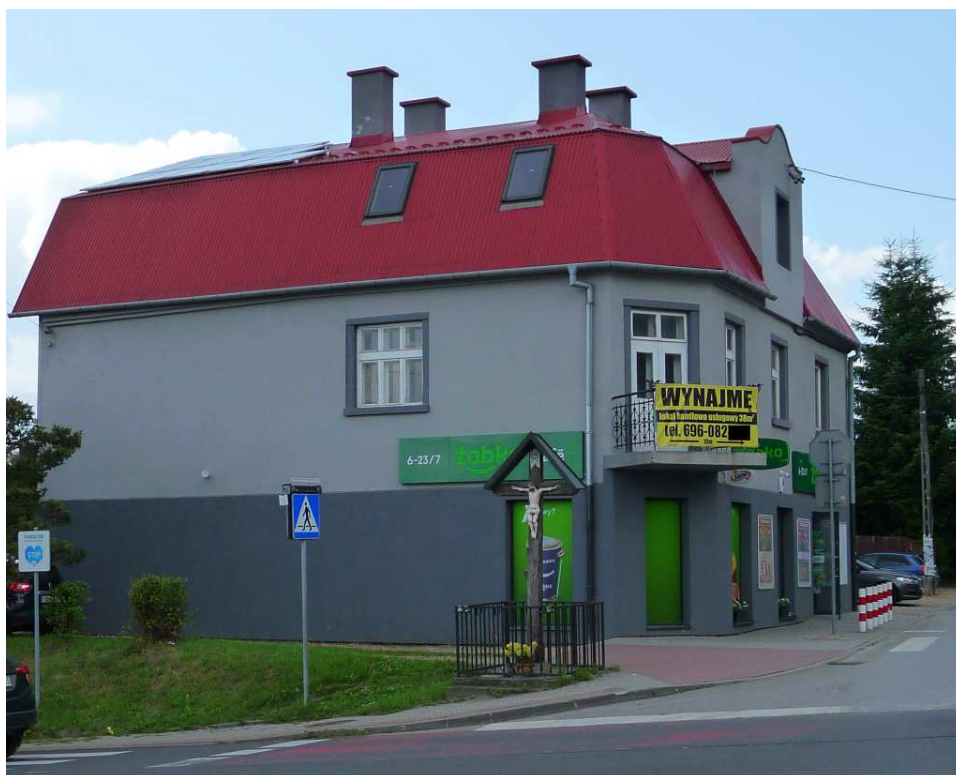
Fot. nr 342 (342-343). Narożny, zapewne przedwojenny dom pod nr 170, usytuowany przy drodze wiodącej do Sygnejczowa. (16.07.2025)
