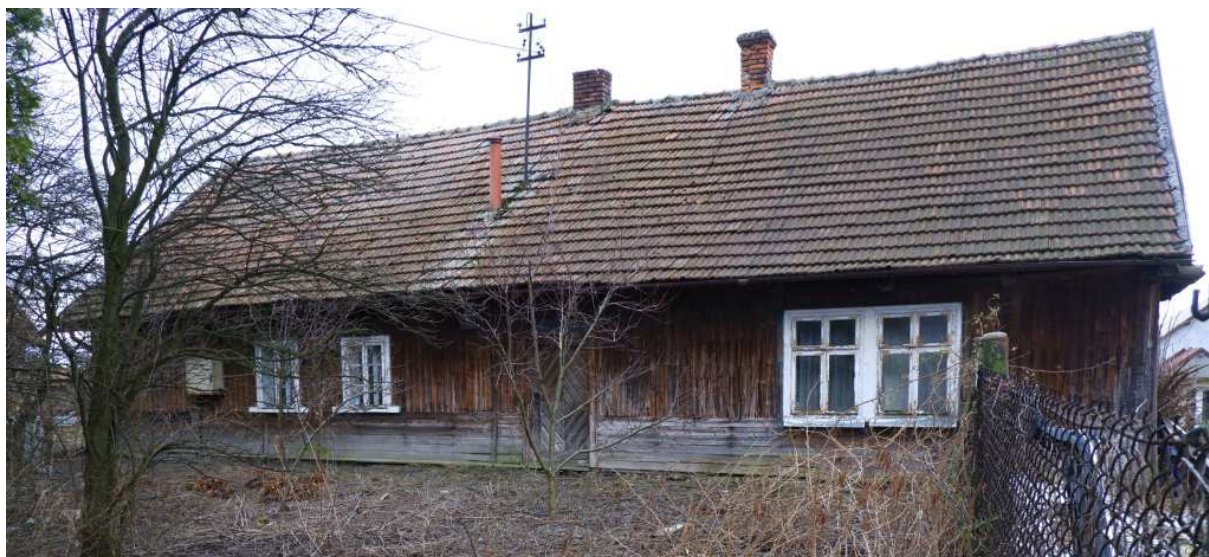
Fot. nr 313. Spojrzenie na fasadę. (14.03.2023)
