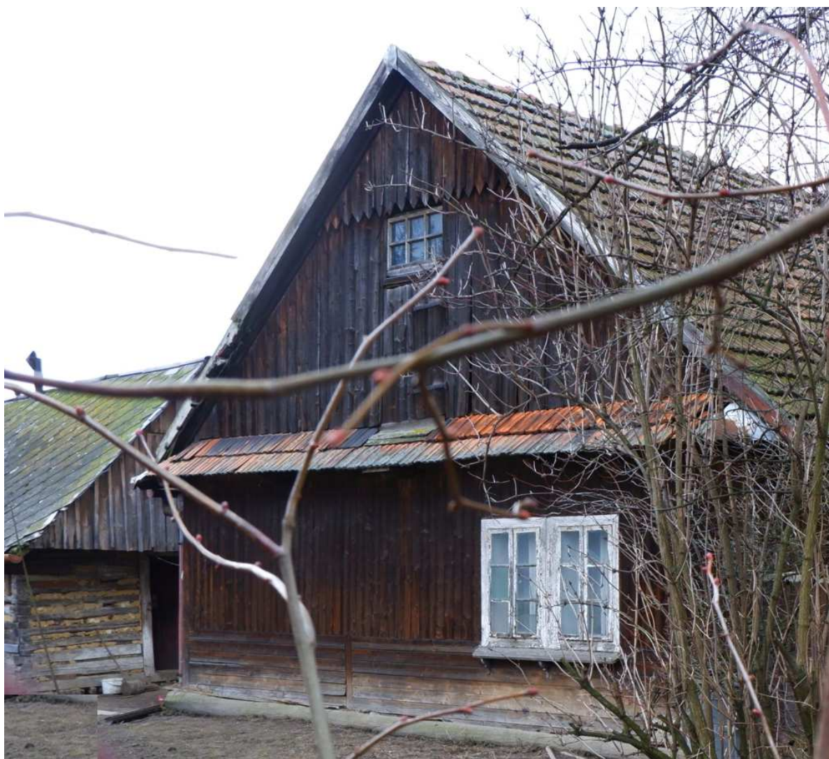
Fot. nr 314. Ściana szczytowa i oryginalne okna typu ościeżnicowego. (14.03.2023)
