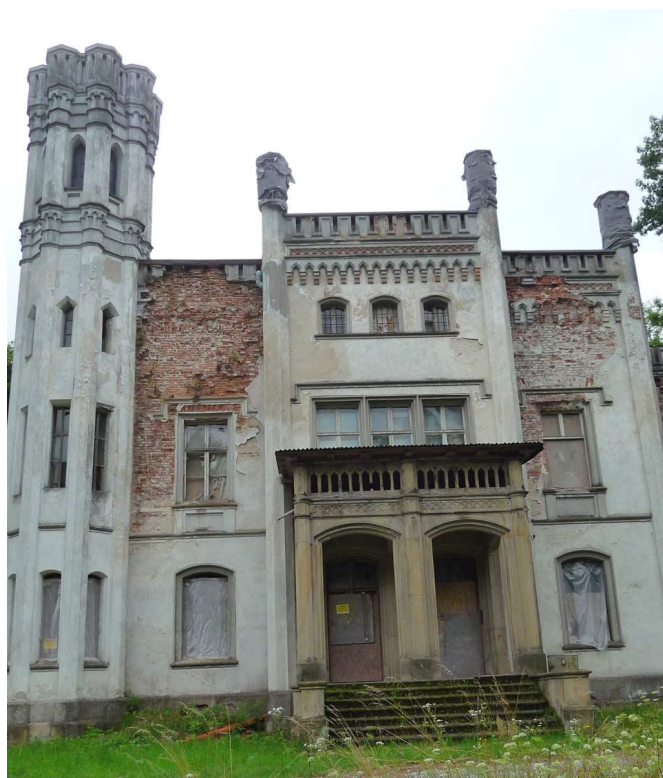
Fot. nr 123. Fasada. (27.07.2025)
