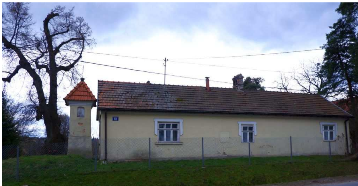
Fot. nr 319. Próba rekonstrukcji fasady przez dodanie oryginalnych okien w środkowym i prawym fragmencie. (14.03.2023)
