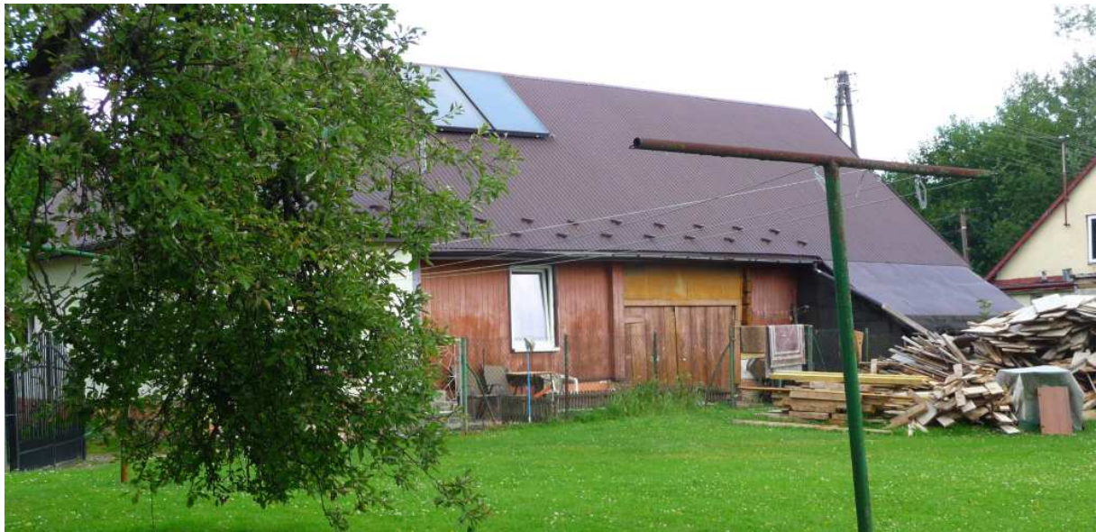
Fot. nr 27 (27-29). Nieco już zniekształcona dawna chałupa z ulicy Szkolnej 26. Fasada od strony podwórka. (24.06.2025)
