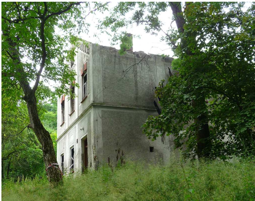
Fot. nr 116 (115-119). Oficyna i znajdujące się na jej zapleczu zabudowania gospodarcze, usytuowane na przedpolu pałacu. Budynek mieszkalny. (27.07.2025)
