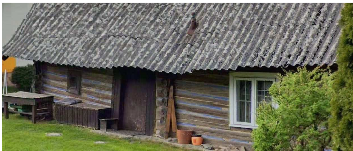
Fot. nr 55. Próba uchwycenia fasady chałupy pod nr 192, której dach został ukryty pod eternitem. (10.07.2025)
