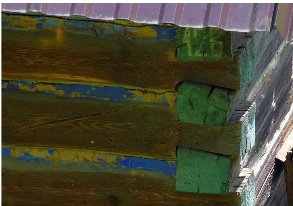
Fot. nr 11. Detale ściany. Belki i uszczelnienie między nimi, tu glina, były malowane w innych kolorach. (24.06.2025)
