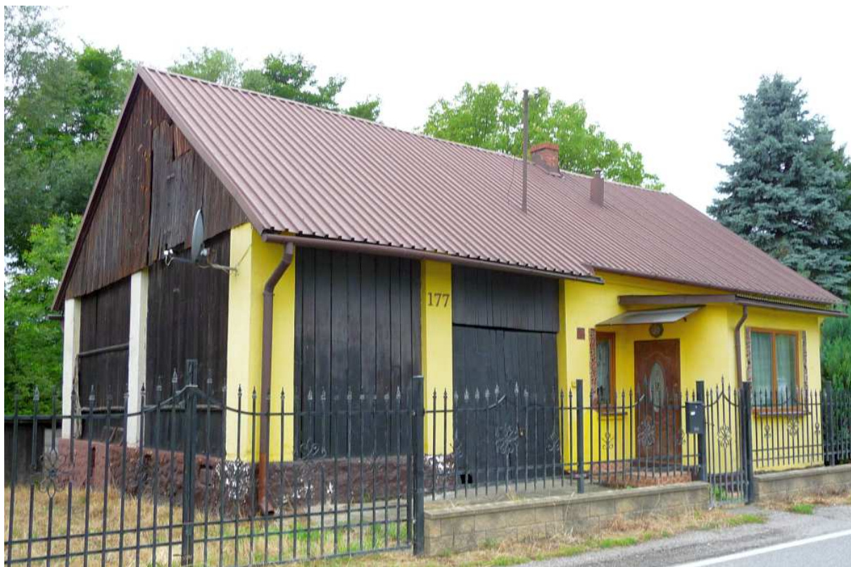
Fot. nr 99. Próba rewitalizacji starej chałupy pod nr 177. (10.07.2025)
