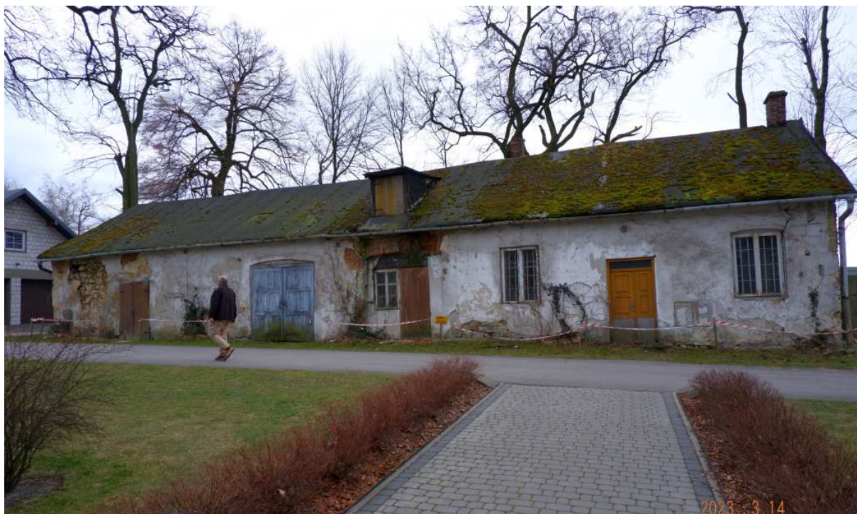
Fot. nr 292. Widok od strony dworu.
