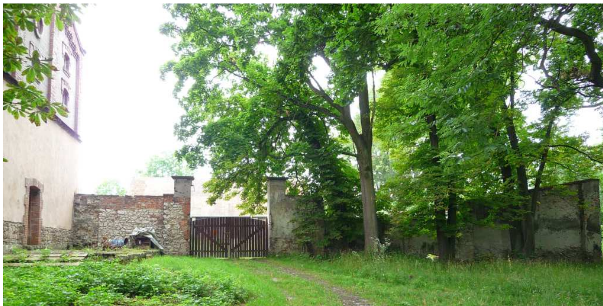
Fot. nr 130. Wjazd na teren przylegającego do parku folwarku. (27.07.2025)
