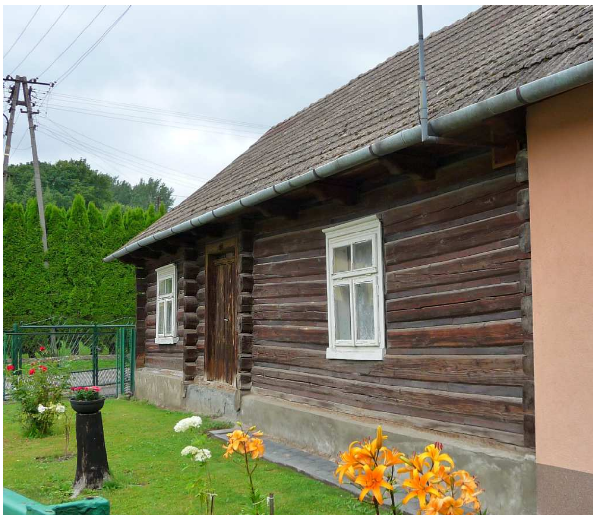
Fot. nr 51. Oryginalny fragment fasady o konstrukcji zrębowej. Okna późniejsze, zapewne z lat 30. XX wieku. (10.07.2025)
