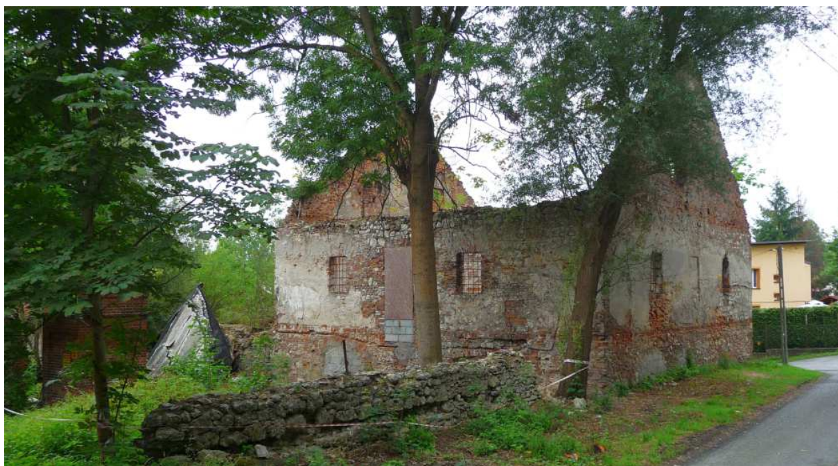
Fot. nr 135 (135-140). Szeroko rozbudowana ruina dworskiego browaru z I. połowy XIX wieku pod nr 3. Od sąsiada usłyszałem, że jest rozważana jego rekonstrukcja. (27.07.2025)
