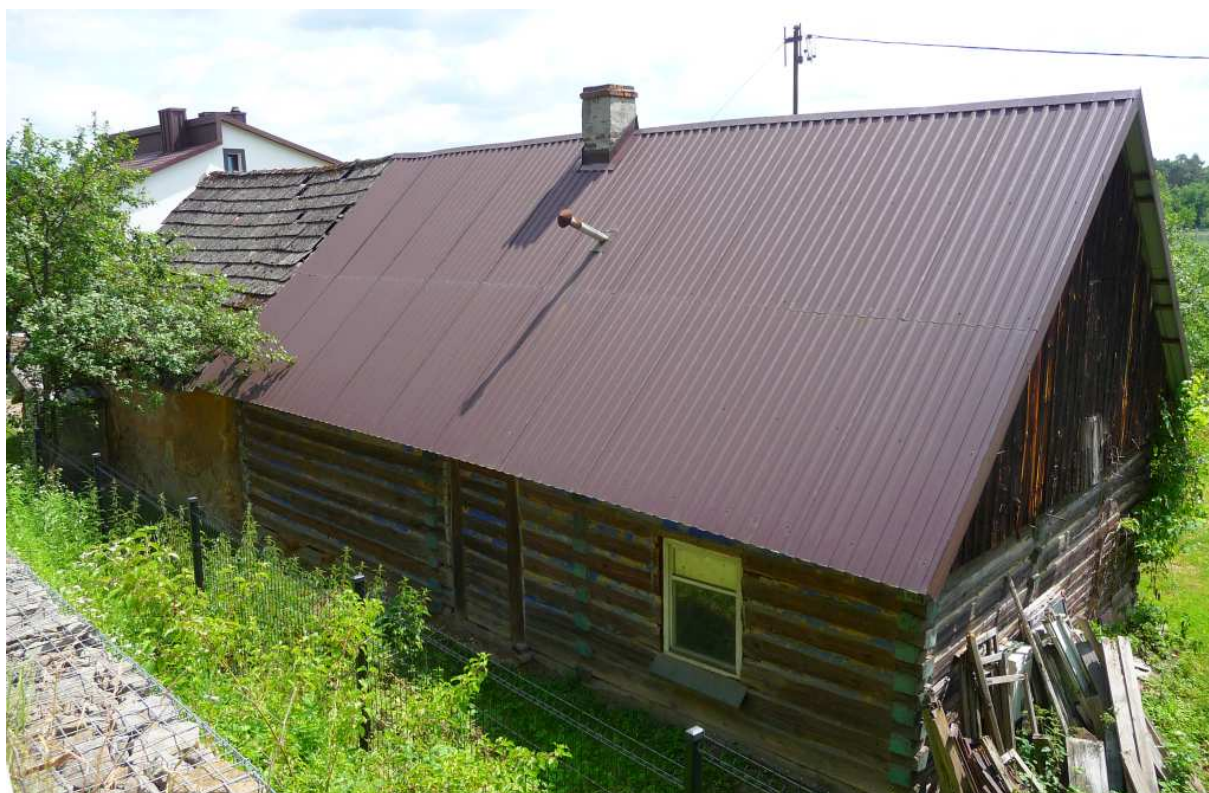
Fot. nr 9 (9-11). Tylne część dawnej chałupy pod dawnym numerem: Szczyglice 126, dziś obok posesji przy ulicy Krakowskiej 172. Niestety jej fasady nie da się uchwycić z ulicy. (24.06.2025)
