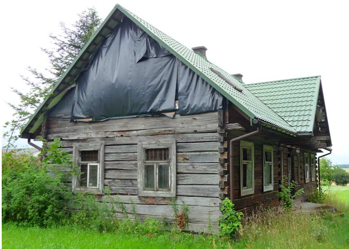
Fot. nr 77. Fasada. Nowy dach dobrze mu wróży. (10.07.2025)
