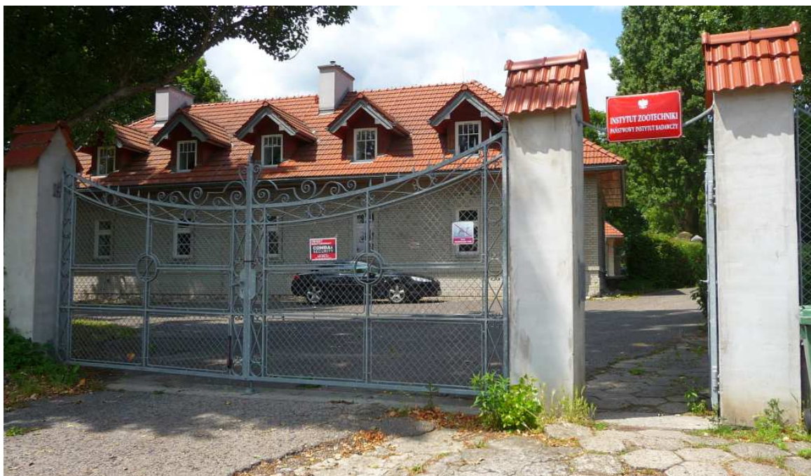
Fot. nr 25. Wejście zespołu pałacowego z ulicy Szkolnej pod nr 3. (24.06.2025)
