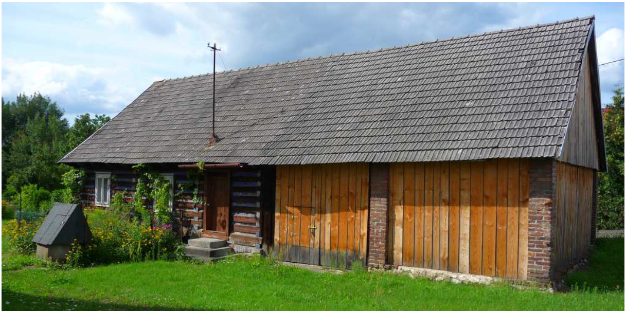
Fot. nr 149 (149-151). Zapewne ponad stuletnia chałupa spod nr 25, do której we wspólnym korpusie przylega stodoła. Obiekt przykładnie zadbane. (29.07.2025)
