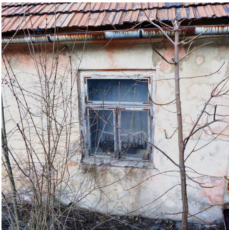
Fot. nr 307. Oryginalne okno trójskrzydłowe w prawym budynku. (14.03.2023)
