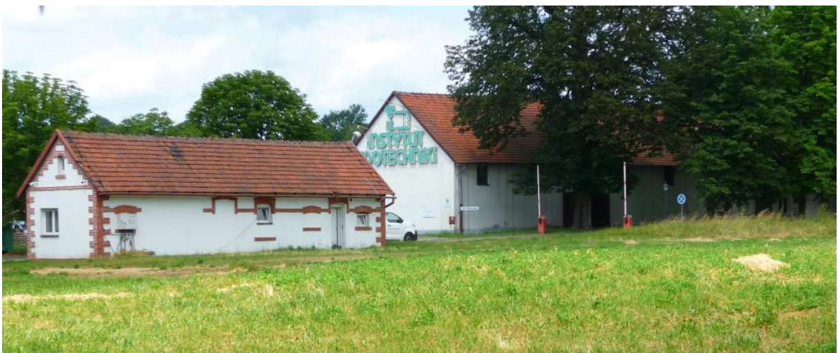
Fot. nr 22. Widok z ulicy Szkolnej na budynki gospodarcze. (24.06.2025)
