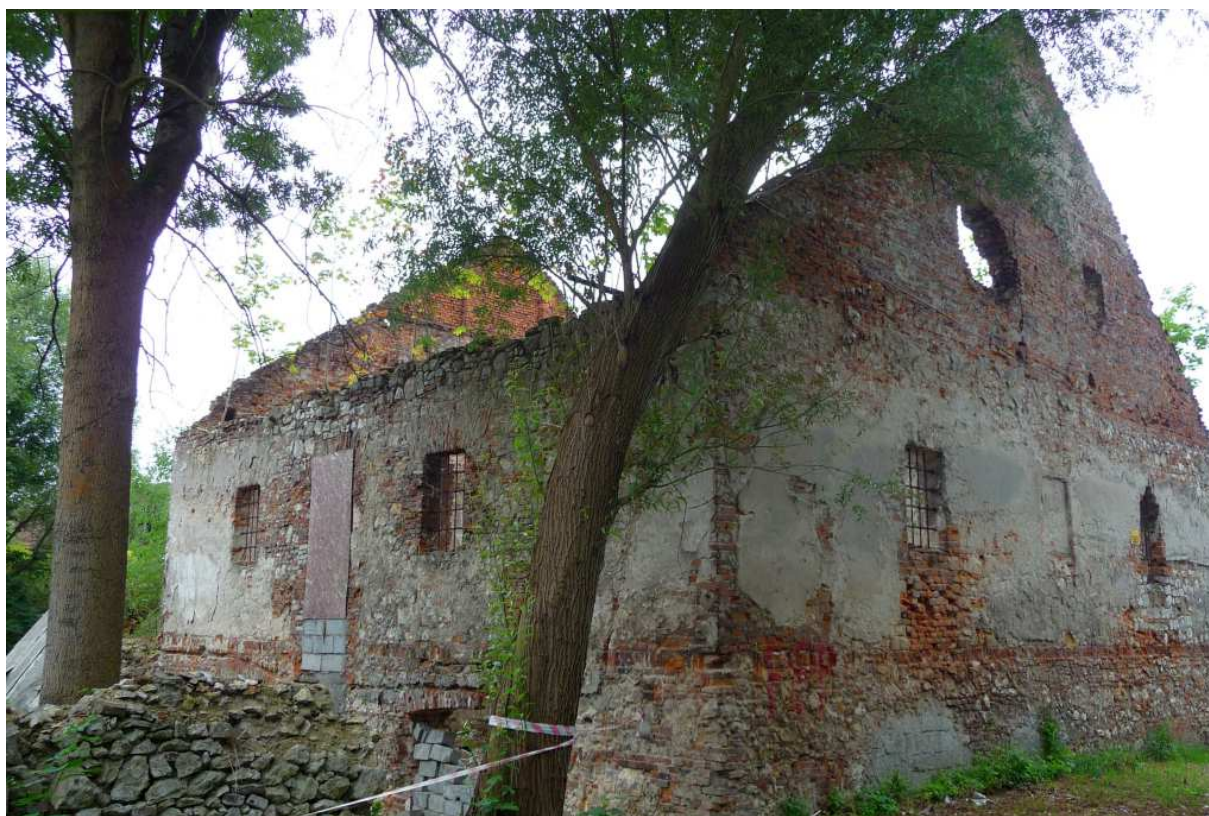
Fot. nr 137 (137-138). Budynek przylegający do drogi. (27.07.2025)
