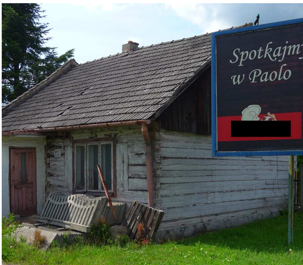
Fot. nr 153 (152-153). Widoki od strony podwórka. (29.07.2025)
