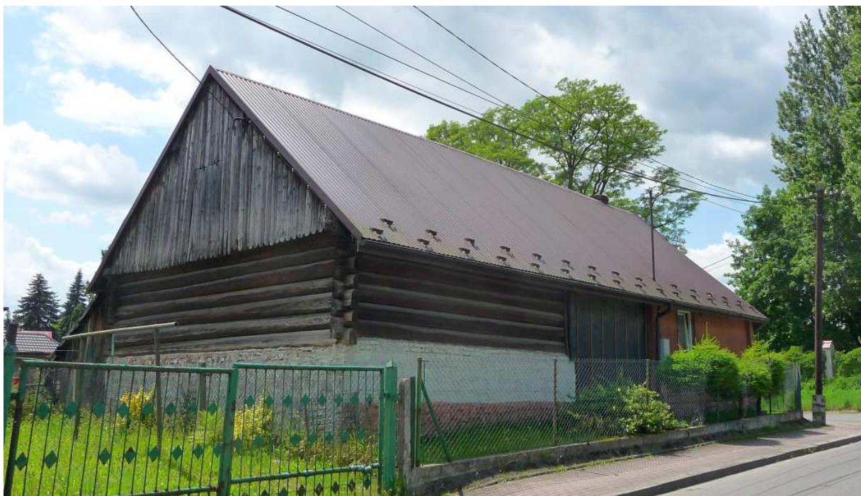
Fot. nr 28 (28-29). Tylna część od strony ulicy z oryginalnym narożnikiem o konstrukcji zrębowej. (24.06.2025)
