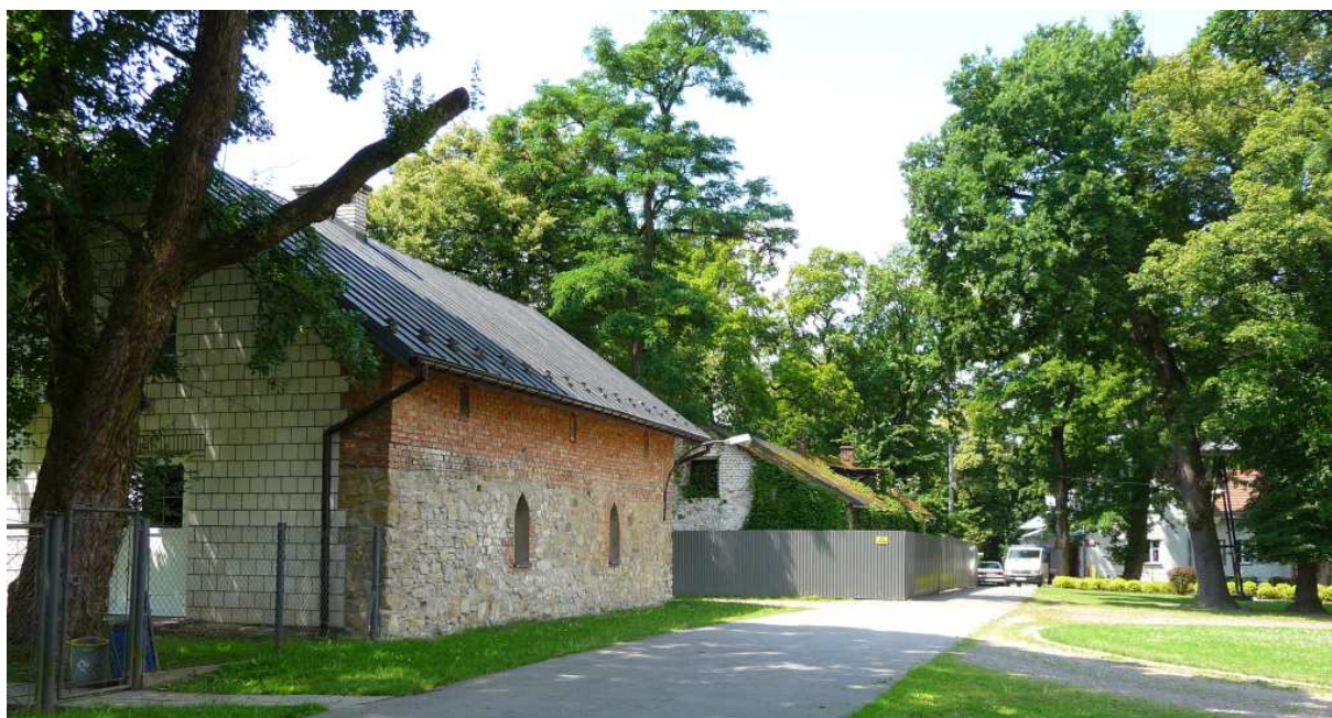
Fot. nr 350. Dawny budynek gospodarczy, z oryginalną ścianą zewnętrzną, wykonaną z kostki wapiennej, współcześnie przerobiony na garaż. (16.07.2025)
