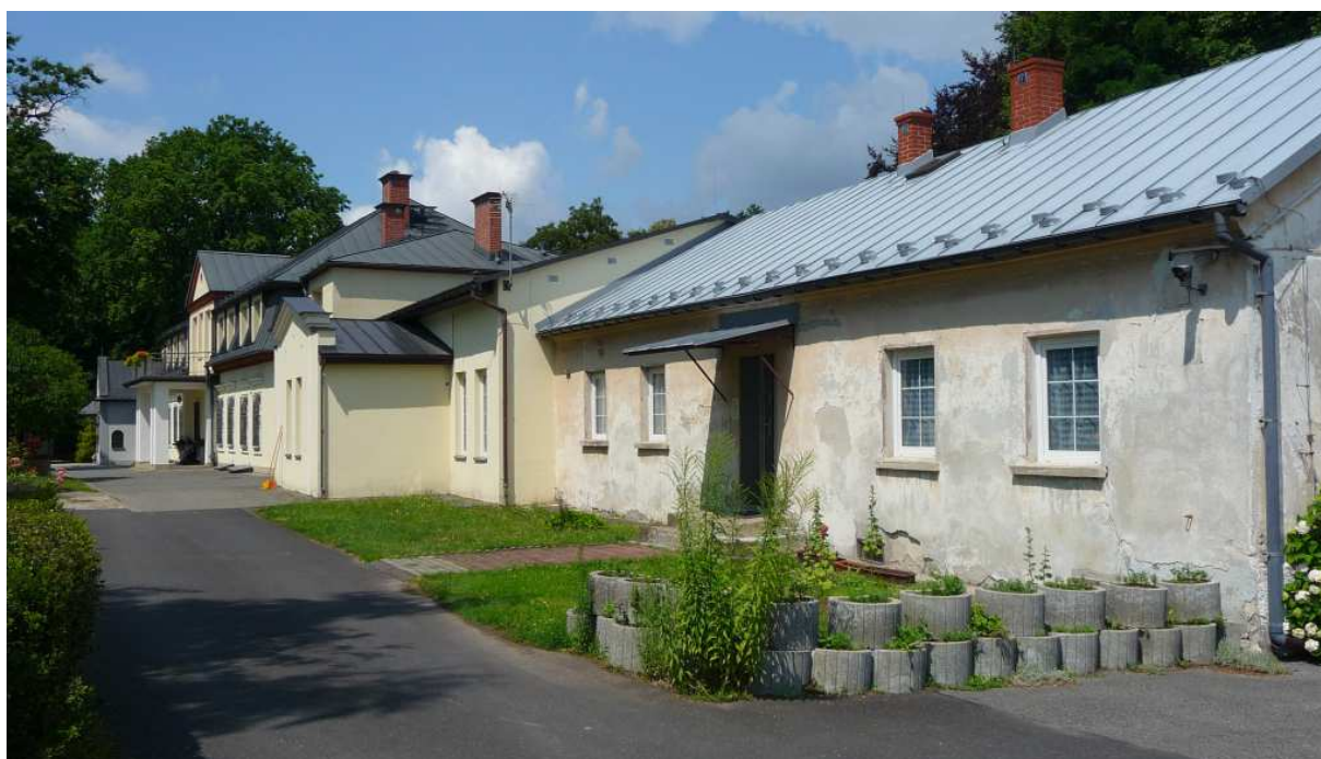
Fot. nr 348 (348-349). Fasada obiektu od strony dziedzińca. (16.07.2025)
