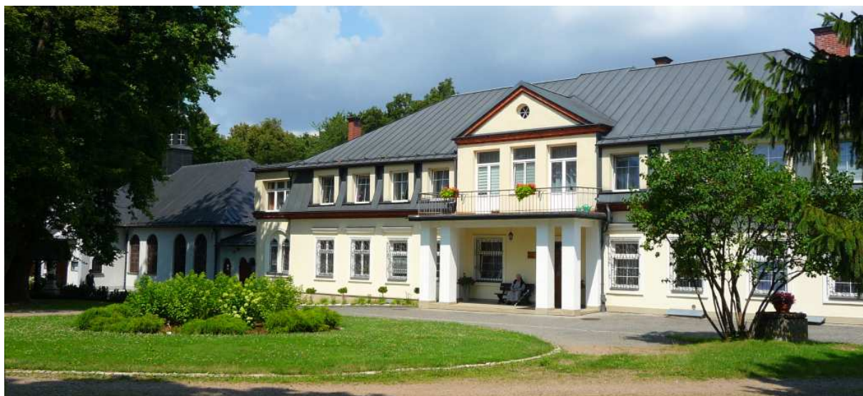
Fot. nr 349. Fasada z zatraconą już częściowo, pierwotną architekturą. (16.07.2025)
