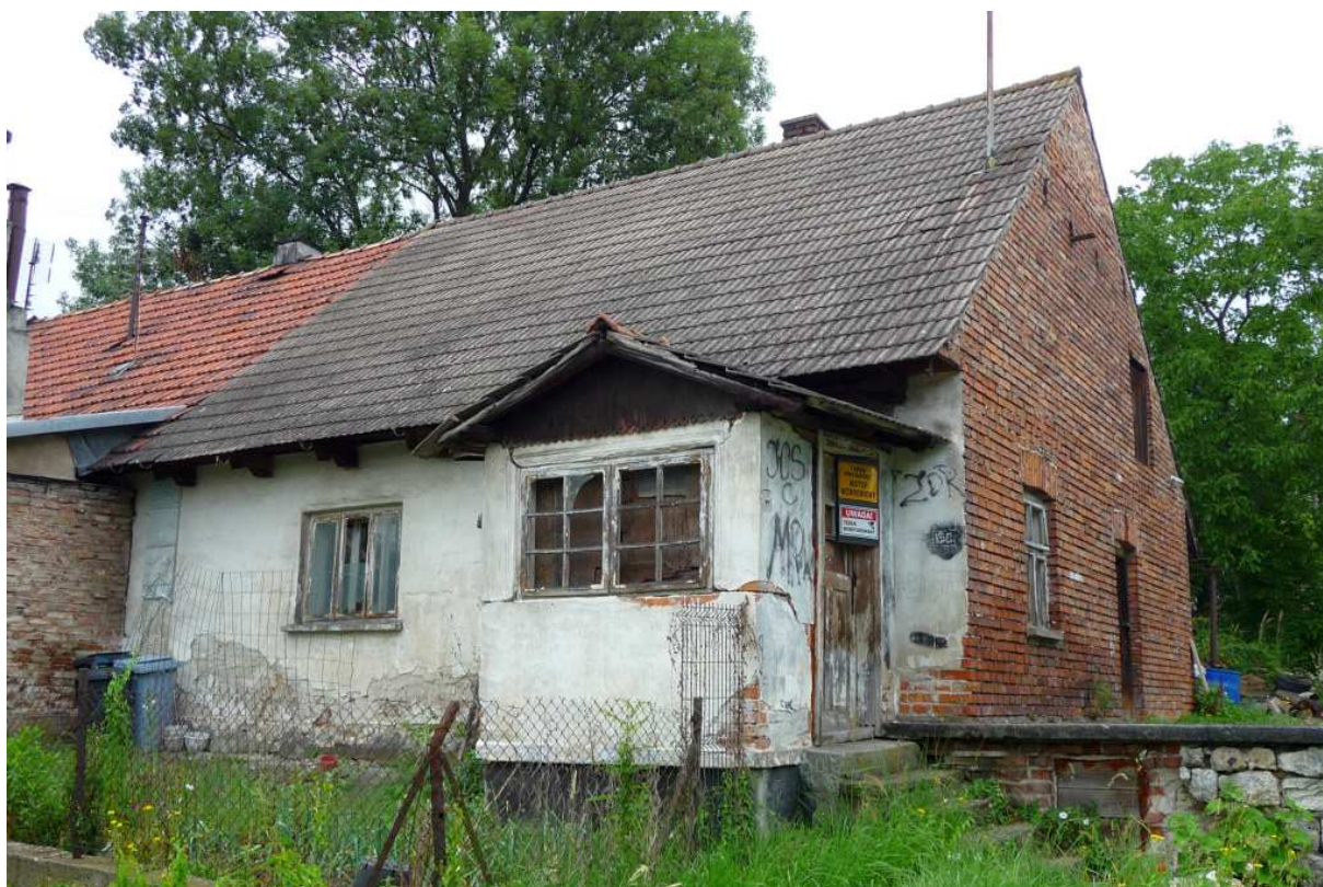
Fot. nr 88 (88-89). Fasada murowanego domu. (10.07.2025)
