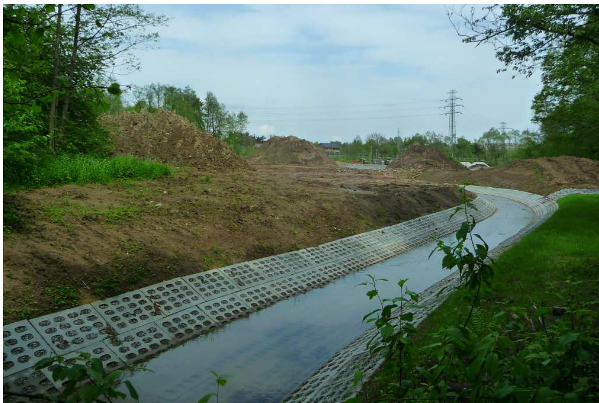
Fot. nr 202 (202-204). Malinówka w swym skanalizowanym korycie. Na styku Rżaki, Kosocic i Krzyszkowic powstaje przeciwpożarowy zbiornik retencyjny, który ma chronić przed nadmiernymi wezbrzeniami Serafę i zapobiegać podtapianiu Bieżanowa. (16.05.2023)
