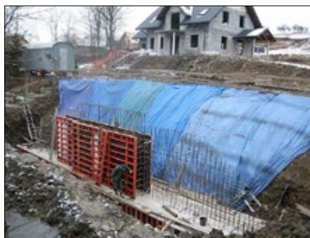
Budowa mostu w Zagorzynie
