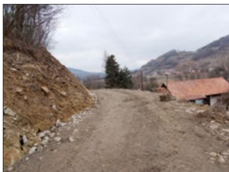
Rozbudowa drogi gminnej „Kluczniki” w Zabrzeży
