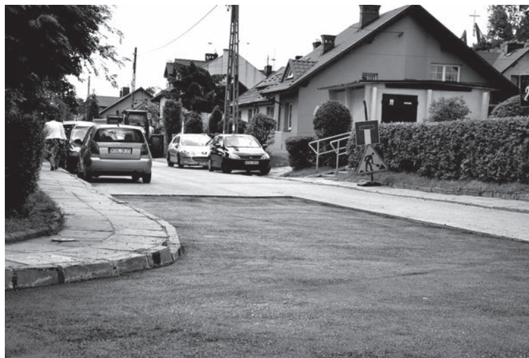
Prace kanalizacyjne prowadzone były na ul. Leśnej w Jaroszowcu.
