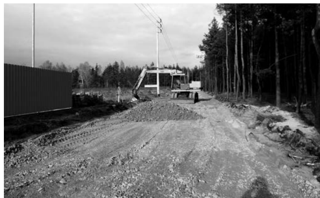
Droga tłuczniowa przebiega obok PSZOK, poza zabudową mieszkalną. W listopadzie trwała budowa drogi.
