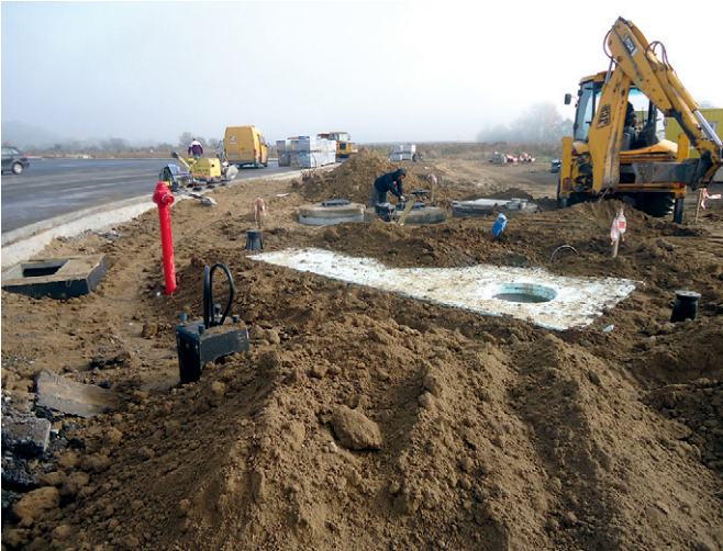
Budowa Strefy – listopad 2013
