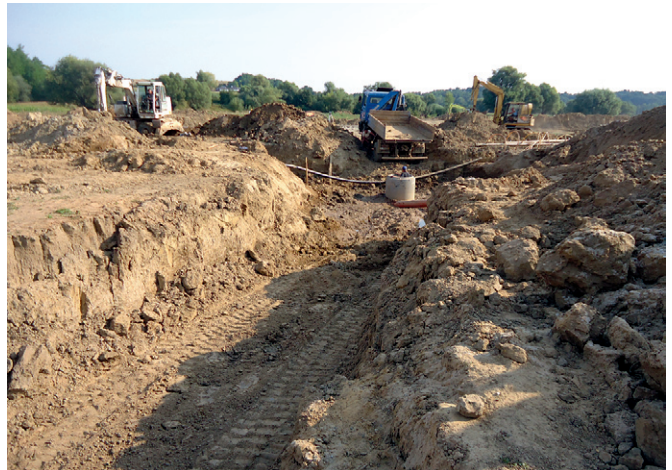
Budowa Strefy – sierpień 2013
