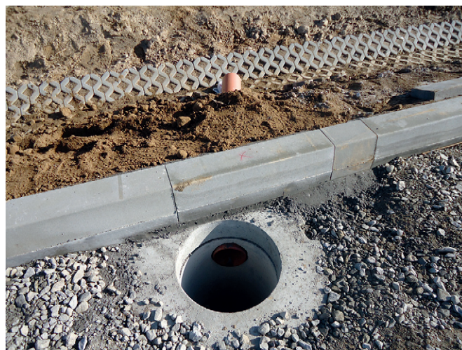
Budowa Strefy – wrzesień 2013
