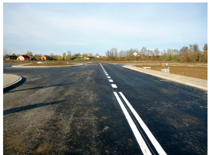
Budowa Strefy – listopad 2013
