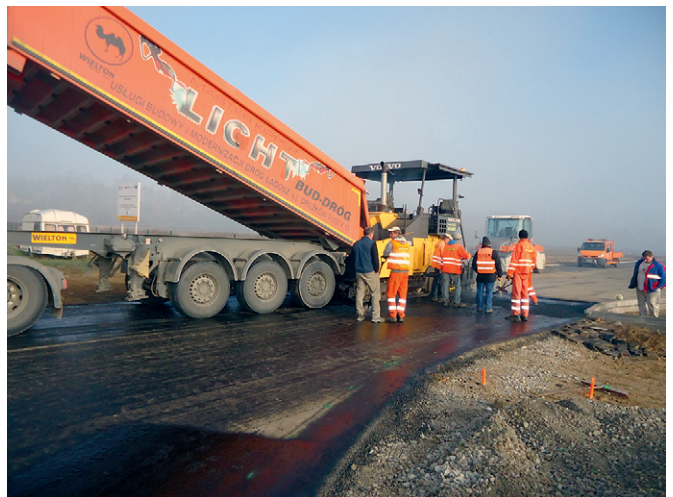
Budowa Strefy – listopad 2013
