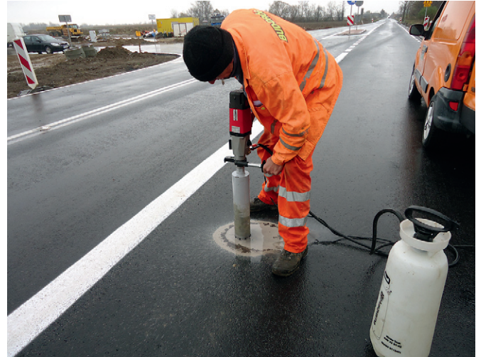
Budowa Strefy – listopad 2013
