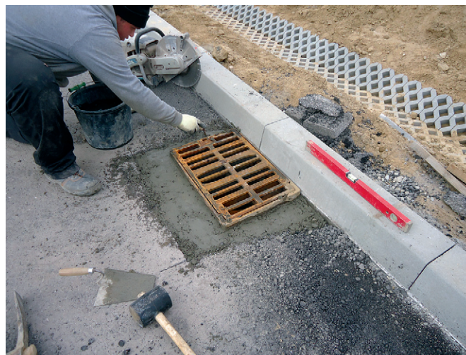
Budowa Strefy – październik 2013
