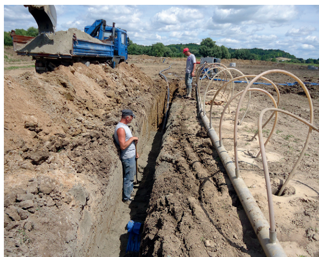
Budowa Strefy – lipiec 2013
