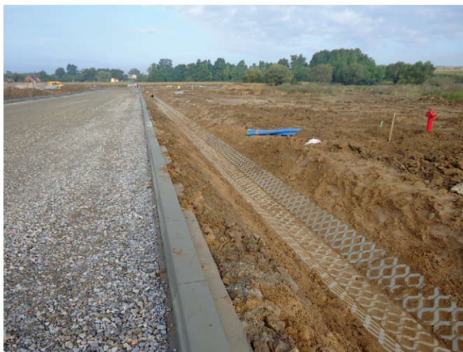
Budowa Strefy – wrzesień 2013
