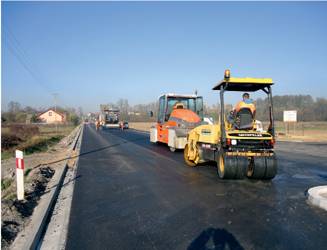
Budowa Strefy – listopad 2013
