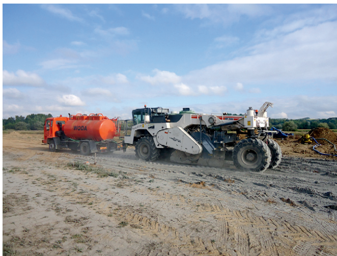
Budowa Strefy – sierpień 2013
