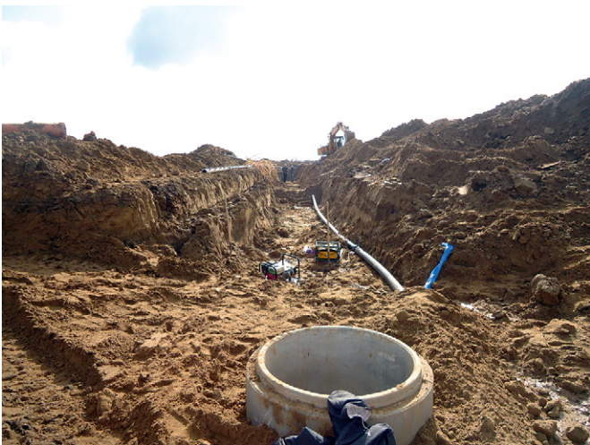
Budowa Strefy – sierpień 2013
