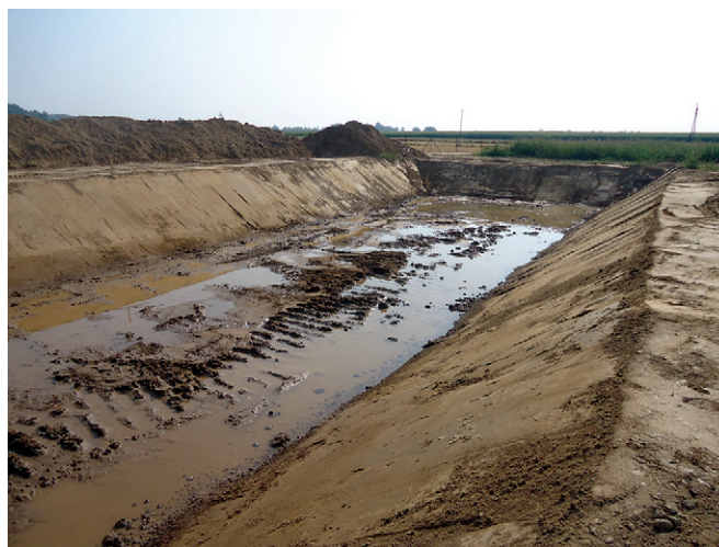
Budowa Strefy – lipiec 2013
