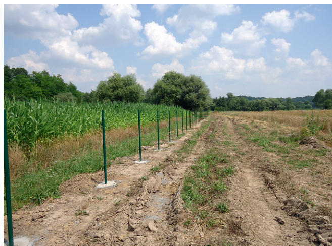
Budowa Strefy – lipiec 2013
