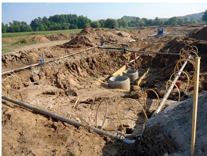
Budowa Strefy – lipiec 2013
