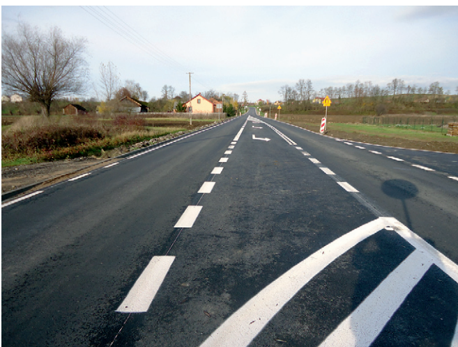
Budowa Strefy – listopad 2013
