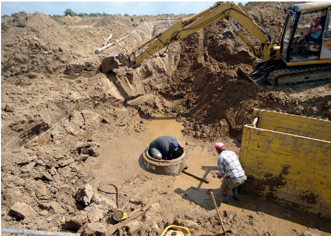
Budowa Strefy – sierpień 2013
