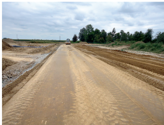
Budowa Strefy – sierpień 2013
