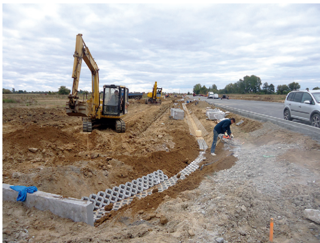
Budowa Strefy – październik 2013
