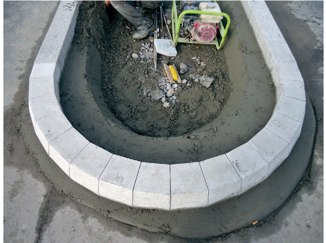
Budowa Strefy – listopad 2013
