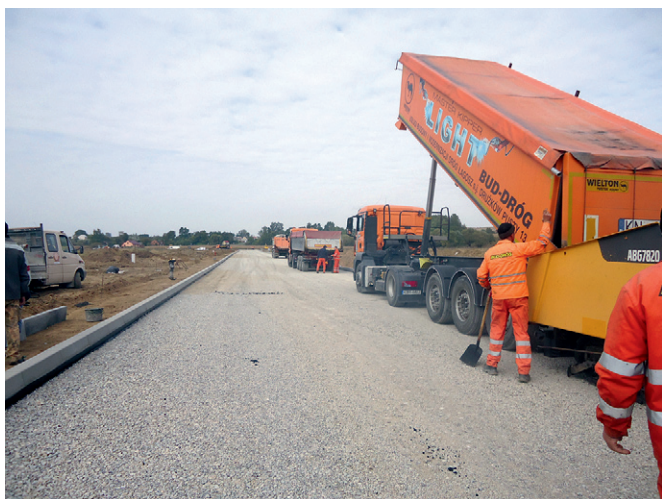
Budowa Strefy – październik 2013
