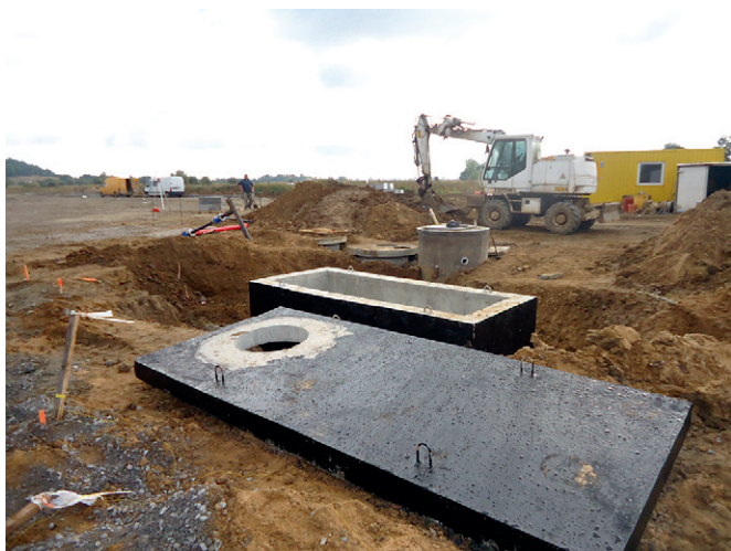
Budowa Strefy – wrzesień 2013
