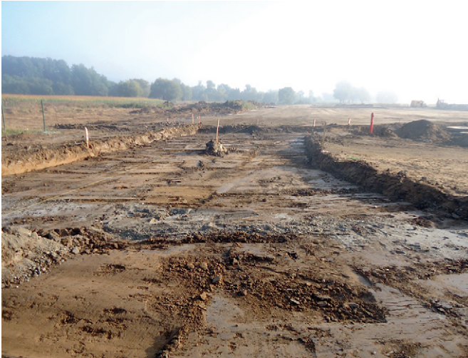
Budowa Strefy – wrzesień 2013
