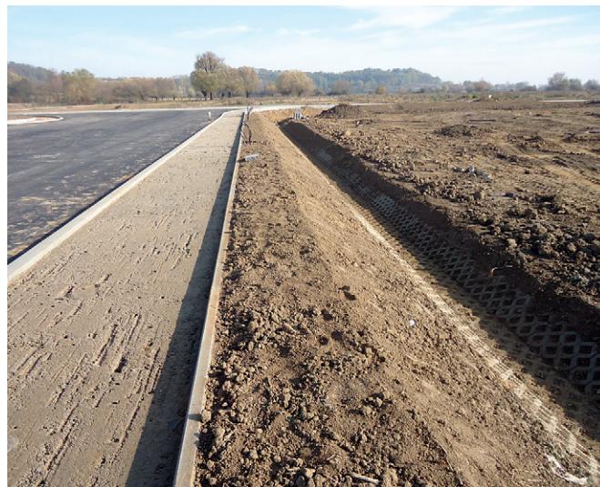
Budowa Strefy – październik 2013
