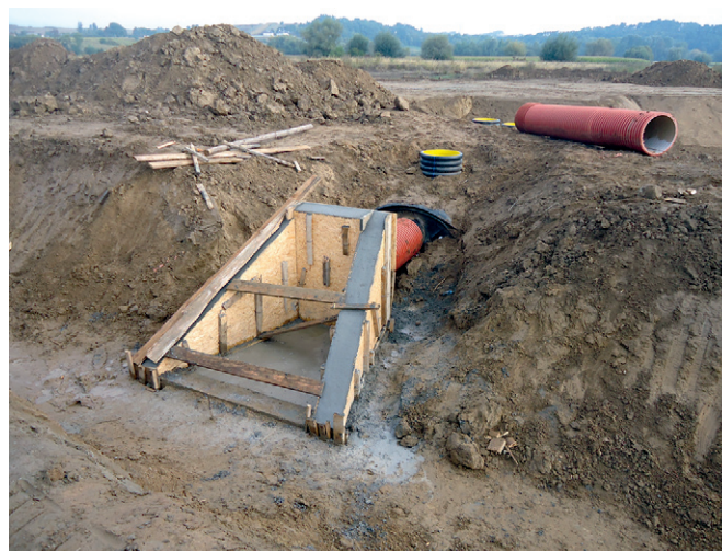
Budowa Strefy – wrzesień 2013
