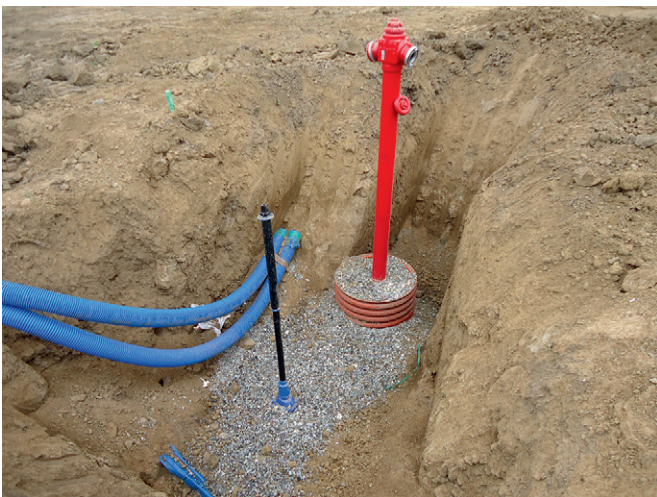
Budowa Strefy – wrzesień 2013
