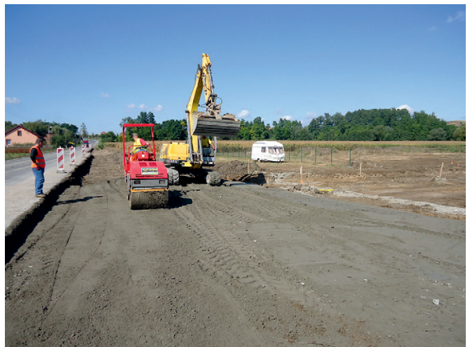
Budowa Strefy – wrzesień 2013
