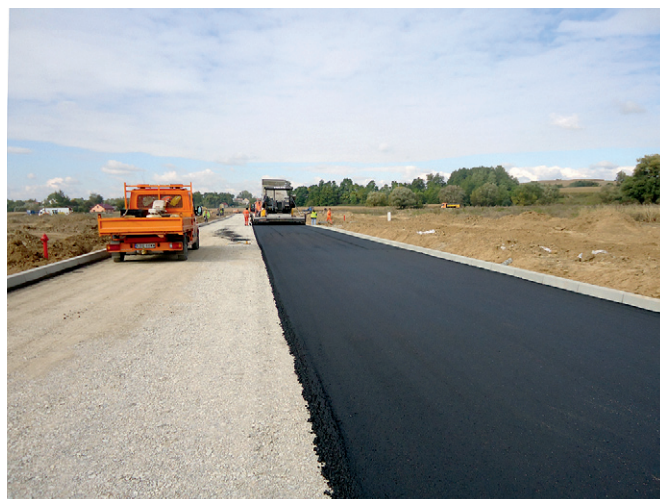
Budowa Strefy – październik 2013
