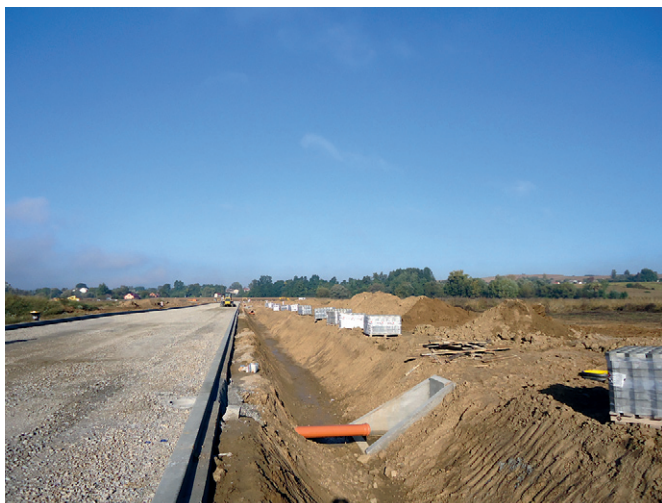
Budowa Strefy – październik 2013
