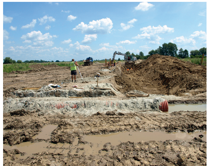
Budowa Strefy – lipiec 2013
