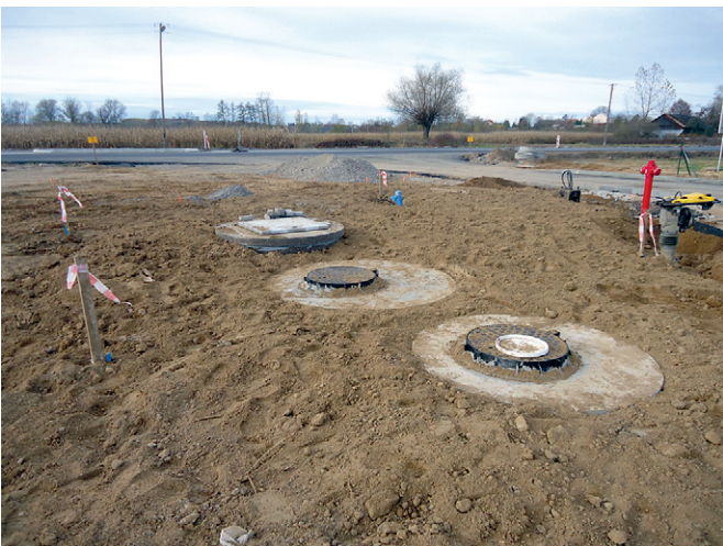
Budowa Strefy – listopad 2013
