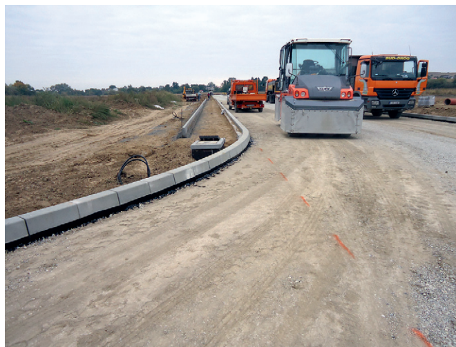
Budowa Strefy – październik 2013
