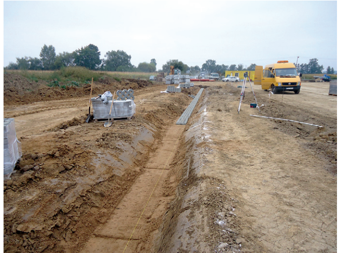
Budowa Strefy – wrzesień 2013
