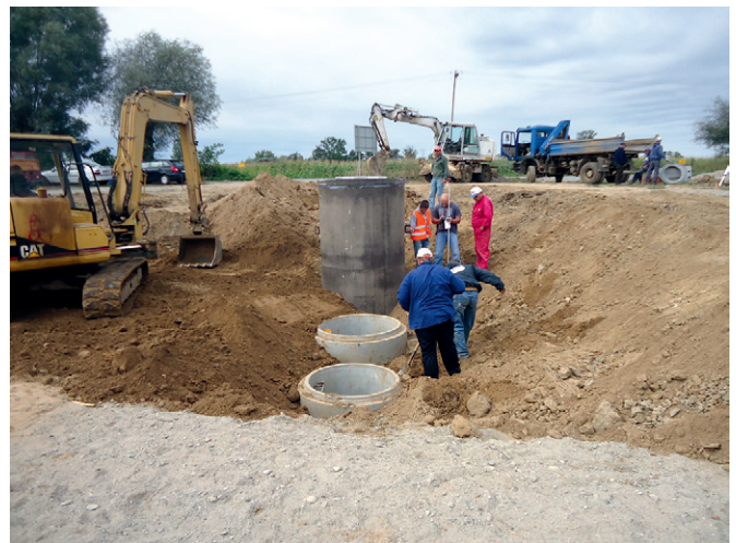
Budowa Strefy – sierpień 2013
