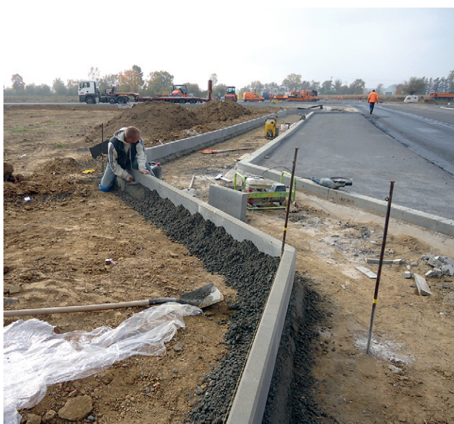
Budowa Strefy – październik 2013
