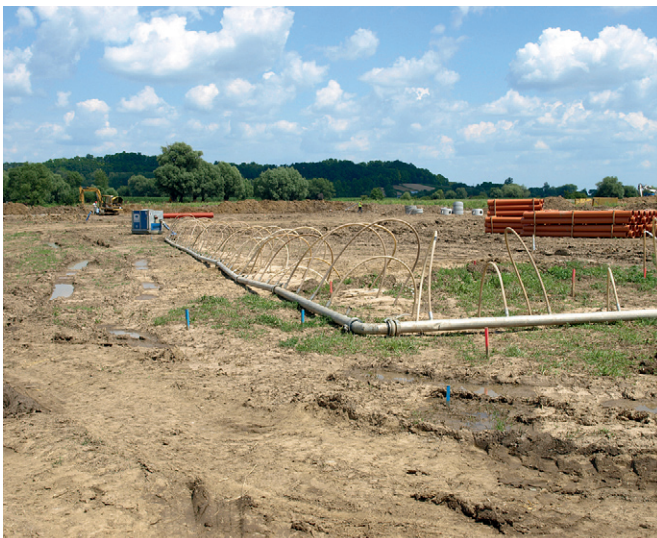
Budowa Strefy – lipiec 2013
