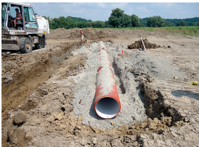
Budowa Strefy – lipiec 2013
