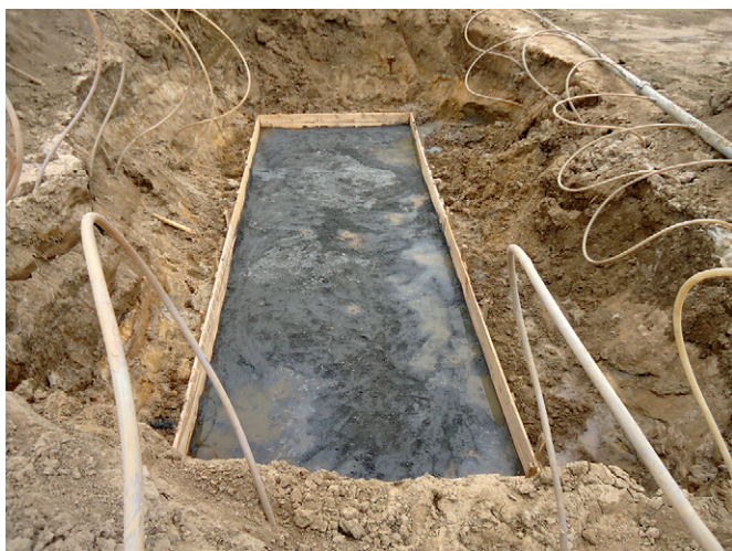
Budowa Strefy – sierpień 2013
