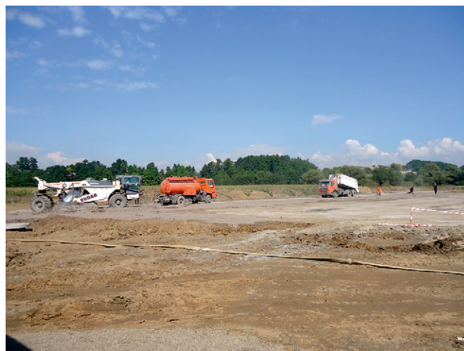
Budowa Strefy – sierpień 2013
